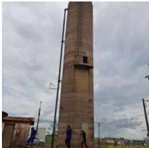
Foto 6 - Vista do reservatório elevado.
