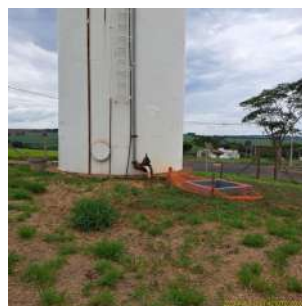
Foto 2 - Vista geral do reservatório R34.
