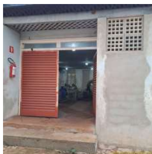
Foto 2 - Vista da entrada da EEAT.
