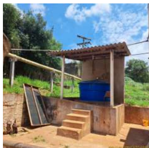
Foto 1 - Abrigo do tanque de hipoclorito, ao lado do reservatório R23.
