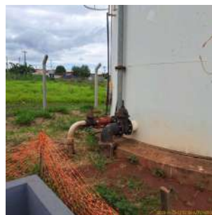
Foto 4 - Vista da base do reservatório.
