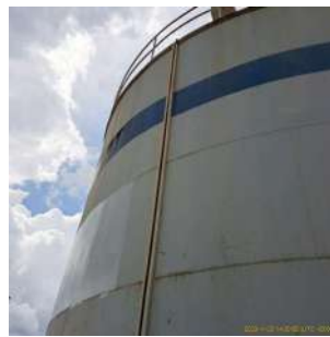
Foto 2 - Régua na lateral do reservatório.
