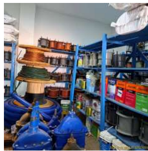
Foto 14 - Novo estoque de peças e equipamentos hidráulicos em área contígua à ETA.
