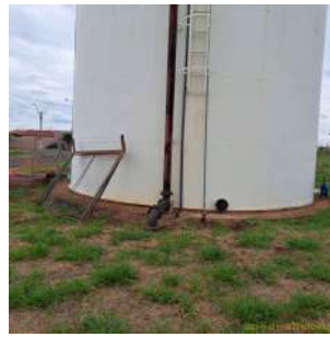
Foto 4 - Vista geral do reservatório R32.
