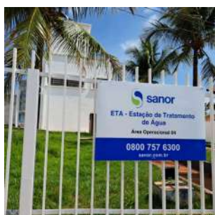
Foto 1 - Identificação da ETA.
