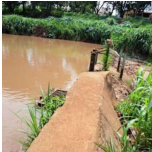
Foto 5 - Crista da barragem de captação.
