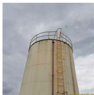
Foto 2 - Vista geral do reservatório.
