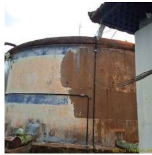
Foto 6 - Vista geral do reservatório apoiado.
