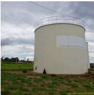
Foto 1 - Vista geral do reservatório R33.
