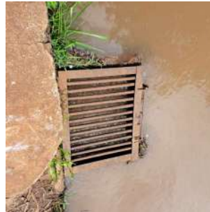
Foto 6 - Entrada d'água a montante da barragem.
