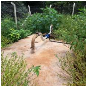
Foto 2 - Vista interna da área do poço.
