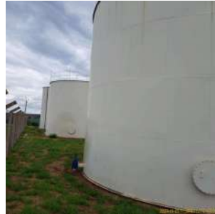
Foto 6 - Vista geral do reservatório R32.
