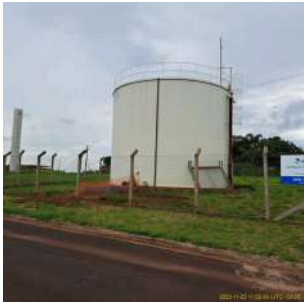
Foto 2 - Vista geral do reservatório R32.
