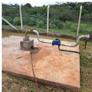
Foto 2 - Vista geral do poço P6.
