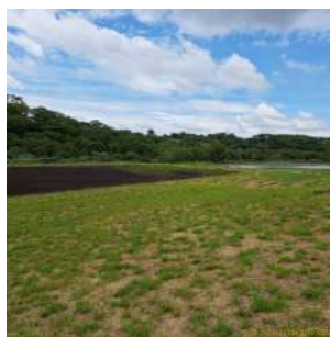
Foto 10 - Vista geral das lagoas 1 (anaeróbia - à esquerda) e da lagoa 2 (facultativa - à direita).
