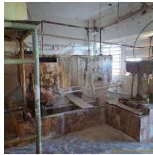
Foto 2 - Situação atual da sala de preparo de produtos químicos.
