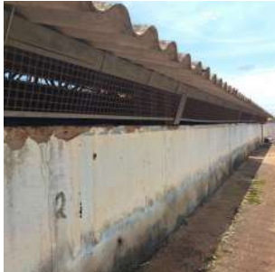
Foto 3 - Vista da lateral do reservatório.
