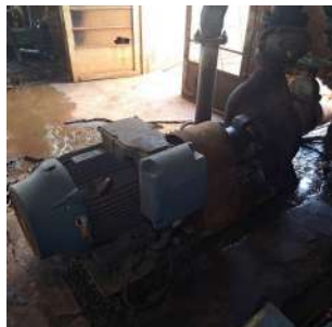
Foto 1 - Drenagem inadequada da água de lubrificação das gaxetas do conjunto 1.
