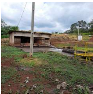
Foto 7 - Vista geral da área da elevatória de esgoto.
