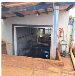
Foto 1 - Entrada da EEAT.
