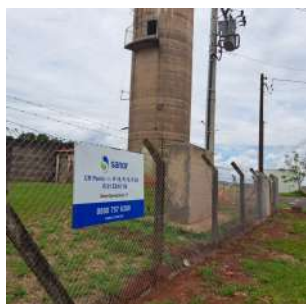
Foto 1 - Vista do reservatório elevado e da placa de identificação da área.
