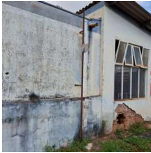
Foto 1 - Régua na lateral do reservatório.
