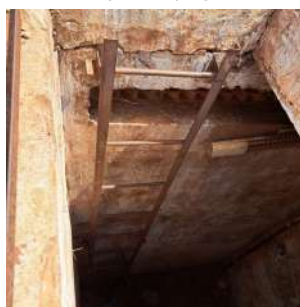
Foto 6 - Escada marinheiro para acesso ao poço da EEAT 4.
