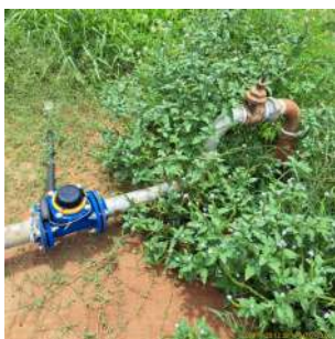
Foto 3 - Vista de parte do cavalete do poço.
