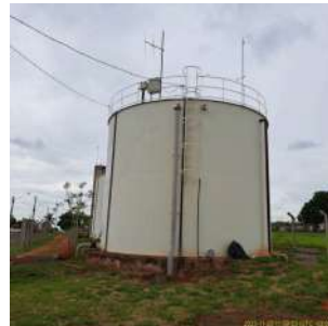
Foto 5 - Vista geral do reservatório R33 (com o R32 ao fundo).
