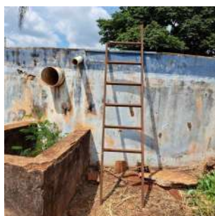
Foto 1 - Escada de acesso à cobertura do reservatório.
