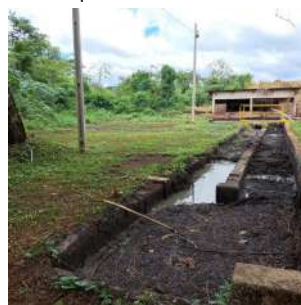
Foto 6 - Caixa desarenadora da elevatória.
