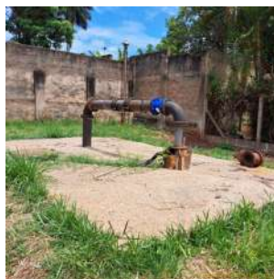
Foto 2 - Vista geral do poço P5.
