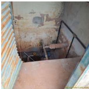
Foto 1 - Detalhe do patamar de entrada (nível do terreno) da EEAT, antes do acesso para o piso inferior onde estão os conjuntos motobomba.
