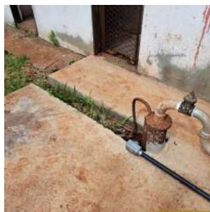
Foto 4 - Poço P12 e abertura na laje de proteção.
