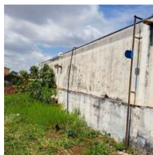
Foto 2 - Vista da lateral do reservatório.
