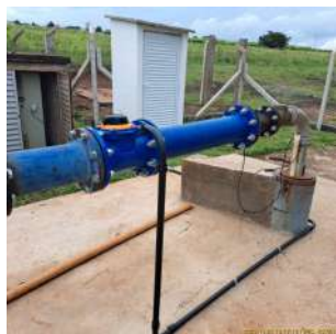
Foto 5 - Vista geral do poço P11.
