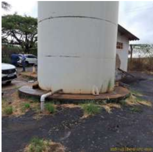
Foto 4 - Vista da base do reservatório.
