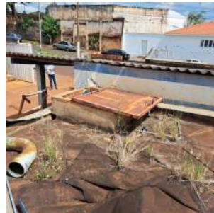
Foto 6 - Vista da cobertura e de uma das tampas de inspeção.
