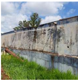
Foto 3 - Vista da lateral do reservatório.
