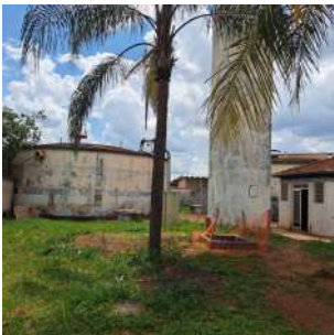
Foto 3 - Vista do CR Caixa Torre, com base do reservatório elevado R4, reservatório apoiado R3.
