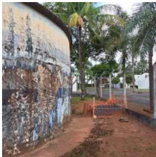
Foto 5 - Vista lateral do reservatório R2.
