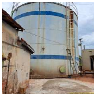
Foto 2 - Vista lateral do reservatório R26.
