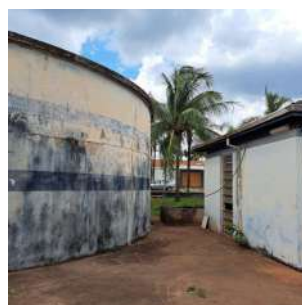
Foto 2 - Vista do reservatório R1 e da EEAT 3.
