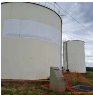
Foto 3 - Vista geral do reservatório R33 (com o R34 ao fundo).
