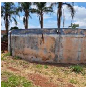
Foto 1 - Vista do reservatório apoiado.
