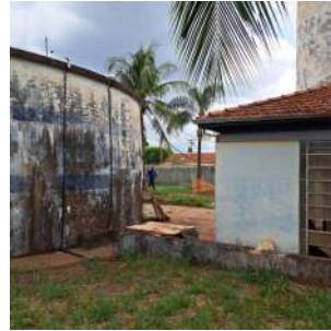
Foto 2 - Vista lateral do reservatório R2 e da EEAT 3.
