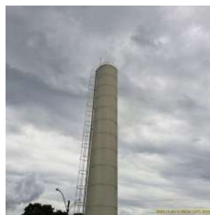
Foto 2 - Vista geral do reservatório elevado.
