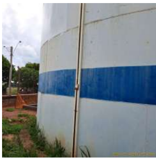
Foto 1 - Régua na lateral do reservatório.
