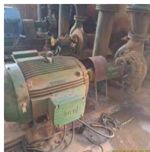
Foto 2 - Primeiro conjunto motobomba.
