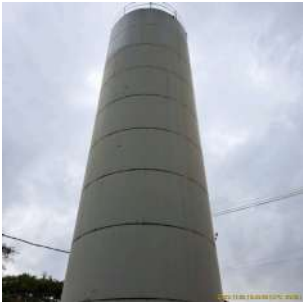
Foto 3 - Vista geral do reservatório.
