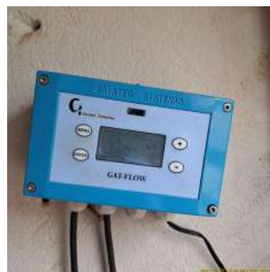
Foto 3 - Visor de indicação da vazão captada.
