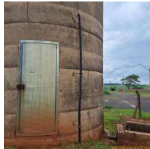
Foto 7 - Vista da base do reservatório elevado.
