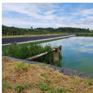
Foto 18 - Vista da lagoa 1 (anaeróbia) da segunda sequência de lagoas, com nível abaixo do operacional.
