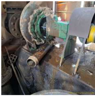
Foto 3 - Drenagem inadequada da água de lubrificação das gaxetas.
