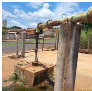
Foto 1 - Vista do poço P1 e da tubulação de abastecimento do reservatório R23.
