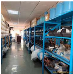
Foto 13 - Novo estoque de peças e equipamentos hidráulicos em área contígua à ETA.
