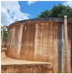
Foto 1 - Vista geral do reservatório R23.
