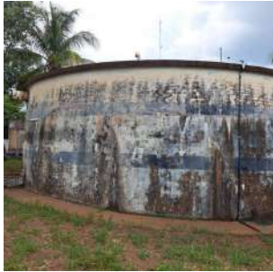
Foto 1 - Vista lateral do reservatório R2.
