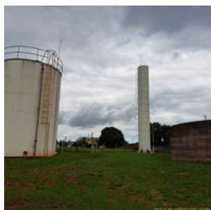
Foto 5 - Vista geral do reservatório elevado ao fundo e do R20 (apoiado) à esquerda.
