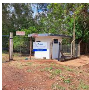
Foto 1 - Identificação da área na portaria da ETE.
