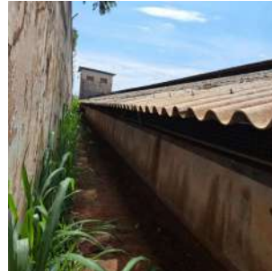
Foto 4 - Vista da lateral do reservatório.
