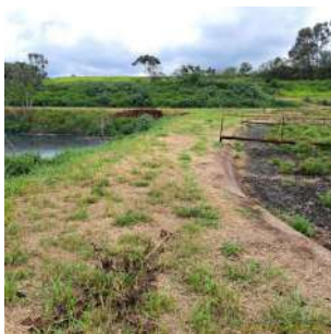
Foto 5 - Divisão entre as lagoas 1 (anaeróbia) e 2 (facultativa) da primeira sequência.
