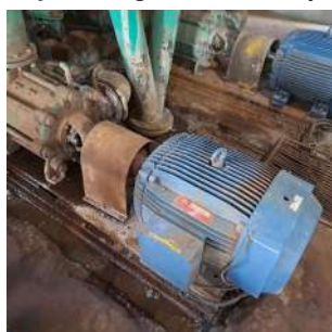
Foto 3 - Drenagem inadequada da água de lubrificação das gaxetas do conjunto central.
