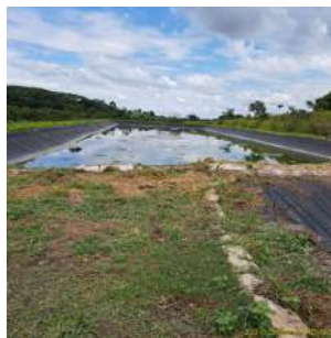
Foto 21 - Vista da lagoa 2 (facultativa) da segunda sequência de lagoas, com nível abaixo do operacional.
