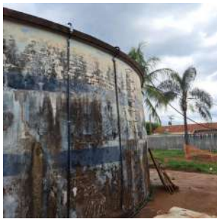
Foto 1 - Escada em situação inadequada, além de não possuir guarda-corpo.
