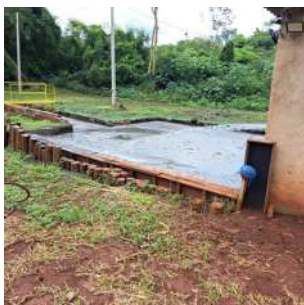
Foto 1 - Poço/tanque de chegada de esgoto bruto e de sucção da elevatória.
