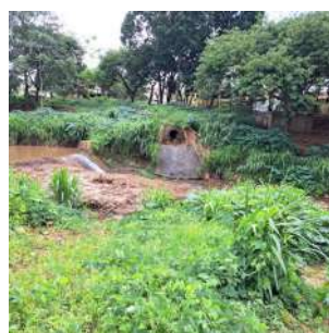
Foto 2 - Vista geral da área de captação.
