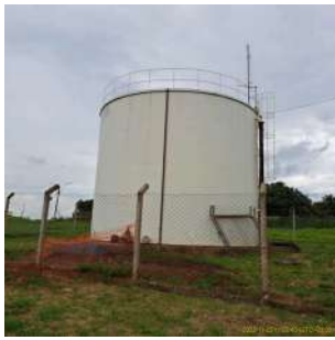
Foto 3 - Vista geral do reservatório R32.
