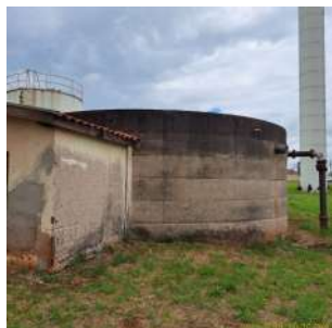
Foto 1 - Vista do reservatório apoiado e, a frente, parte da EEAT 8.
