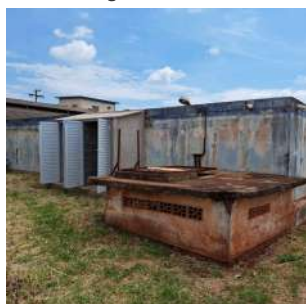
Foto 3 - Vista geral do reservatório R7.
