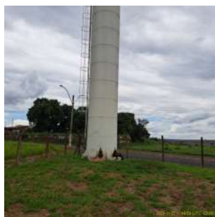
Foto 1 - Vista geral do reservatório elevado.
