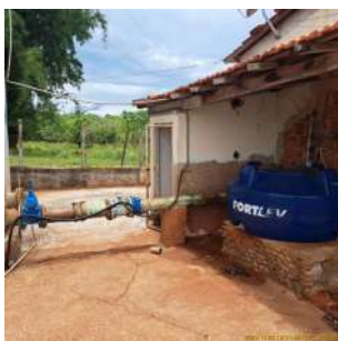
Foto 1 - Abrigo do tanque de hipoclorito, ao lado do reservatório R26.
