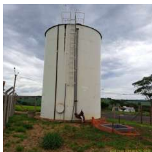
Foto 1 - Vista geral do reservatório R34.
