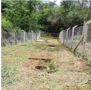
Foto 3 - Vista interna da área do poço.
