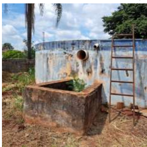
Foto 3 - Vista do reservatório apoiado e do tubo extravasor.
