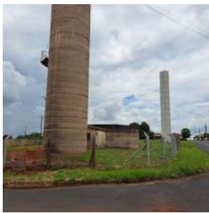
Foto 4 - Vista do reservatório elevado.
