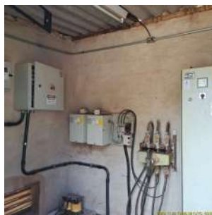
Foto 4 - Painéis do poço P5.
