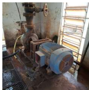
Foto 2 - Primeiro conjunto motobomba.
