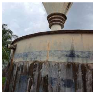
Foto 3 - Vista do reservatório R1 e do reservatório elevado ao fundo.
