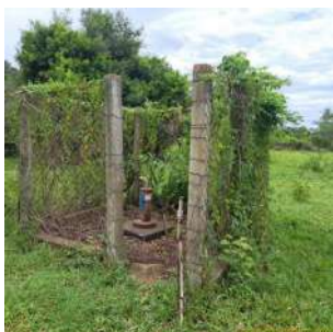
Foto 3 - Vista geral da área do P9.
