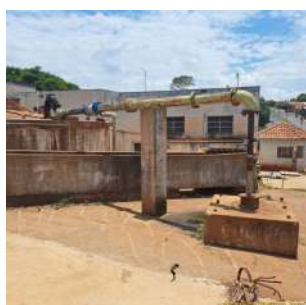
Foto 3 - Poço P1 (esquerda) e reservatório R23 (direita)).
