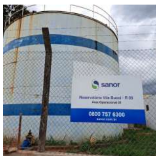
Foto 1 - Vista do reservatório e da identificação da área.
