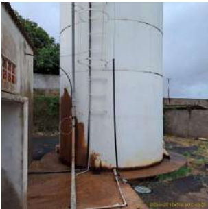
Foto 1 - Vista da área do reservatório.
