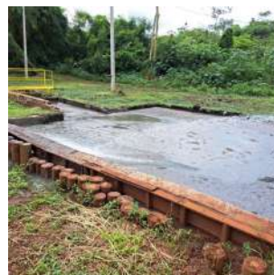
Foto 2 - Poço/tanque de chegada de esgoto bruto e de sucção da elevatória. Detalhe da situação da lateral esquerda, com contenção.
