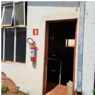
Foto 8 - Entrada lateral da EEAT.
