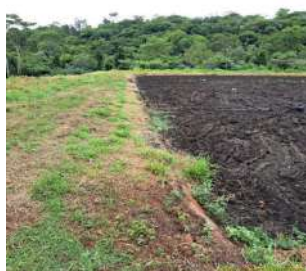
Foto 3 - Margem da lagoa com a chegada das tubulações de esgoto bruto, onde há caixas de tubulação sem tampa.
