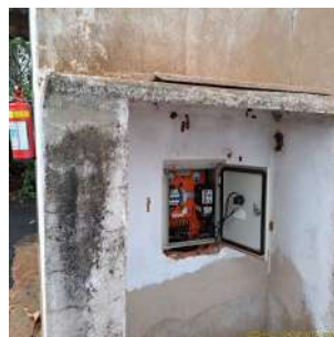
Foto 4 - Vista do painel elétrico do poço.
