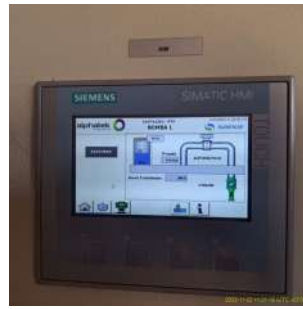
Foto 2 - Visualizador de nível do reservatório.
