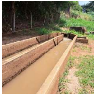
Foto 8 - Caixa desarenadora já na área da EEAB.
