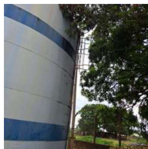
Foto 4 - Vista lateral do reservatório.
