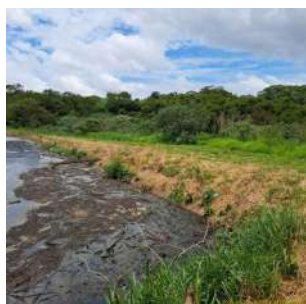
Foto 1 - Situação do capim e demais vegetações na margem da lagoa onde há tubulação de saída do efluente tratado, dificultando o acesso ao local.
