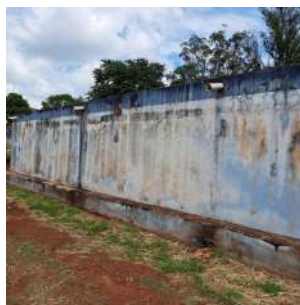
Foto 2 - Vista geral do reservatório R7.
