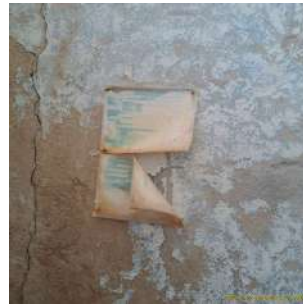
Foto 2 - Ausência de identificação adequada do produtos químico no local (hipoclorito, no caso da foto).
