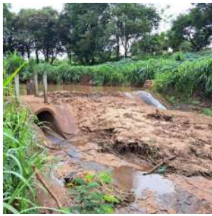
Foto 3 - Vista geral da represa do Córrego dos Palmitos.
