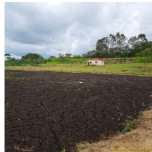
Foto 2 - Vista da lagoa 1 (anaeróbia) da primeira sequência de tramento.
