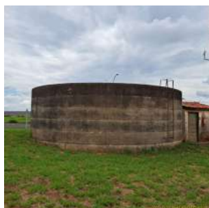
Foto 3 - Vista do reservatório apoiado.
