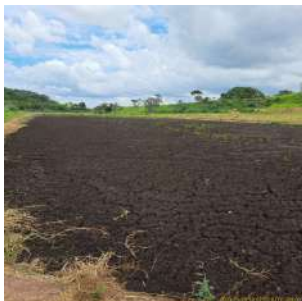
Foto 3 - Vista da lagoa 1 (anaeróbia) da primeira sequência de tramento.
