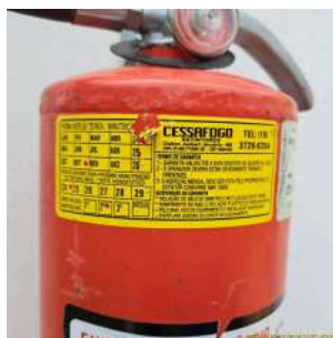
Foto 2 - Validade do extintor de incêndio vigente.
