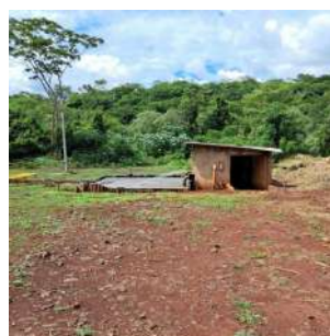
Foto 2 - Vista geral do poço de chegada do esgoto bruto e do abrigo das motobombas autoescorvantes
