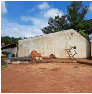
Foto 1 - Vista frontal do reservatório R5.
