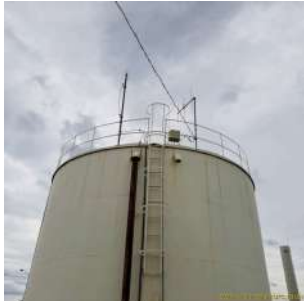
Foto 5 - Vista geral do reservatório R32.
