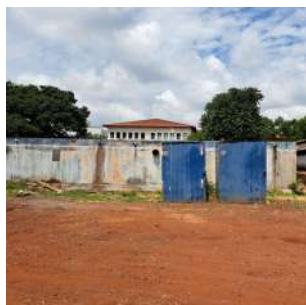
Foto 1 - Vista geral do reservatório R7.
