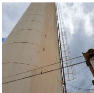
Foto 5 - Vista do reservatório elevado.
