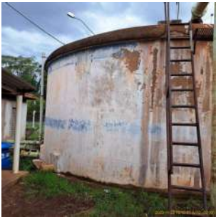
Foto 1 - Vista geral do reservatório apoiado.
