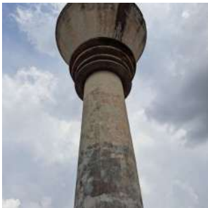
Foto 4 - Fio condutor de descida do SPDA.
