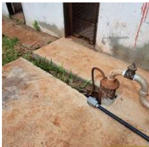
Foto 1 - Valeta na laje de proteção do poço.
