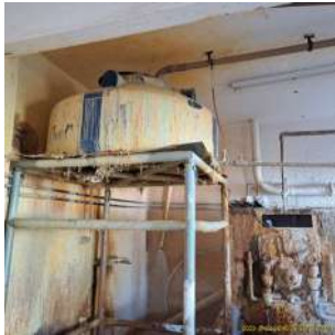
Foto 3 - Situação atual da sala de preparo de produtos químicos.
