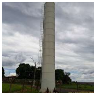
Foto 3 - Vista geral do reservatório elevado.
