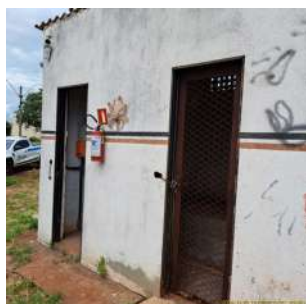
Foto 1 - Extintor de incêndio.
