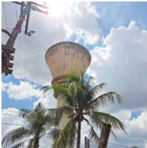
Foto 2 - Vista do reservatório elevado.
