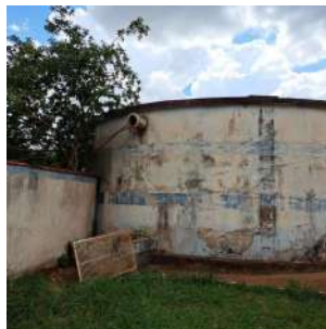
Foto 2 - Vista do reservatório R3.
