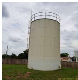
Foto 4 - Vista geral do reservatório.
