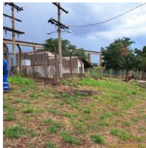
Foto 2 - Vista geral da área do poço P6.
