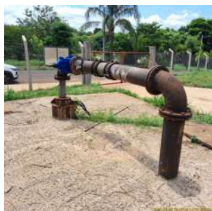
Foto 3 - Vista geral do poço P5.
