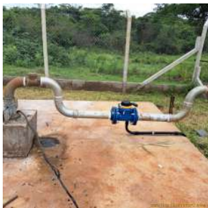
Foto 3 - Vista geral do poço P6.
