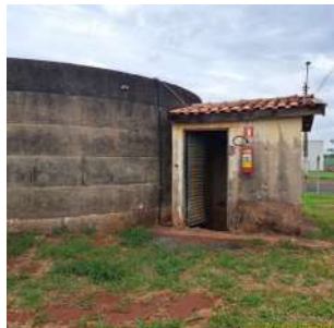
Foto 1 - Vista da estrada da EEAT 8.
