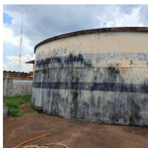
Foto 1 - Vista do reservatório R1.
