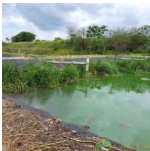
Foto 20 - Vista da lagoa 1 (anaeróbia) da segunda sequência de lagoas, com nível abaixo do operacional.
