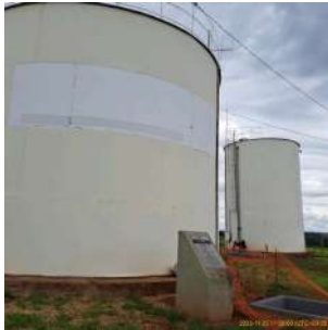
Foto 1 - Ausência de tampa ou outra proteção antiqueda no poço do macromedidor.
