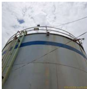
Foto 5 - Vista da cobertura do reservatório.
