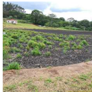
Foto 4 - Vista da lagoa 1 (anaeróbia) da primeira sequência de tramento.
