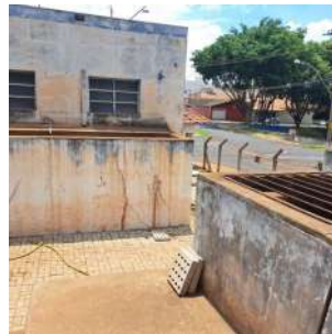
Foto 11 - Tanque de equalização ao lado da EEAB.
