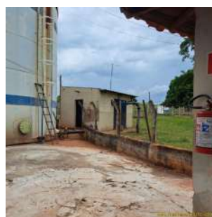
Foto 9 - Reservatório R26 (esquerda) e nova EEAT 6 (direita).
