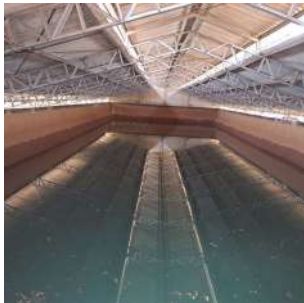
Foto 5 - Vista interna do reservatório.
