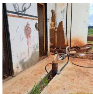
Foto 2 - Poço e Reservatório elevado ao fundo.
