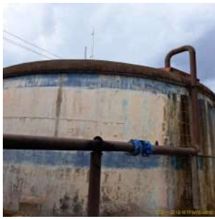
Foto 5 - Vista geral do reservatório apoiado.
