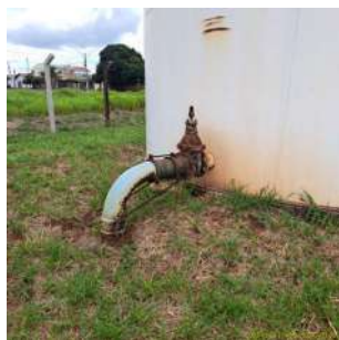
Foto 3 - Vista geral do reservatório.
