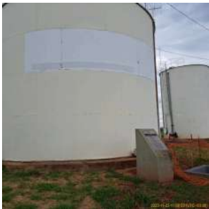
Foto 2 - Vista geral do reservatório R33.
