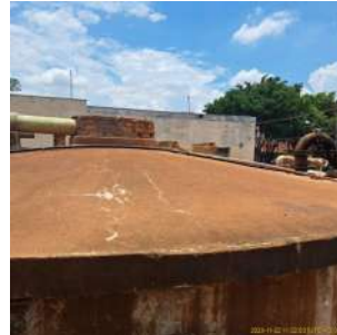
Foto 4 - Cobertura do reservatório R23.
