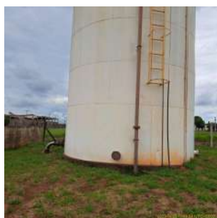
Foto 1 - Vista da base do reservatório.
