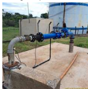
Foto 4 - Vista geral do poço P11.
