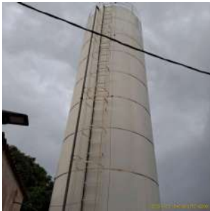
Foto 2 - Vista geral base do reservatório.
