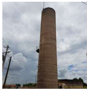
Foto 5 - Vista do reservatório elevado.
