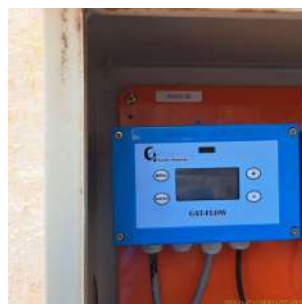
Foto 2 - Painel de visualização da vazão do poço.
