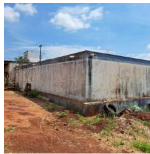
Foto 4 - Vista da lateral do reservatório.
