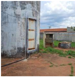
Foto 5 - Entrada da base do reservatório elevado.
