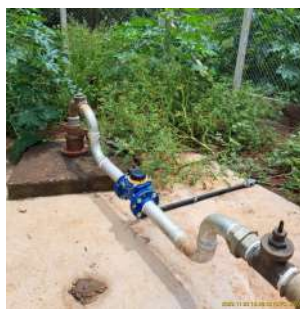
Foto 3 - Vista geral do poço P8.
