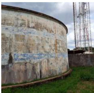
Foto 3 - Vista do reservatório R3.
