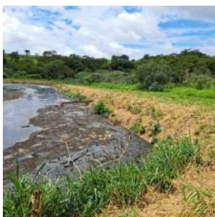
Foto 9 - Vista da parte final da lagoa 2 (facultativa), de onde sai a tubulação de lançamento do efluente para o Ribeirão dos Agudos.
