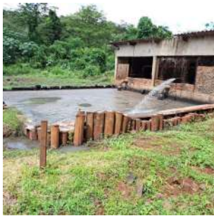
Foto 3 - Poço/tanque de chegada de esgoto bruto e de sucção da elevatória.
