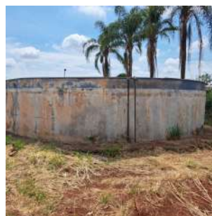
Foto 2 - Vista do reservatório apoiado.
