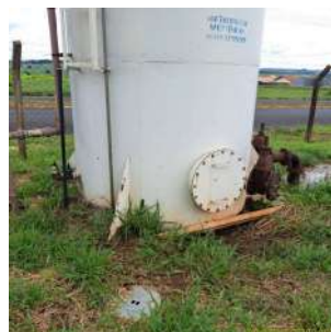
Foto 4 - Base do reservatório elevado.
