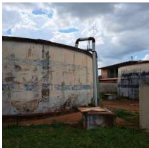
Foto 1 - Vista do reservatório R3.
