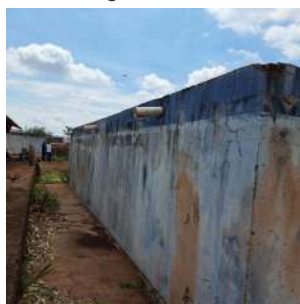
Foto 4 - Vista geral do reservatório R7.
