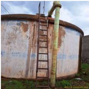
Foto 2 - Vista geral do reservatório apoiado.
