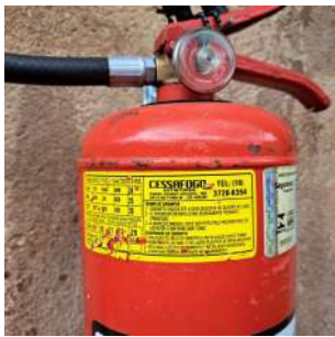
Foto 1 - Validade do extintor de incêndio vigente.
