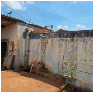
Foto 5 - Vista da lateral do reservatório.
