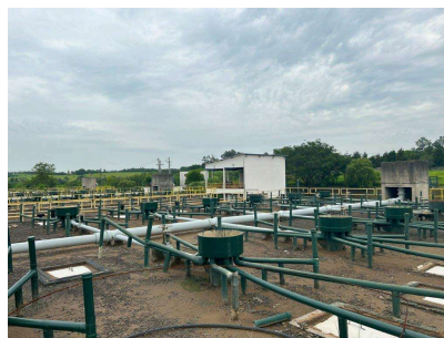
Foto 16 - Reatores UASB
