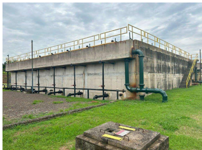
Foto 13 - Reatores UASB
