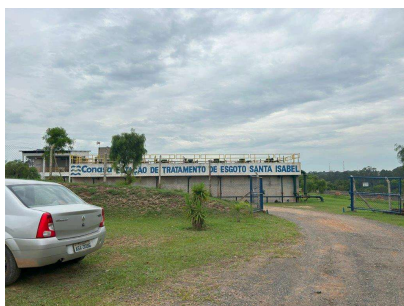
Foto 1 - Vista da fachada da ETE
