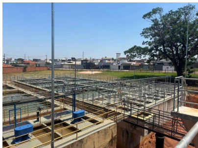
Foto 15 - Vista geral da ETA
