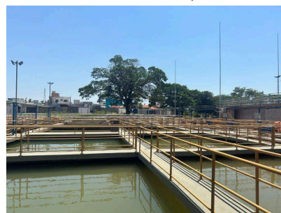
Foto 8 - Vista geral da ETA
