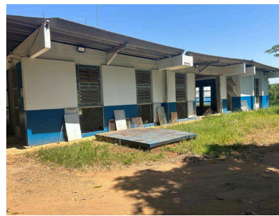
Foto 6 - Casa de bombas
