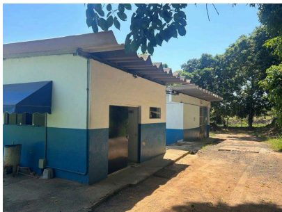
Foto 1 - Casa de bombas
