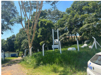
Foto 7 - Entrada da Captação
