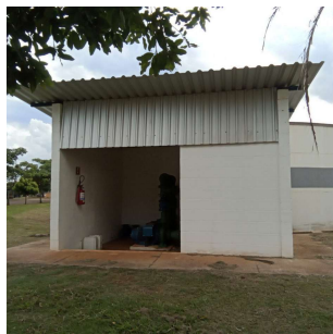
Foto 1 - Vista externa da EEAT recalque ETA II
