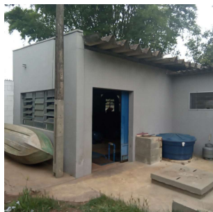
Foto 3 - Vista externa da captação
