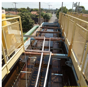
Foto 3 - Vista do decantador
