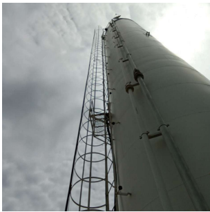
Foto 2 - Escada de acesso e guarda-corpo
