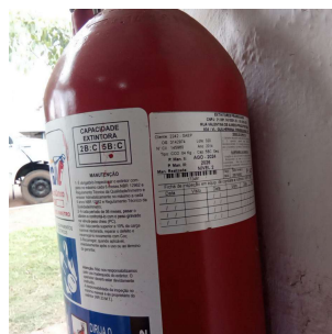
Foto 5 - Validade do extintor de incêndio
