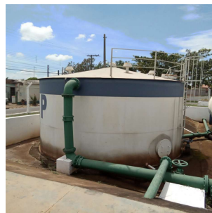
Foto 3 - Reservatório apoiado Santa Fé (R100)
