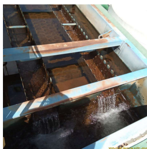
Foto 6 - Vista dos vertedores
