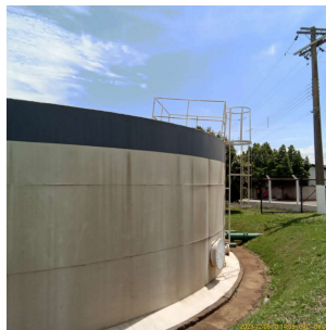
Foto 2 - Escada de acesso e guarda-corpo
