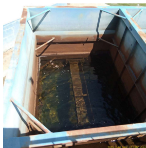
Foto 4 - Vista do filtro
