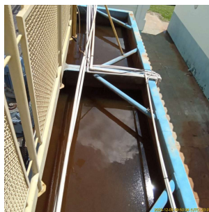
Foto 2 - Vista do floculador
