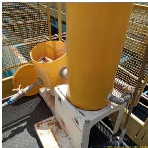
Foto 19 - Sistema de desinfecção (pastilhas)
