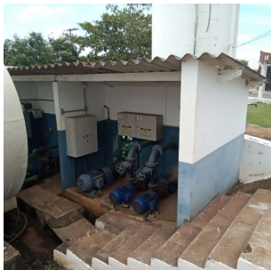
Foto 1 - Vista externa da EEAT Santa Fé
