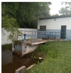
Foto 2 - Tomada de água
