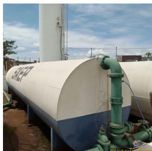
Foto 1 - Reservatório apoiado Santa Fé (R85 e R50)
