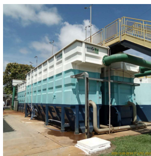
Foto 8 - Vista lateral da ETA Santa Fé
