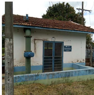
Foto 8 - Vista externa captação I
