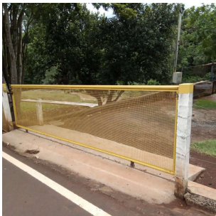
Foto 2 - Portão de acesso a captação São Valentim
