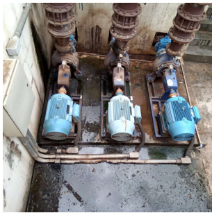
Foto 4 - Conjuntos motor-bombas
