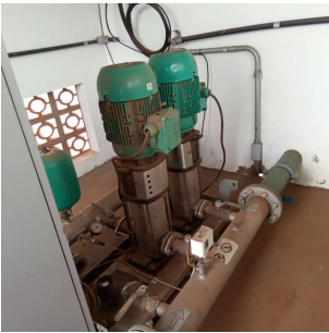
Foto 2 - Conjuntos motor-bomba
