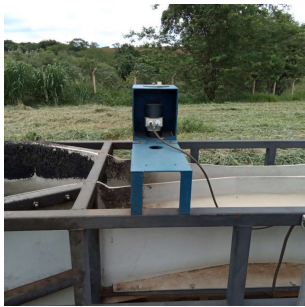
Foto 11 - Medidor de vazão
