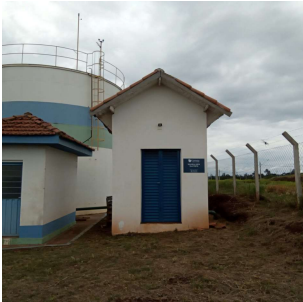
Foto 1 - Vista externa do booster Bela Vista/Poeta
