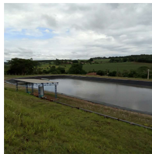
Foto 6 - Vista lagoa de decantação
