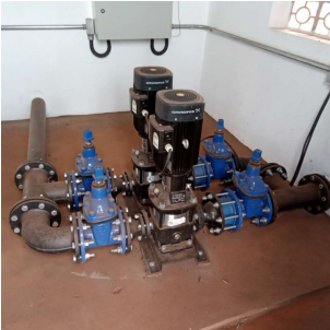
Foto 2 - Conjunto motor-bombas
