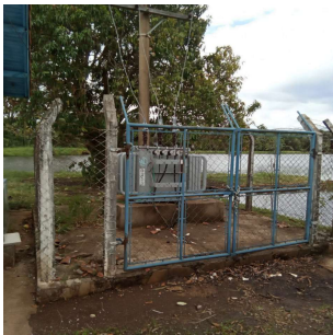
Foto 2 - Portão de acesso as captações superficiais I e II
