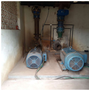
Foto 4 - Conjuntos motor-bombas
