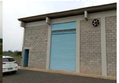
Foto 2 - Vista externa da EEE.
