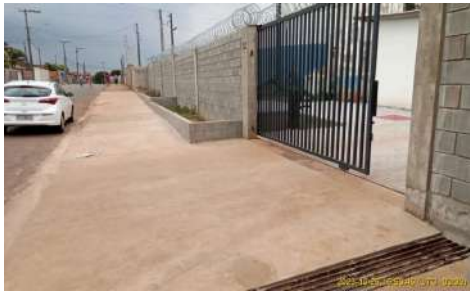
Foto 3 - Portão de acesso.
