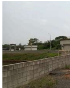
Foto 43 - Primeiro adensador de lodo da ETE.
