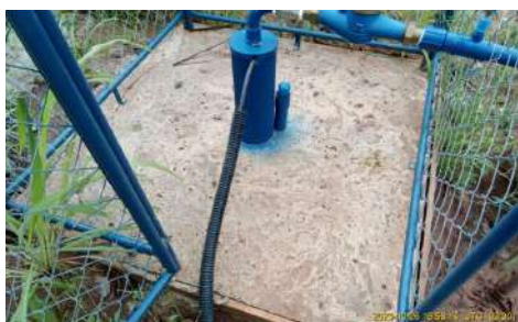
Foto 1 - Laje de proteção do poço.
