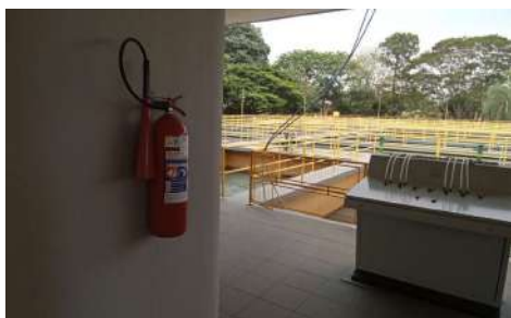
Foto 1 - Extintor na parte superior da ETA.
