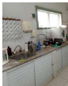
Foto 34 - Laboratório da ETE.
