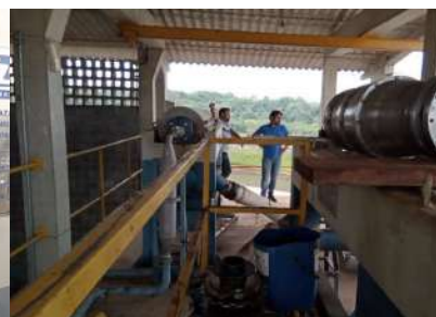
Foto 25 - Vista da centrífuga em manutenção.
