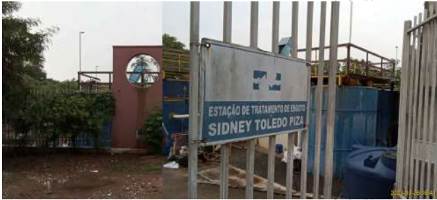
Foto 1 - Vista geral Foto 2 - Acesso e da ETE. identificação da ETE.
