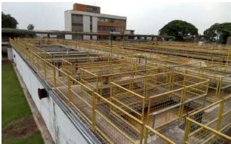
Foto 1 - Vista geral dos guarda-corpos.
