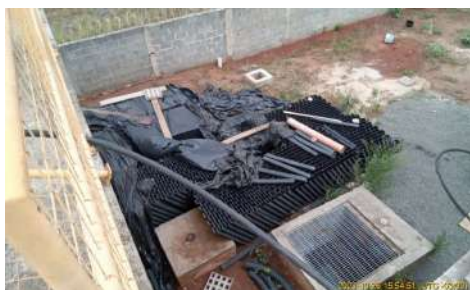
Foto 19 - Estocagem dos perfis laminados do decantador de alta taxa da ETA.
