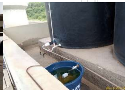
Foto 45 - Detalhes do armazenamento de hipoclorito para desinfecção.
