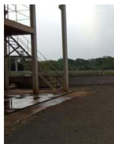
Foto 18 - Vista geral do primeiro decantador secundário da ETE.
