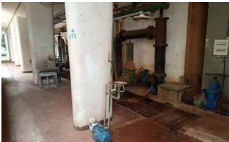
Foto 1 - Chuveiro de emergência.
