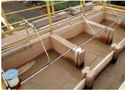
Foto 15 - Aplicação de produtos químicos na caixa de chegada.
