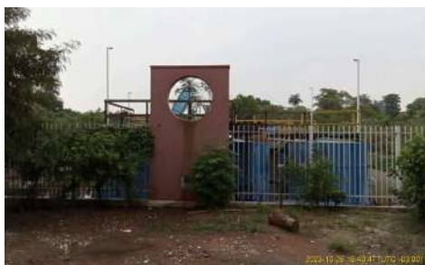
Foto 1 - Vista geral da ETE.
