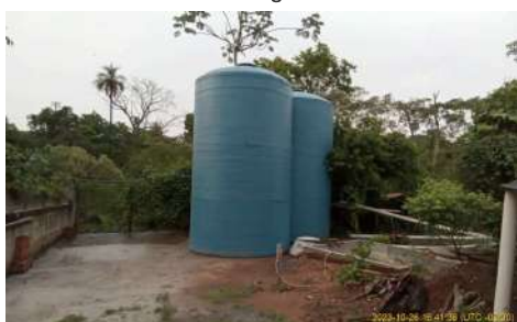
Foto 3 - Dois tanques adquiridos para melhoria do sistema.
