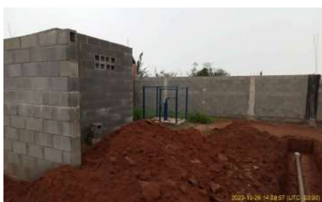
Foto 1 - Vista geral do poço.
