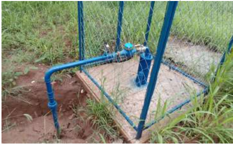
Foto 3 - Vista geral do poço.
