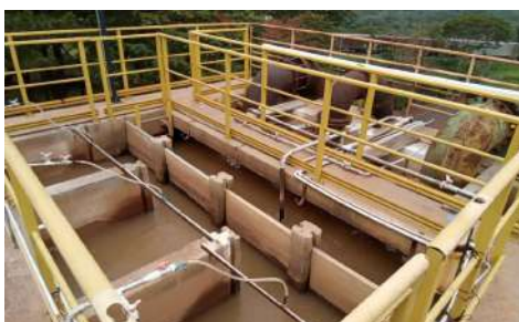
Foto 13 - Caixa de chegada de água bruta para toda a ETA.
