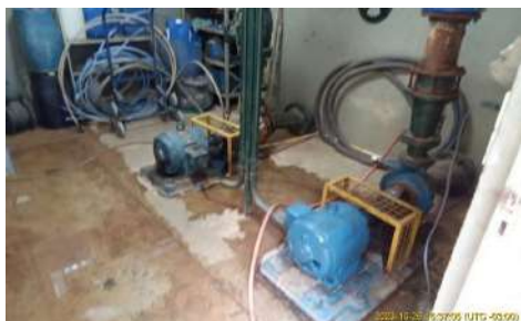
Foto 1 - EEAB atual que será reformada.
