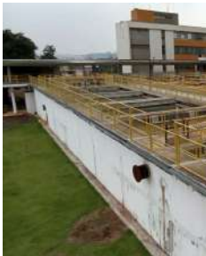
Foto 16 - Vista geral da ETA 3.
