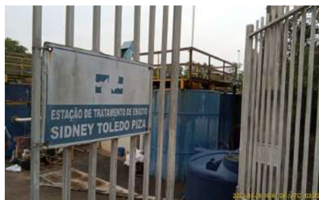
Foto 2 - Acesso e identificação da ETE.
