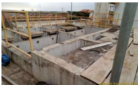
Foto 9 - Vista superior da ETA.
