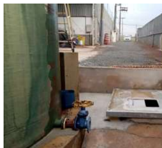
Foto 1 - Local de início da adutora na rampa de acesso à atual ETA.
