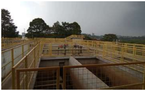
Foto 2 - Vista geral da ETA 3.
