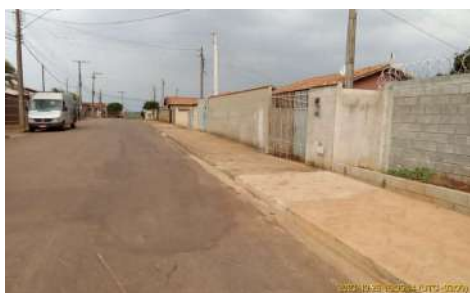
Foto 3 - Diferença no asfalto demonstrando a instalação da tubulação da adutora.
