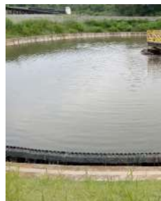
Foto 16 - Segundo decantador secundário da ETE.
