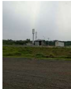
Foto 1 - Vista geral da ETE.
