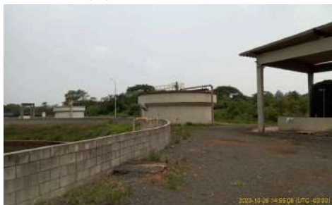
Foto 43 - Primeiro adensador de lodo da ETE.
