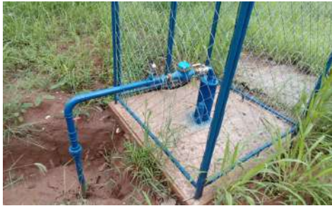
Foto 3 - Vista geral do poço.
