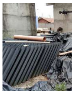
Foto 8 - Estocagem dos perfis laminares do decantador de alta taxa da ETA.
