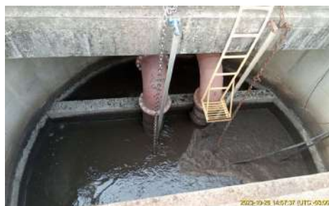
Foto 48 - Poço de lodo para o sistema de tratamento de lodo da ETE.
