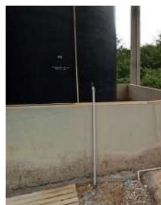
Foto 46 - Chuveiro de emergência.
