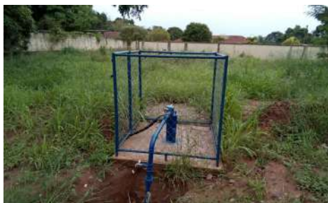
Foto 1 - Cercamento próprio do poço.
