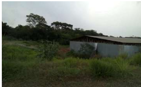
Foto 12 - Local do futuro 3º decantador secundário da ETE.
