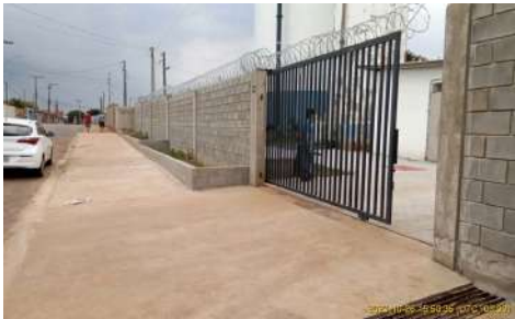
Foto 2 - Portão de acesso.
