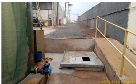
Foto 1 - Local de início da adutora na rampa de acesso à atual ETA.
