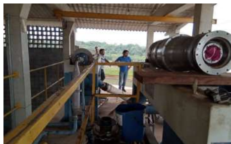
Foto 25 - Vista da centrífuga em manutenção.
