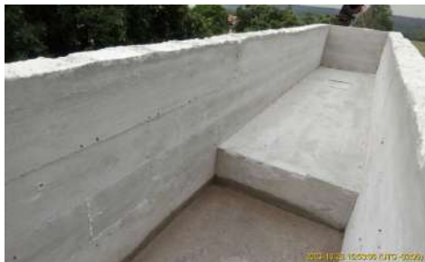
Foto 11 - Canal de chegada da água bruta.
