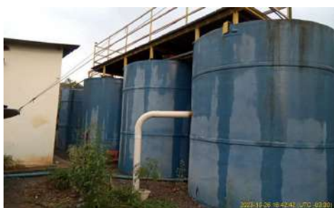
Foto 5 - Vista geral da ETE.
