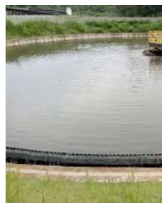
Foto 16 - Segundo decantador secundário da ETE.
