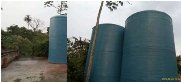
Foto 3 - Dois Foto 4 - Dois tanques adquiridos tanques adquiridos para melhoria do para melhoria do sistema. sistema.
