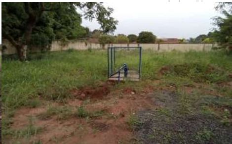
Foto 2 - Vista geral do poço.
