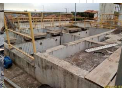
Foto 9 - Vista superior da ETA.
