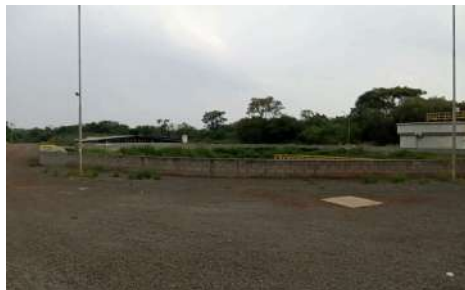
Foto 15 - Vista geral do segundo decantador secundário da ETE.
