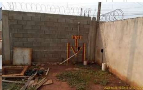
Foto 2 - Local de chegada da adutora marcado na parede da nova ETA Martinho Prado.
