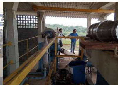
Foto 25 - Vista da centrífuga em manutenção.
