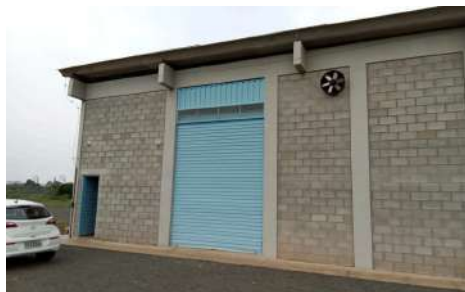
Foto 2 - Vista externa da EEE.
