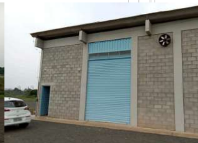
Foto 2 - Vista externa da ETE.
