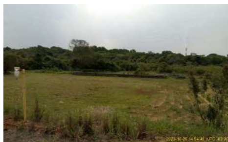
Foto 42 - Sistema de desinfecção ao fundo.
