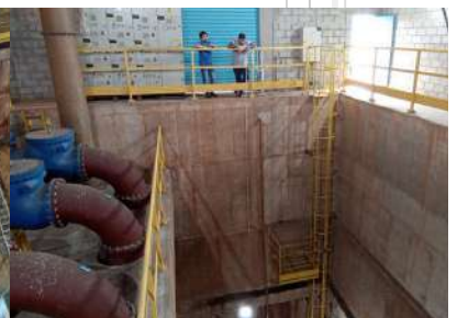
Foto 8 - Vista do guarda-corpo da EEE.
