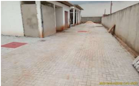
Foto 4 - Acesso interno com piso intertravado.
