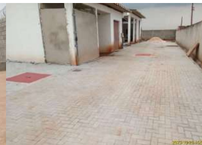
Foto 4 - Acesso interno com piso intertravado.
