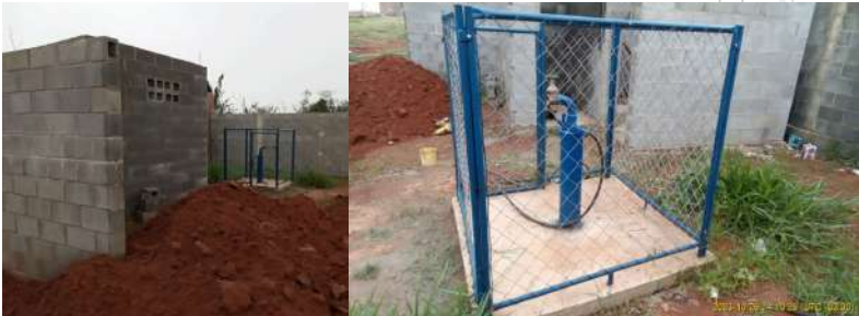
Foto 1 - Vista geral do poço. Foto 2 - Vista geral do poço.
