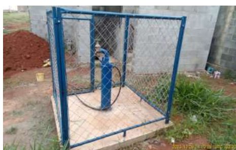
Foto 2 - Vista geral do poço.
