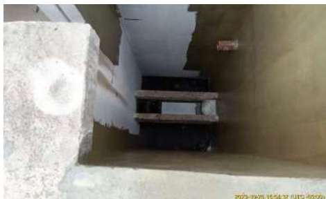
Foto 17 - Vista do fundo do filtro.
