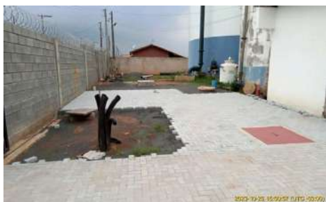
Foto 5 - Acesso interno com piso intertravado.
