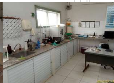
Foto 34 - Laboratório da ETE.
