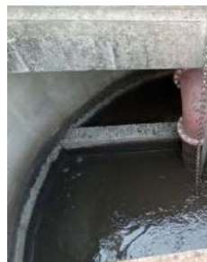
Foto 48 - Poço de lodo para o sistema de tratamento de lodo da ETE.
