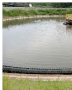
Foto 16 - Segundo decantador secundário da ETE.
