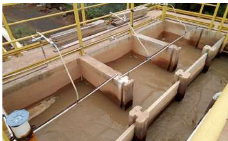
Foto 15 - Aplicação de produtos químicos na caixa de chegada.
