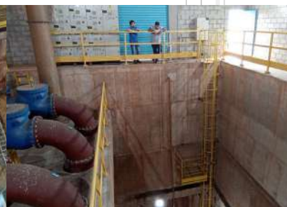
Foto 8 - Vista do guarda-corpo da ETE.
