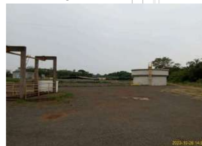
Foto 47 - Segundo adensador de lodo da ETE.
