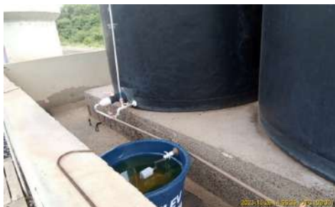
Foto 45 - Detalhes do armazenamento de hipoclorito para desinfecção.
