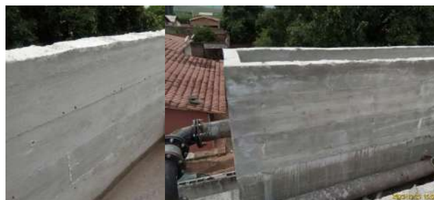
Foto 11 - Canal de chegada da água bruta.
