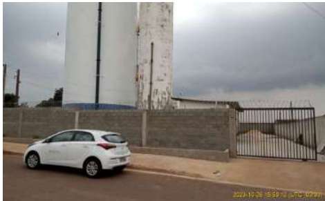
Foto 1 - Vista externa da ETA.
