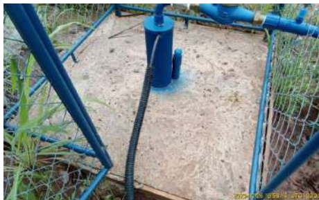
Foto 1 - Laje de proteção do poço.
