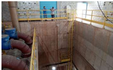
Foto 8 - Vista do guarda-corpo da EEE.
