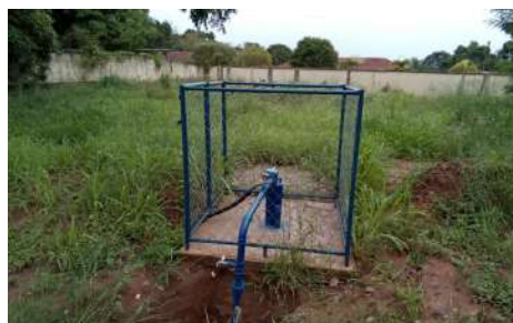
Foto 1 - Cercamento próprio do poço.
