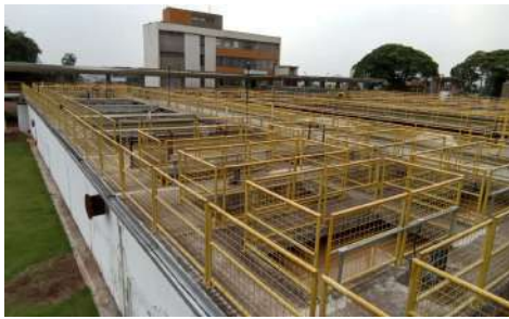
Foto 1 - Vista geral dos guarda-corpos.
