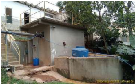
Foto 3 - Vista externa do abrigo da EEAB.
