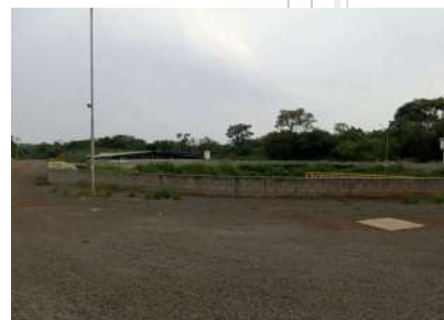
Foto 15 - Vista geral do segundo decantador secundário da ETE.
