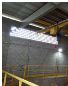
Foto 5 - Vista interna da EEE.
