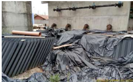
Foto 8 - Estocagem dos perfis laminares do decantador de alta taxa da ETA.
