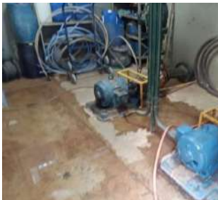
Foto 1 - EEAB atual que será reformada.
