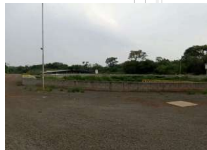
Foto 15 - Vista geral do segundo decantador secundário da ETE.
