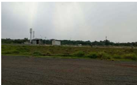
Foto 1 - Vista geral da ETE.
