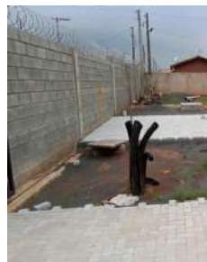
Foto 5 - Acesso interno com piso intertravado.
