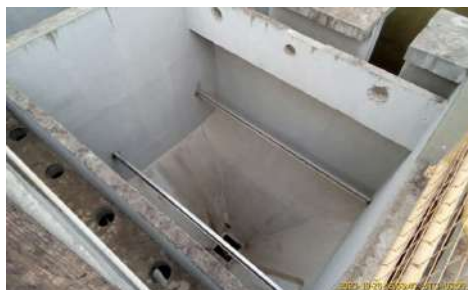
Foto 14 - Vista do decantador da ETA.
