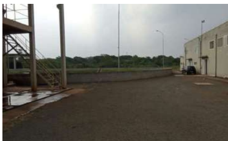
Foto 18 - Vista geral do primeiro decantador secundário da ETE.
