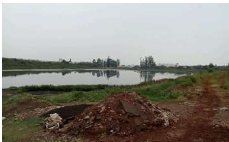
Foto 10 - Antiga lagoa de tratamento desativada e em início de descomissionamento.
