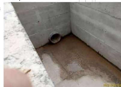
Foto 10 - Tubo de chegada da água bruta.
