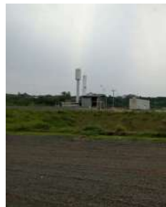
Foto 1 - Vista geral da ETE.
