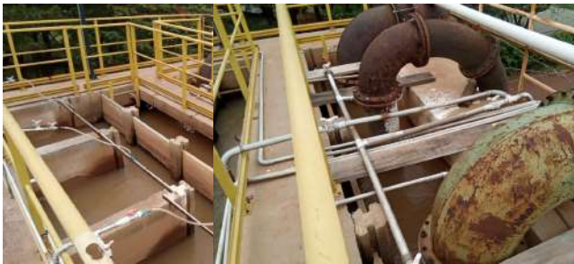
Foto 13 - Caixa de chegada de água bruta para toda a ETA.
