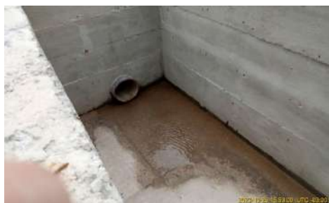
Foto 10 - Tubo de chegada da água bruta.
