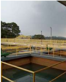
Foto 1 - Vista geral da ETA 3.
