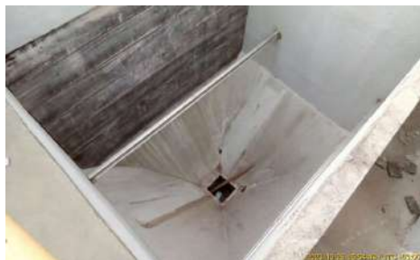
Foto 18 - Vista do fundo do decantador.
