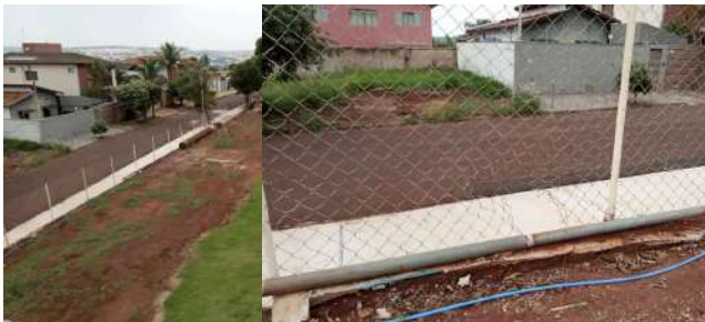
Foto 1 - Cercamento da ETA. Foto 2 - Abertura no alambrado na lateral da ETA 3.
