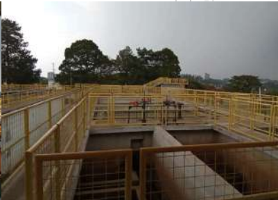
Foto 2 - Vista geral da ETA 3.
