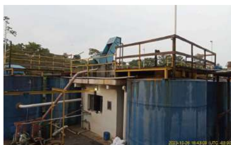
Foto 6 - Vista geral da ETE.
