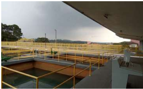
Foto 1 - Vista geral da ETA 3.
