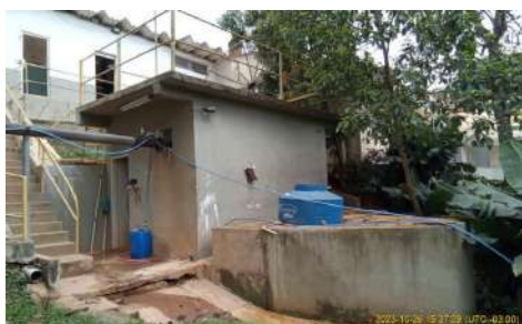
Foto 3 - Vista externa do abrigo da EEAB.
