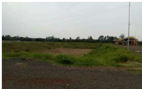
Foto 11 - Local da futura 3ª lagoa aerada da ETE.
