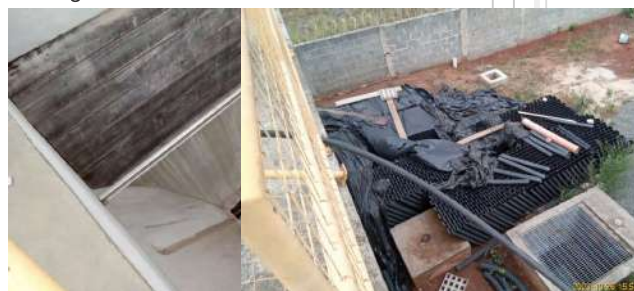
Foto 18 - Vista do fundo do decantador.
