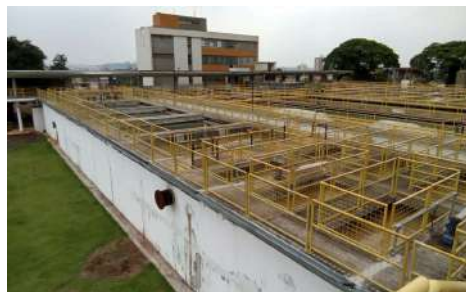
Foto 16 - Vista geral da ETA 3.
