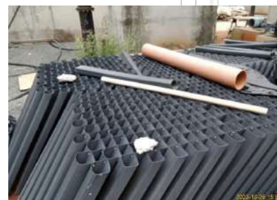
Foto 7 - Perfis laminares do decantador de alta taxa da ETA.
