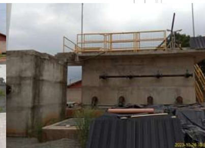
Foto 6 - Vista da ETA.
