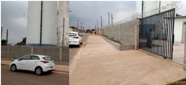
Foto 1 - Vista externa da ETA.
