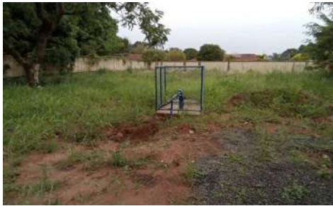
Foto 2 - Vista geral do poço.
