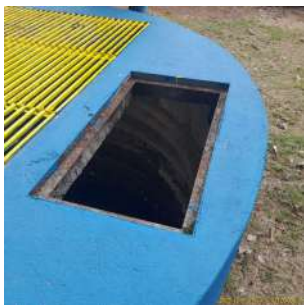
Foto 1 - Poço com abertura.
