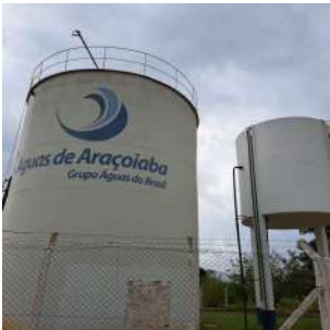
Foto 1 - Vista dos dois reservatórios Alvorada (metálico à esquerda e de concreto à direita).
