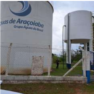
Foto 2 - Vista dos dois reservatórios Alvorada (metálico à esquerda e de concreto à direita).
