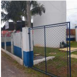
Foto 1 - Detalhe do cercamento.
