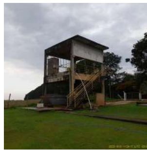
Foto 11 - Detalhe do abrigo da centrífuga para secagem do lodo.
