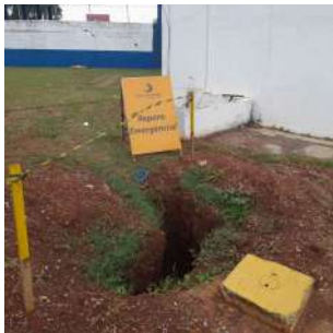
Foto 1 - Detalhe da intervenção feita na tubulação junto ao reservatório.
