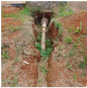
Foto 7 - Detalhe 2 da escavação feita para manutenção recente no registro.
