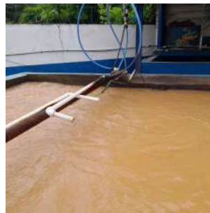
Foto 8 - Aplicação do permanganato.
