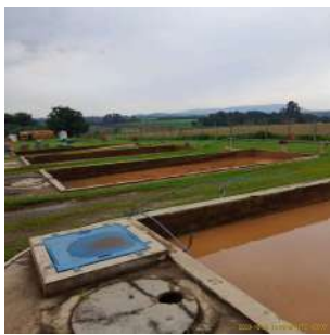
Foto 10 - Vista dos outros tanques de lodo.
