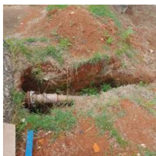
Foto 4 - Detalhe 1 da escavação feita para manutenção recente no registro.
