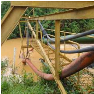
Foto 2 - Detalhe da passarela.
