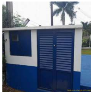
Foto 2 - Abrigo do painel elétrico.
