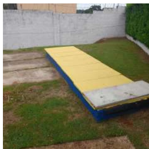
Foto 1 - Chegada do esgoto bruto, protegido com placas de concreto.
