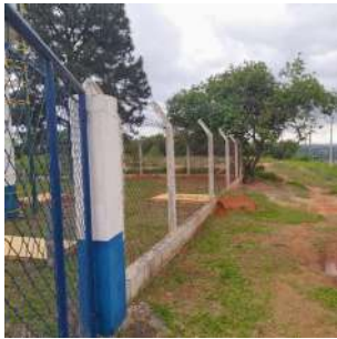
Foto 1 - Cercamento do local.
