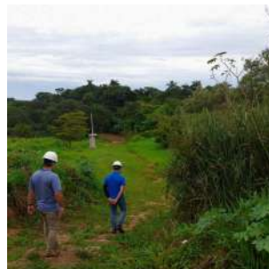
Foto 2 - Vista geral da captação.
