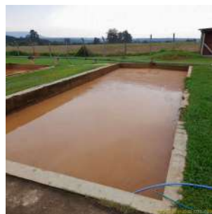
Foto 9 - Vista do primeiro tanque de lodo, próximo à centrífuga.
