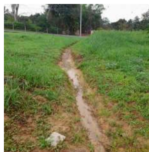
Foto 7 - Trajeto percorrido pelo efluente que transborda do tanque.
