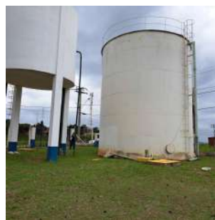
Foto 4 - Vista dos dois reservatórios Alvorada (metálico à direita e de concreto à esquerda).
