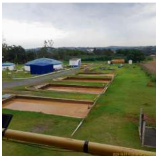
Foto 14 - Vista superior dos tanques de lodo.
