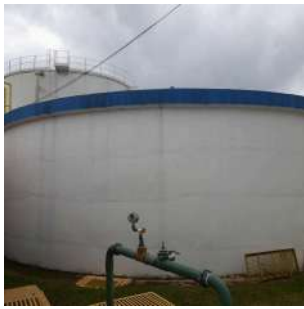
Foto 1 - Vista geral 1 do reservatório.
