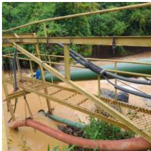
Foto 2 - Detalhe da passarela.
