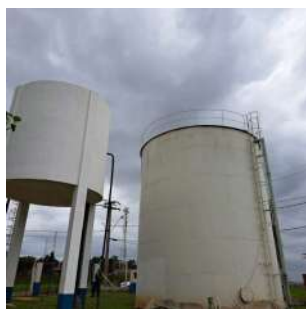
Foto 3 - Vista dos dois reservatórios Alvorada (metálico à direita e de concreto à esquerda).
