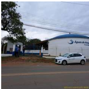
Foto 1 - Vista externa do Reservatório Apoiado e da EEAT Araçoiabinha.
