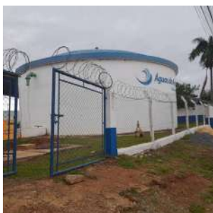
Foto 1 - Cercamento do local.
