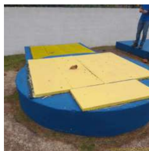
Foto 2 - Poço das bombas.
