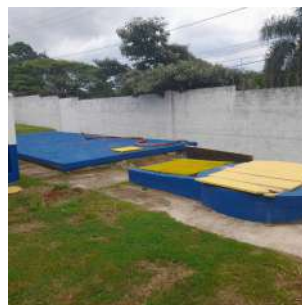
Foto 2 - Vista geral 1 da E.E.E.
