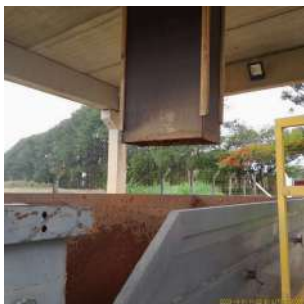
Foto 18 - Queda do material seco nas caçambas.
