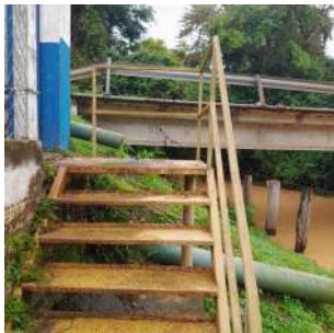
Foto 1 - Detalhe da escada.
