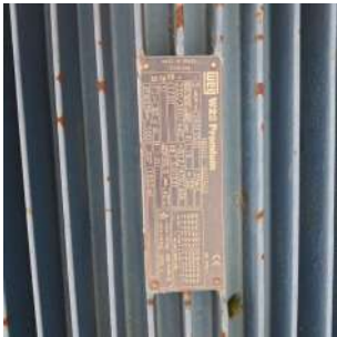
Foto 4 - Placa de especificações técnicas do motor do conjunto motobomba nº 2 da EEAB
