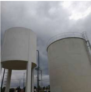
Foto 2 - Foto geral 2 dos reservatórios Alvorada. À esquerda, o de concreto, e à direita, o metálico.
