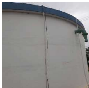
Foto 1 - Detalhe do cabeamento da telemetria.
