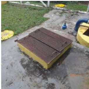
Foto 1 - Acesso às bombas.
