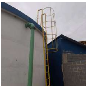
Foto 1 - Detalhe do guarda-corpos em torno da escada de acesso.
