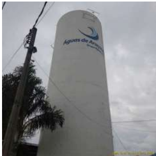
Foto 1 - Vista geral do reservatório elevado, com identificação da Concessionária.
