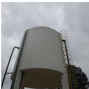
Foto 1 - Detalhe da escada com guarda-corpos.
