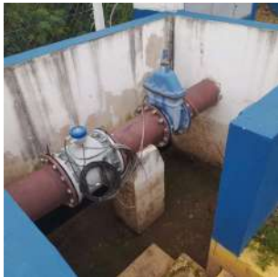
Foto 1 - Detalhe da saída do esgoto bombeado.
