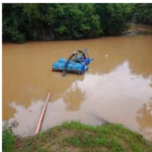
Foto 4 - Detalhe da bomba flutuadora.
