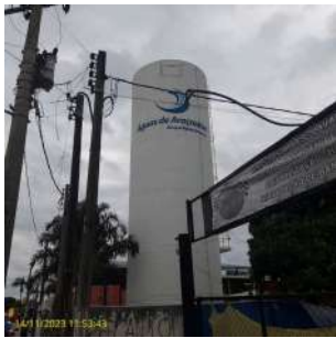
Foto 1 - Vista afastada do reservatório, sem para-raios.
