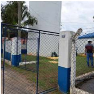
Foto 1 - Vista externa dos Reservatórios e da EEAT Tonelli.
