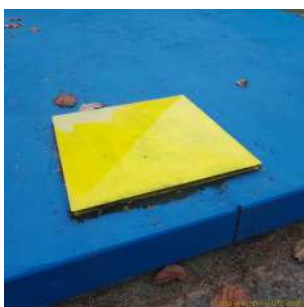
Foto 1 - Detalhe de tampa de inspeção.
