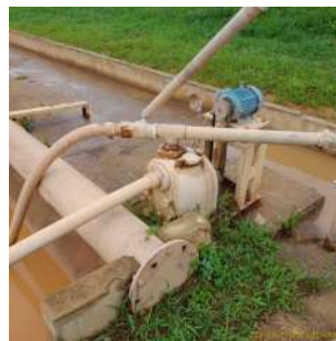
Foto 2 - Bombeamento da água de lavagem.
