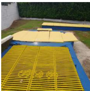
Foto 1 - Detalhe do poço.
