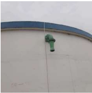
Foto 1 - Detalhe do extravasor.
