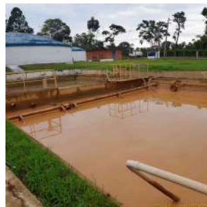
Foto 3 - Vista geral 2 dos tanques no fundo da ETA.
