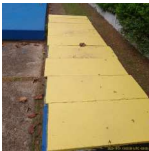
Foto 3 - Chegada do esgoto bruto, protegido com placas de concreto.
