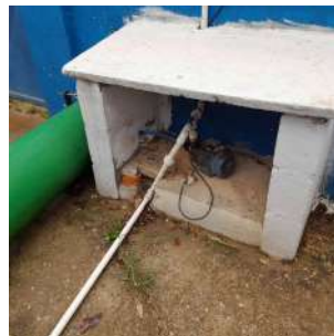
Foto 10 - Bomba usada para aplicação do permanganato.
