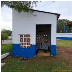
Foto 2 - Vista da EEAT Araçoiabinha
