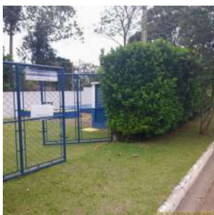
Foto 1 - Cercamento do local, dentro do condomínio.
