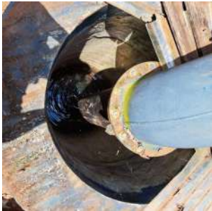
Foto 4 - Poço de sucção da estação elevatória.
