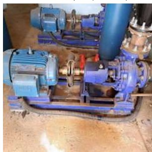
Foto 9 - Primeiro conjunto motobomba.
