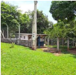
Foto 2 - Vista externa da elevatória da Captação.
