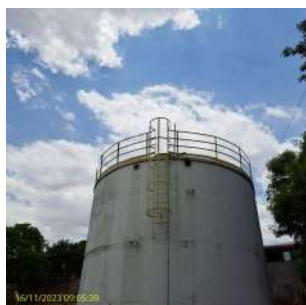
Foto 6 - Haste de captação do SPDA.
