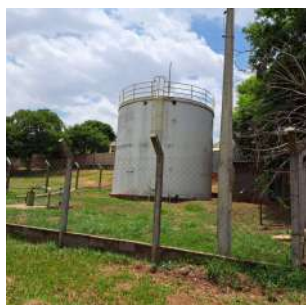
Foto 1 - Vista geral do reservatório.
