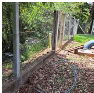
Foto 7 - Poço de sucção (direita) e Córrego do Gouveia (esquerda).
