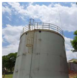
Foto 2 - Vista da parte superior do reservatório.
