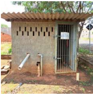
Foto 2 - Vista externa da EEAT.
