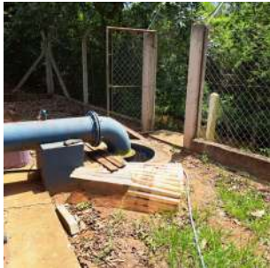
Foto 3 - Poço de sucção da estação elevatória.
