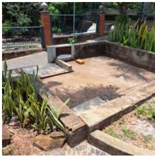
Foto 1 - Vista geral da EEEB.
