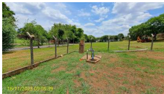
Foto 9 - Trecho do alambrado tombado.
