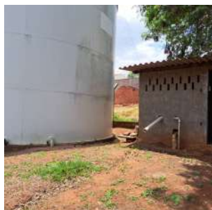
Foto 3 - Vista da parte inferior do reservatório e, à direita, a EEAT.
