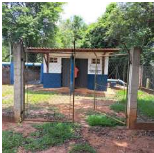
Foto 1 - Vista externa da elevatória da Captação.
