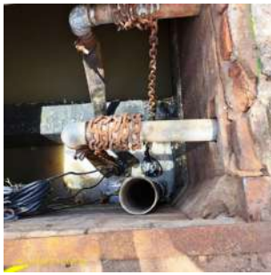
Foto 1 - Detalhe da área interna da EEEB.
