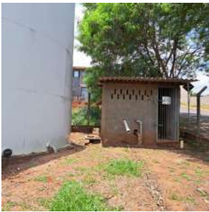
Foto 1 - Vista externa da EEAT e, à esquerda, o reservatório.
