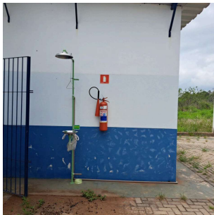
Foto 1 - Extintor de incêndio na área externa da EEAT e ao lado do chuveiro de emergência.
