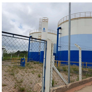
Foto 1 - Vista externa da área do Poço e dos Reservatórios Jardim do Sol.
