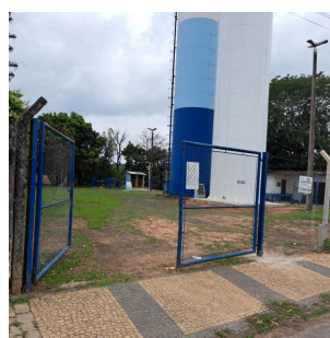
Foto 3 - Vista externa dos dois reservatórios elevados da Rua Cinco.
