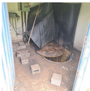
Foto 1 - Área interna da EEEB com blocos/tijolos no piso para acesso em caso de extravasamento de esgoto.
