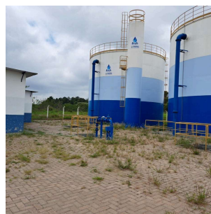
Foto 2 - Vista do Poço e dos Reservatórios Jardim do Sol.
