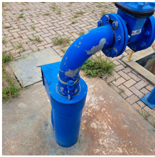
Foto 1 - Tubo para medição de nível.
