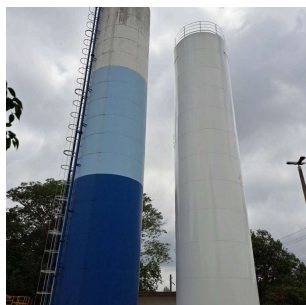
Foto 1 - Vista dos dois reservatórios elevados. O novo está pintado apenas na cor branca, sem identificação da DAE Itirapina.
