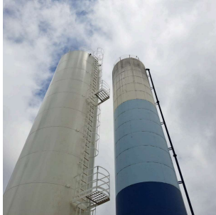
Foto 6 - Vista dos dois reservatórios elevados. O novo está pintado apenas na cor branca, sem identificação da DAE Itirapina.
