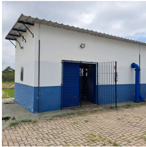
Foto 1 - Vista externa da EEAT.
