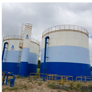
Foto 1 - Vista geral dos 3 reservatórios.
