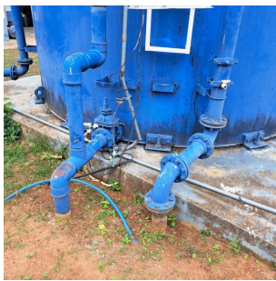
Foto 3 - Aterramento do SPDA do antigo reservatório.
