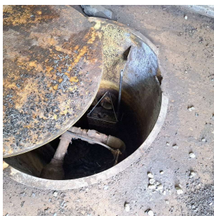
Foto 1 - Detalhe do gradeamento grosseiro.
