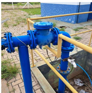
Foto 1 - Local de tomada de água bruta.
