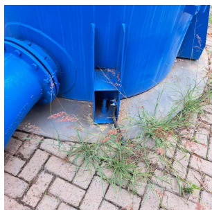
Foto 3 - Aterramento do SPDA.
