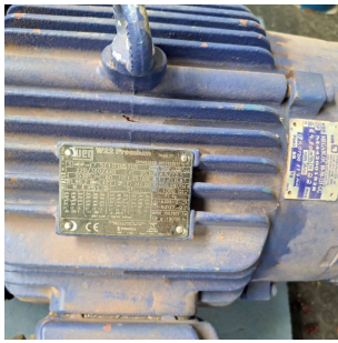
Foto 9 - Placa de especificações técnicas do motor do terceiro conjunto motobomba.
