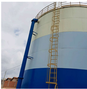
Foto 5 - Guarda-corpo da escada marinheiro e tubo extravasor de um dos reservatório maiores.
