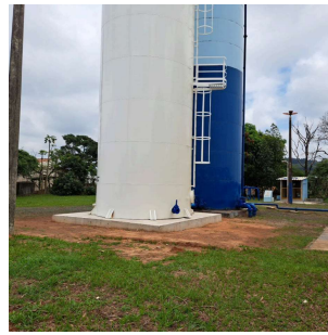
Foto 5 - Vista da base dos dois reservatórios elevados da Rua Cinco.
