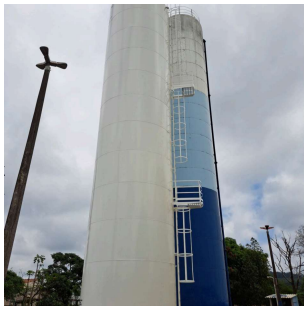
Foto 4 - Vista dos dois reservatórios elevados da Rua Cinco.
