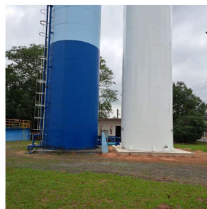
Foto 2 - Vista dos dois reservatórios elevados da Rua Cinco.
