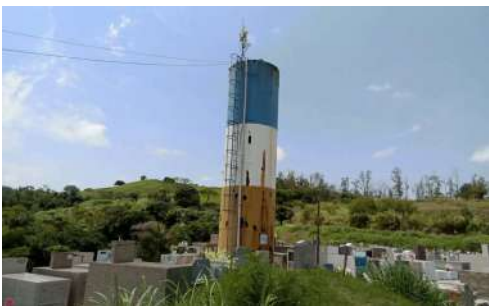
Foto 2 - Vista geral do reservatório.
