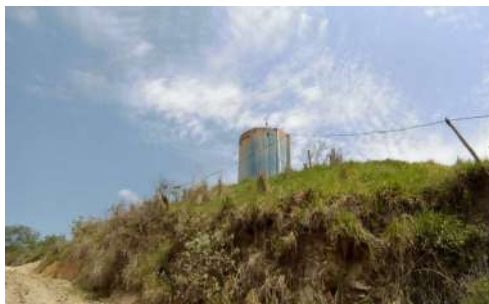
Foto 3 - Vista geral do reservatório.
