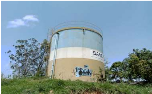
Foto 1 - Vista geral do reservatório.
