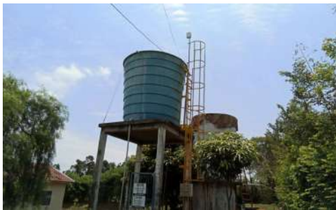
Foto 2 - Vista geral do reservatório.
