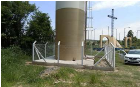
Foto 3 - Vista geral do reservatório.
