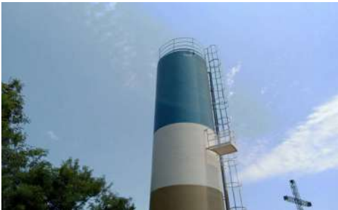
Foto 4 - Cerca do reservatório.
