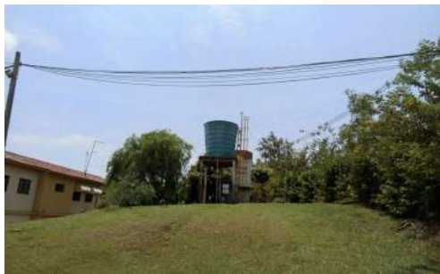
Foto 1 - Vista geral do reservatório.
