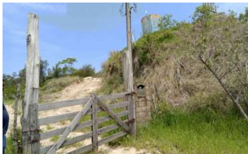
Foto 1 - Vista do acesso ao reservatório.
