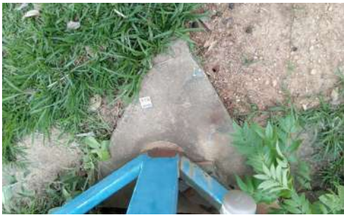
Foto 3 - Identificação do reservatório.
