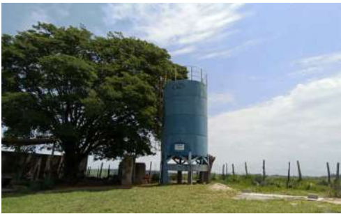
Foto 2 - Vista geral do reservatório.
