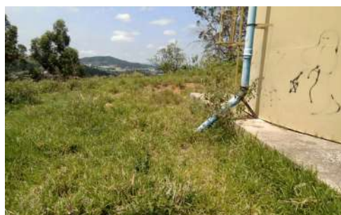
Foto 2 - Mato no entorno do reservatório.
