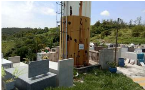
Foto 3 - Vista geral do reservatório.
