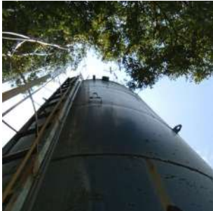
Foto 5 - Tela de proteção no extravasor.
