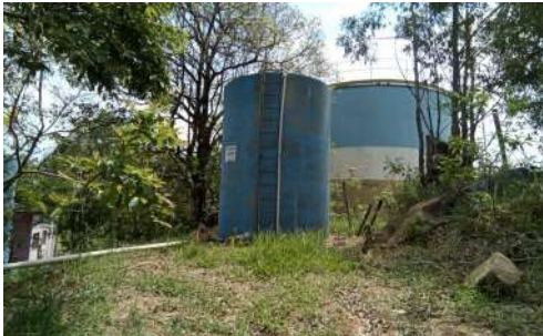
Foto 1 - Vista geral do reservatório.
