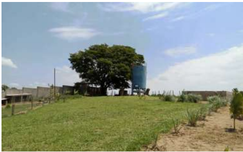
Foto 1 - Vista geral do reservatório.
