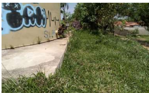
Foto 1 - Mato no entorno do reservatório.
