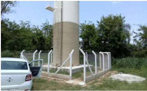
Foto 1 - Vista geral do reservatório.
