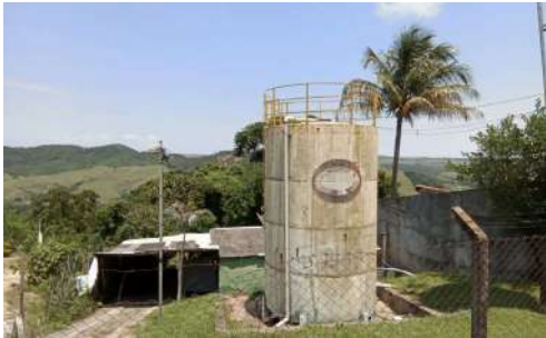
Foto 1 - Vista geral do reservatório.
