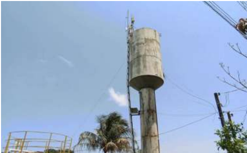
Foto 6 - Vista geral do reservatório desativado.
