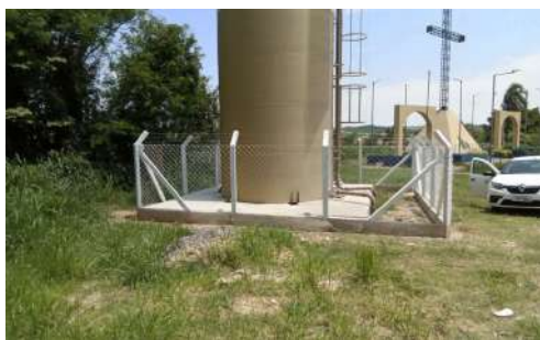
Foto 1 - Cerca do reservatório.
