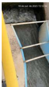
Foto 7 - Entrada de esgoto bruto
