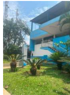
Foto 38 - Fachada da ETA
