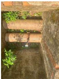
Foto 41 - medidor de vazão saída
