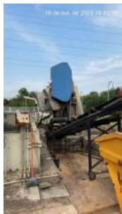
Foto 17 - Esteira de sólidos danificada
