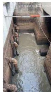
Foto 14 - Poço de chegada de esgoto bruto
