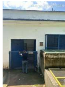
Foto 8 - Entrada da casa de bombas antiga - museu
