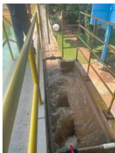
Foto 5 - Canal de entrada
