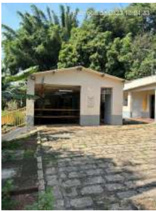
Foto 7 - Vista externa da Elevatória
