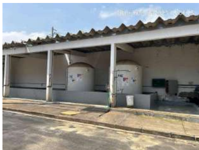
Foto 3 - Galpão de Produtos químicos
