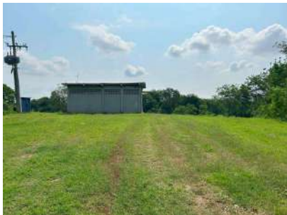
Foto 1 - vista geral do entorno
