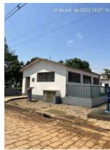
Foto 2 - Casa de bombas
