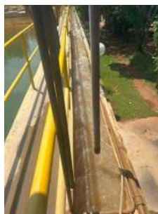
Foto 6 - Canal de entrada
