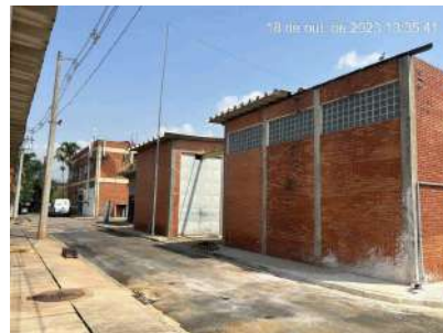
Foto 6 - Casa de bombas/sopradores
