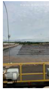
Foto 10 - Tanques de aeração
