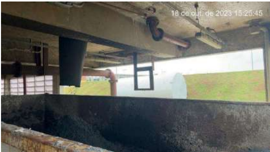
Foto 23 - Desidratação do lodo
