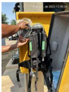
Foto 7 - Kit emergência cloro gás
