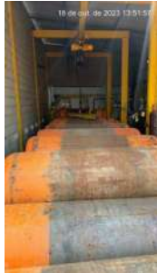
Foto 21 - cilindros de cloro gás
