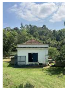
Foto 6 - Casa de bombas antiga - Museu
