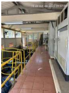
Foto 1 - Casa de bombas
