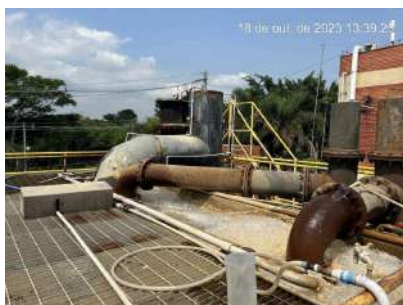
Foto 9 - Entrada de água na ETA
