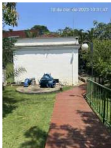
Foto 7 - Casa de bombas - museu
