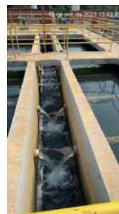
Foto 16 - Canaleta do clarificado do decantador
