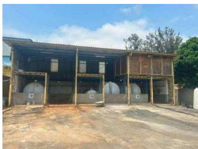
Foto 27 - Galpão de produto químico
