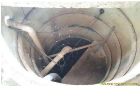
Foto 18 - Interior do poço de acúmulo de lodo.
