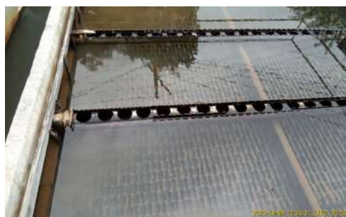
Foto 2 - Vertedores desnivelados.
