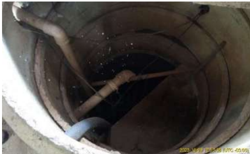
Foto 17 - Interior do poço de acúmulo de lodo.
