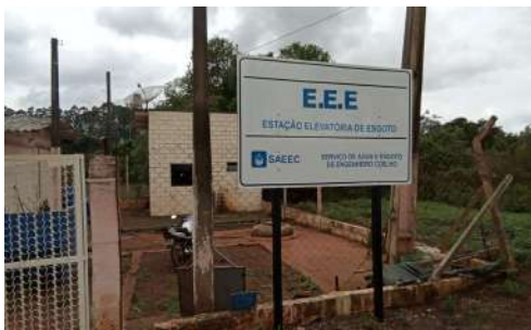
Foto 1 - Placa de identificação do local.
