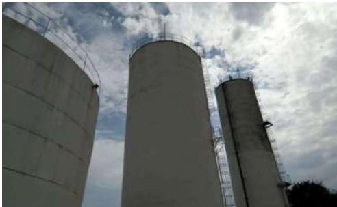
Foto 2 - Vista geral do reservatório (meio).
