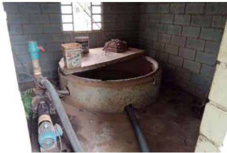
Foto 16 - Poço de acúmulo de lodo.
