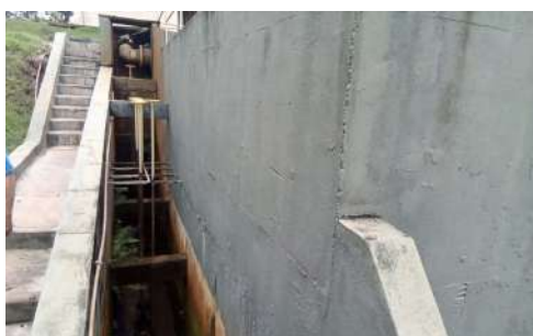
Foto 14 - Parede lateral dos decantadores.
