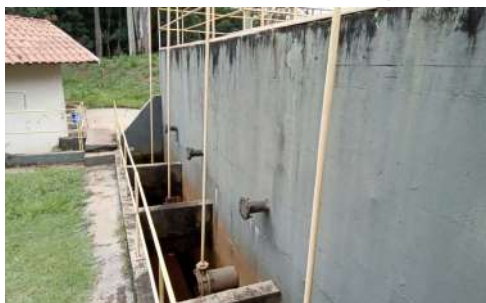
Foto 12 - Parede externa dos filtros.
