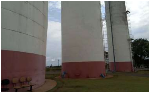
Foto 1 - Vista geral do reservatório (meio).
