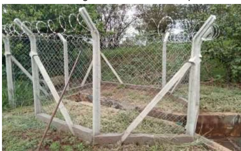
Foto 5 - Cercamento para instalação do macromedidor.
