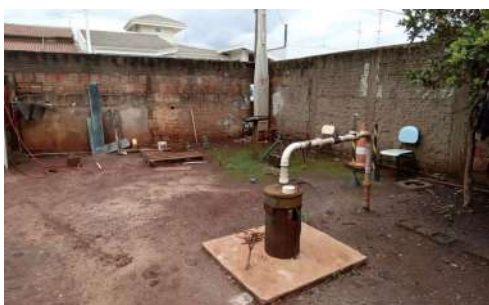
Foto 1 - Muro de carcamento.
