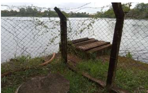
Foto 2 - Vista da captação.
