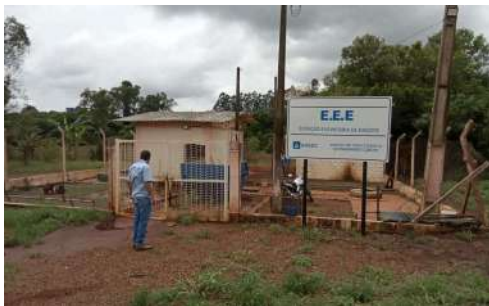
Foto 1 - Vista externa da EEE.
