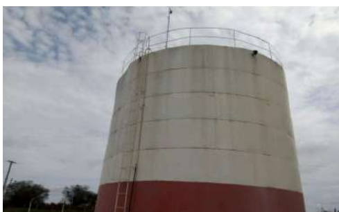
Foto 1 - Guarda-corpo do reservatório.
