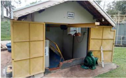
Foto 1 - Vista externa da EEAT.
