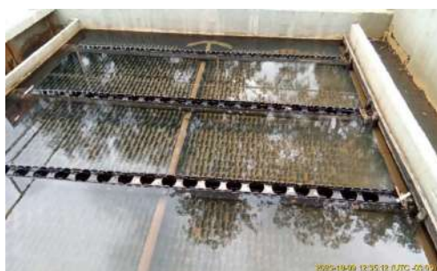
Foto 3 - Vertedores desnivelados.
