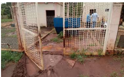
Foto 1 - Portão de acesso.
