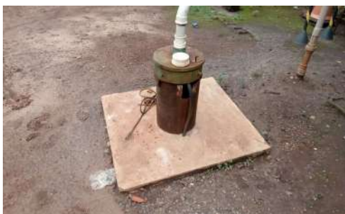
Foto 1 - Laje de proteção.
