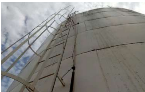
Foto 2 - Descida do cabeamento do SPDA.
