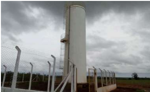
Foto 1 - Vista geral do reservatório.
