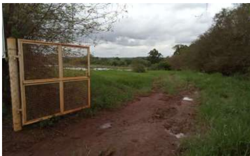
Foto 1 - Vista do acesso à ETE.
