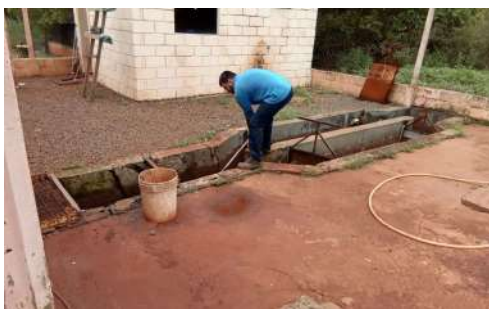
Foto 10 - Limpeza manual das grades.
