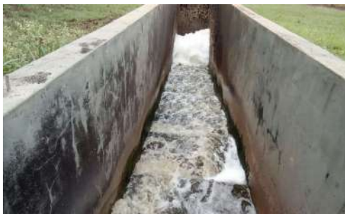
Foto 14 - Primeira escada hidráulica com formação de espuma.
