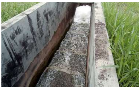
Foto 15 - Segunda escada hidráulica com formação de espuma.
