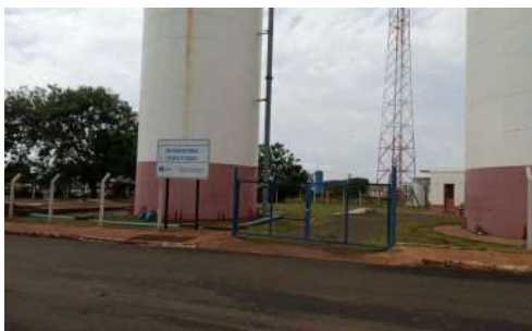
Foto 1 - Identificação da área de reservação.
