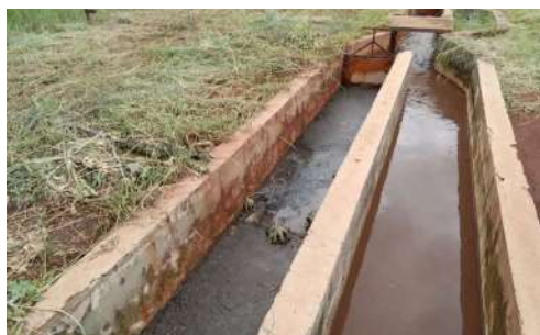
Foto 1 - Realizar a limpeza da caixa de areia.
