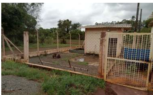
Foto 1 - Cercamento da área.
