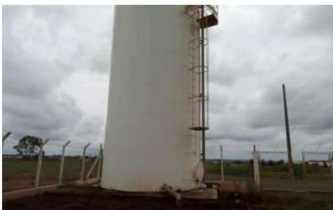
Foto 2 - Vista do guarda-corpo.
