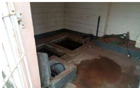
Foto 6 - Casa de bombas.
