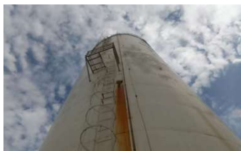
Foto 2 - Descida do cabeamento do SPDA.
