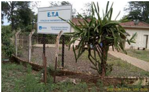
Foto 1 - Cercamento da ETA, EEAT e Reservatório da ETA.
