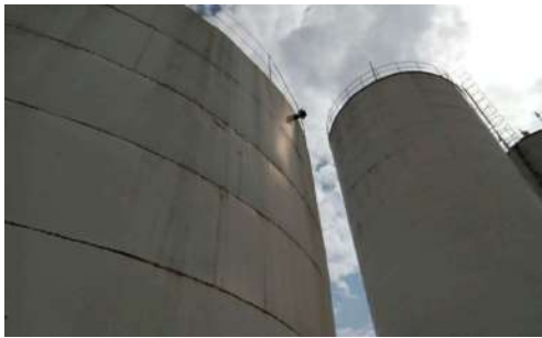
Foto 1 - Extravaseiro do reservatório.
