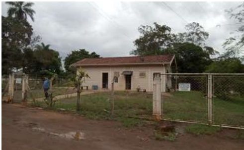
Foto 1 - Vista externa da ETA.
