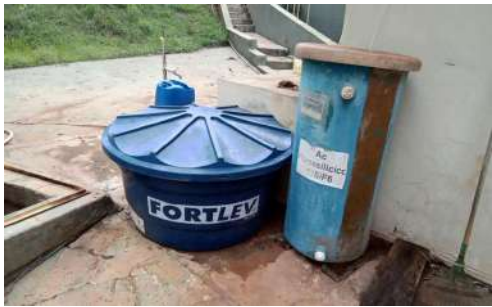
Foto 15 - Sistema de aplicação de fluor.
