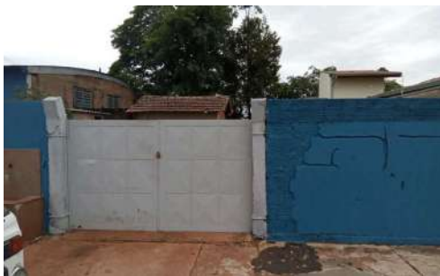
Foto 1 - Vista do acesso ao poço.
