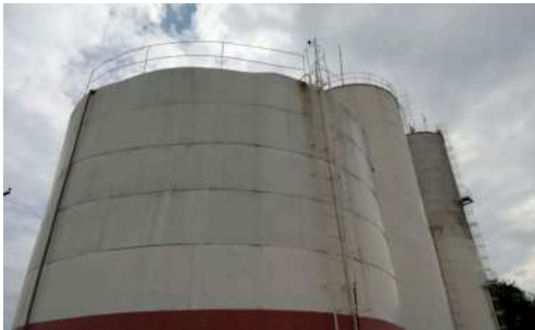
Foto 2 - Vista do reservatório.
