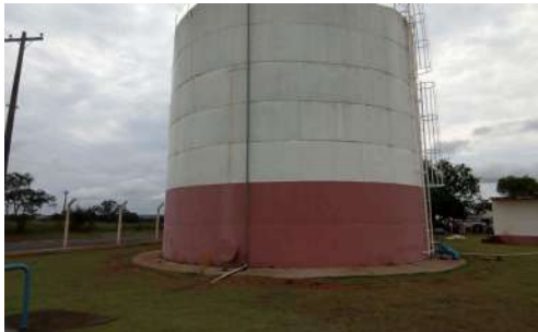
Foto 1 - Vista do reservatório.
