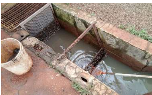
Foto 8 - Remoção do material retido nas grades.
