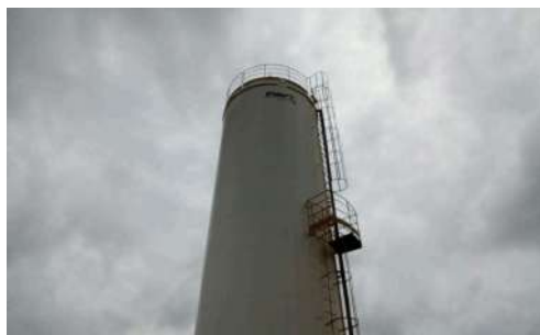
Foto 1 - Vista do guarda-corpo.
