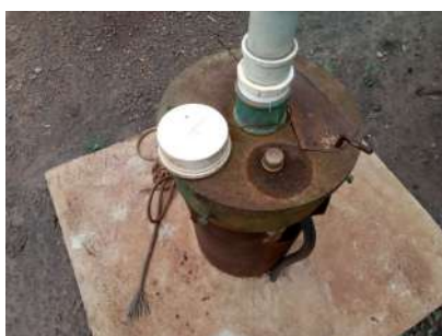
Foto 1 - Tubo de medição de nível.
