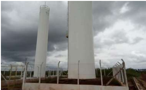
Foto 2 - Vista geral do reservatório.
