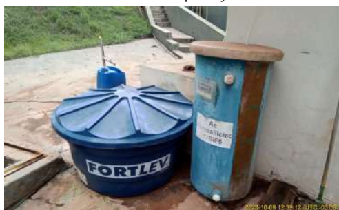
Foto 3 - Sistema de aplicação de flúor.
