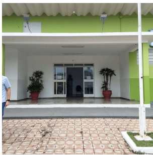
Foto 1 - Fachada da central de atendimento, que fica na prefeitura.
