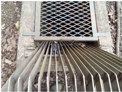
Foto 3 - Vista superior do gradeamento
