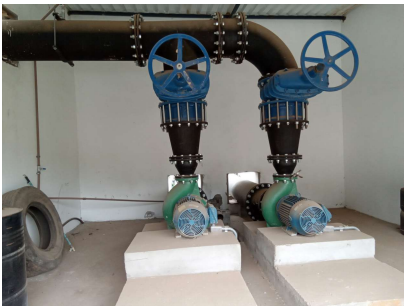
Foto 2 - Conjuntos motor-bombas
