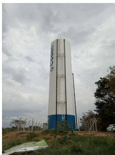
Foto 1 - Reservatório Pós Anhanguera
