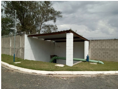
Foto 1 - Vista externa da casa de bombas
