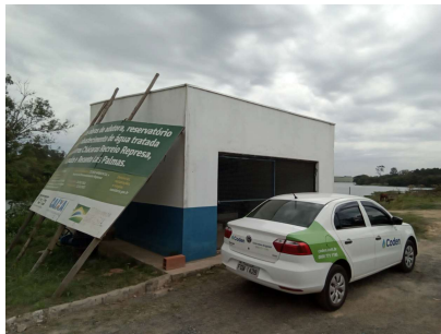
Foto 1 - Vista externa da casa de bombas
