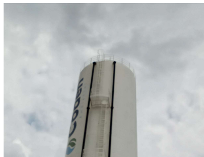
Foto 2 - Vista dos guarda-corpos e escadas
