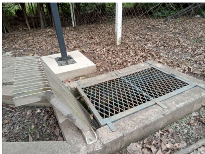
Foto 2 - Vista lateral do gradeamento
