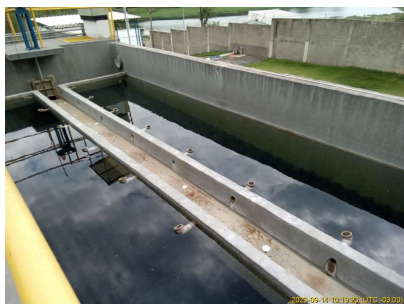
Foto 1 - Vertedores dos decantadores
