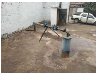
Foto 1 - Local todo cimentado.
