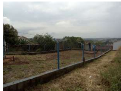
Foto 2 - Cerca do reservatório.
