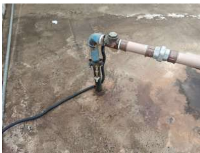
Foto 1 - Tomada de água.
