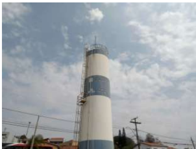
Foto 1 - Tubo extravasor do reservatório.
