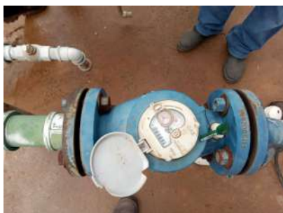
Foto 1 - Macromedidor funcionando.
