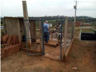
Foto 3 - Portão de acesso.
