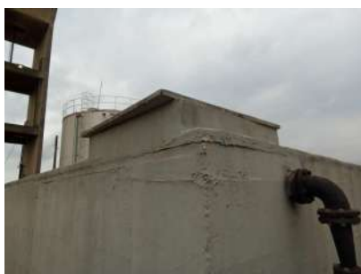
Foto 1 - Tampa de inspeção do reservatório.
