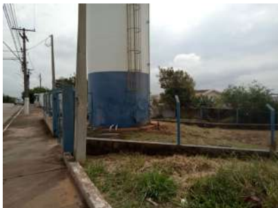
Foto 1 - Cerca do reservatório.
