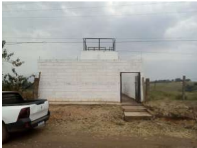
Foto 1 - Vista geral externa do reservatório.
