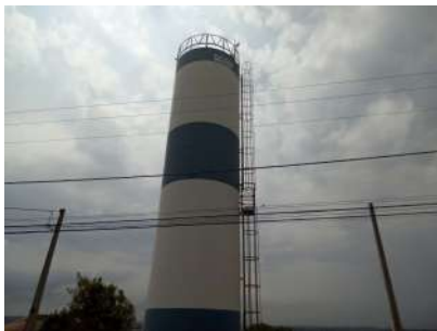
Foto 1 - Vista geral do reservatório.
