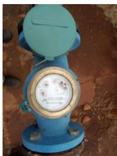
Foto 1 - Macromedidor funcionando.
