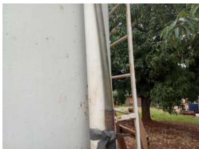
Foto 3 - Mangueira suja com obstrução visual.
