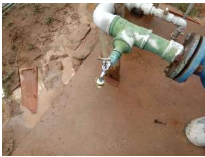
Foto 1 - Torneira para tomada de água.
