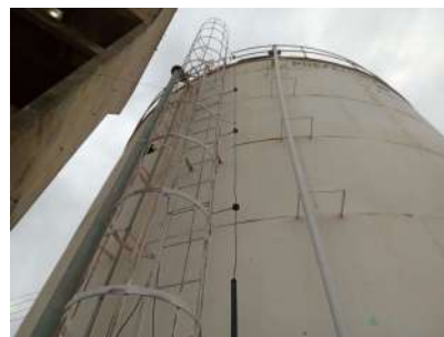
Foto 2 - Descida do cabeamento do SPDA.
