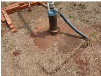
Foto 1 - Laje de proteção.
