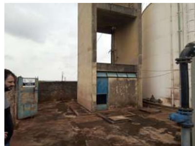
Foto 2 - Vista geral do reservatório.
