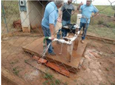
Foto 2 - Vista interna do poço.
