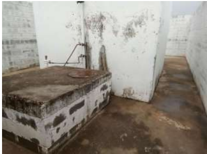
Foto 3 - Vista geral interna do reservatório.
