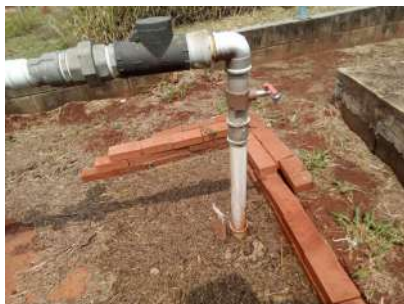
Foto 1 - Tomada de água.
