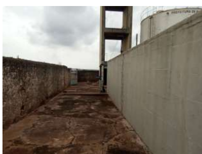
Foto 1 - Extravasador do reservatório.
