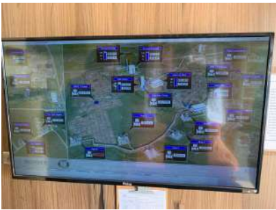
Foto 2 - Vista geral do sistema municipal.
