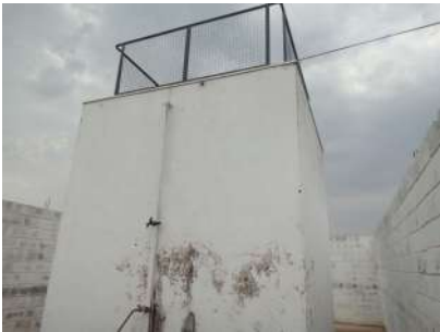
Foto 2 - Vista geral interna do reservatório.
