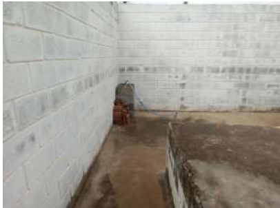
Foto 5 - Vista geral interna do reservatório.
