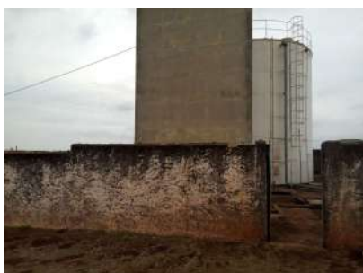
Foto 1 - Muro no entorno do complexo recalque 3.
