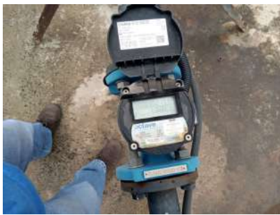
Foto 1 - Macromedidor funcionando.
