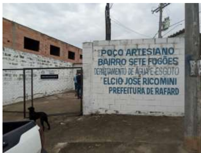
Foto 1 - Muro e portão de acesso.
