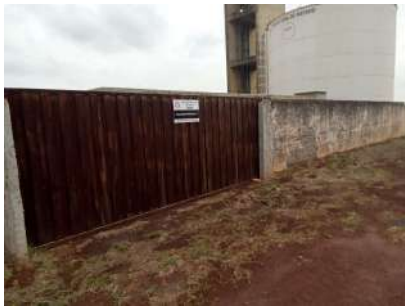
Foto 2 - Portão de acesso ao poço.
