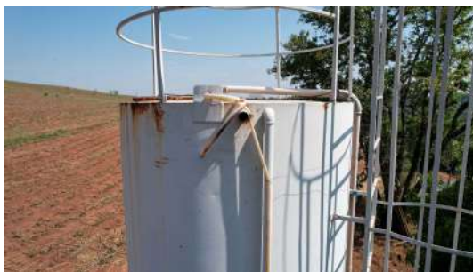
Foto 2 - Extravasor sem tela de proteção. Imagem de Drone (14/10/2022).
