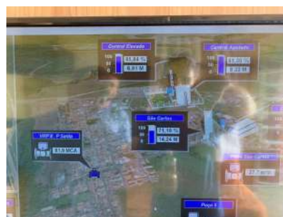
Foto 4 - Detalhe do monitoramento do recalque 3.
