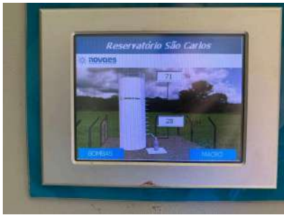
Foto 2 - Monitoramento do reservatório.
