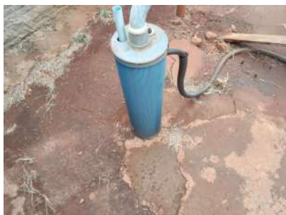
Foto 1 - Laje de proteção.
