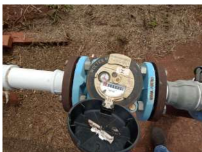
Foto 1 - Macromedidor funcionando.
