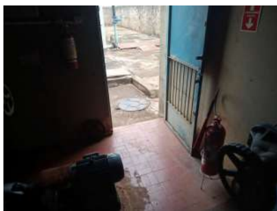
Foto 1 - Dois extintores de incêndio.
