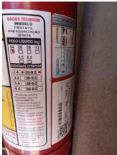
Foto 1 - Validade do extintor de pó químico.
