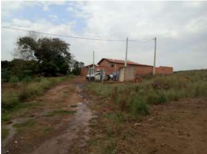
Foto 1 - Vista externa do poço.
