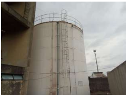
Foto 1 - Vista geral do reservatório.
