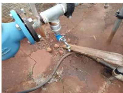
Foto 1 - Tomada de água.
