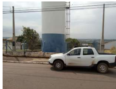
Foto 2 - Vista geral do reservatório.
