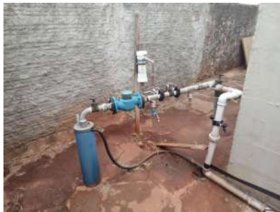
Foto 1 - Muro do complexo recalque 3.
