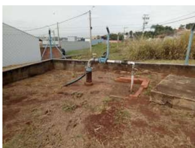
Foto 1 - Cerca do poço.
