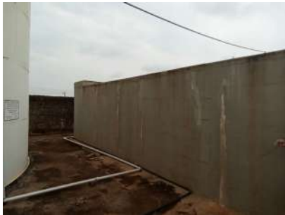
Foto 2 - Vista geral do reservatório.
