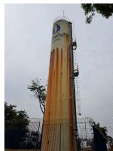
Foto 4 - Vista geral do reservatório elevado.
