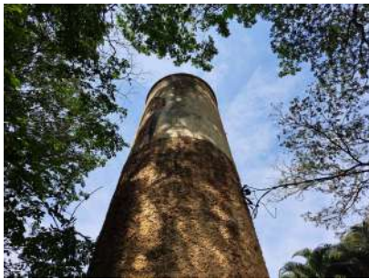
Foto 1 - Sinal de vazamento na lateral do reservatório.
