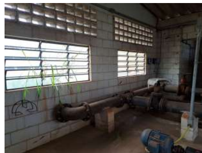
Foto 2 - Vista interna da EEAT.
