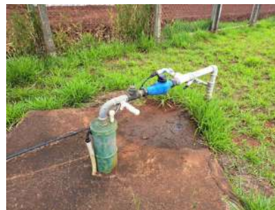
Foto 2 - Vista geral do poço.
