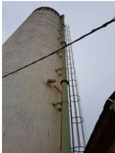
Foto 5 - Vista geral do reservatório elevado.
