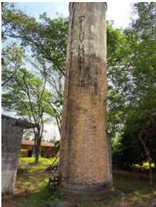
Foto 3 - Vista geral do reservatório elevado.
