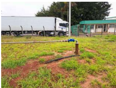
Foto 1 - Novo Poço do Distrito Industrial V.
