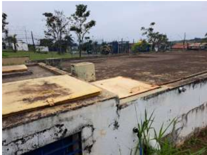
Foto 3 - Vista da cobertura do reservatório semi-enterrado.
