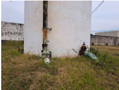
Foto 6 - Vista geral do reservatório elevado.
