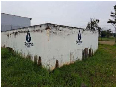
Foto 4 - Vista da lateral do reservatório semi-enterrado.
