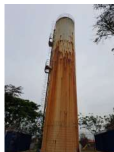
Foto 2 - Vista geral do reservatório elevado.
