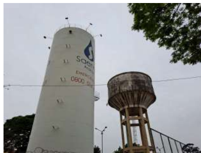
Foto 2 - Novo reservatório elevado (aço) ao lado do antigo (concreto).
