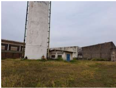
Foto 2 - Vista geral do reservatório elevado e da EEAT ao lado.
