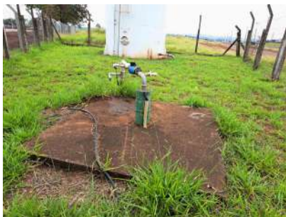
Foto 1 - Vista geral do poço.
