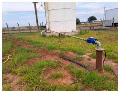
Foto 2 - Novo Poço do Distrito Industrial V.
