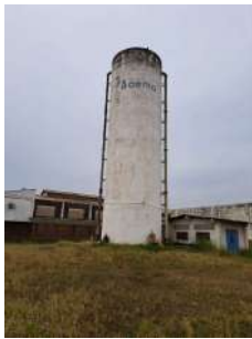
Foto 1 - Vista geral do reservatório elevado.
