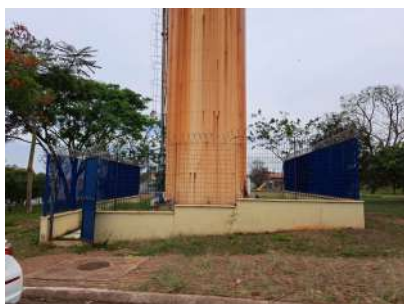
Foto 1 - Vista geral do reservatório elevado.
