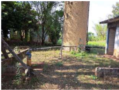
Foto 1 - Vista geral do poço e do reservatório elevado.
