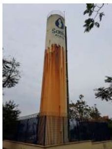
Foto 3 - Vista geral do reservatório elevado.
