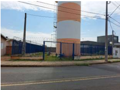
Foto 3 - Vista geral do reservatório elevado.
