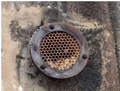
Foto 2 - Detalhe para o tamanho da abertura da tela na saída do tubo extravasor.
