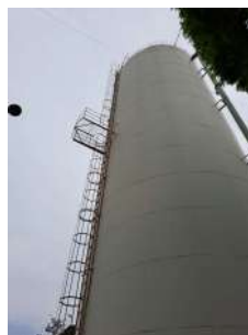
Foto 4 - Vista geral da escada e guarda-corpos do reservatório.
