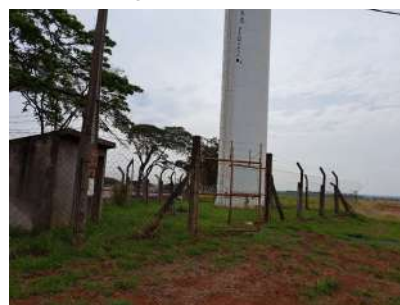
Foto 3 - Vista geral do reservatório elevado.
