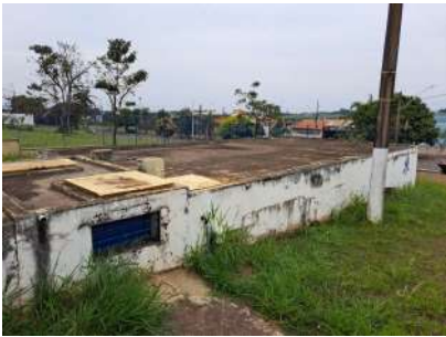
Foto 2 - Vista geral do reservatório semi-enterrado.
