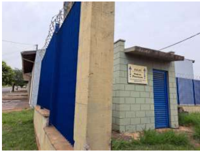
Foto 1 - Vista da EEAT Pedras Preciosas.
