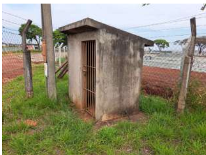
Foto 3 - Vista do abrigo dos produtos químicos e bombas dosadoras.
