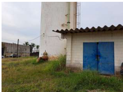
Foto 1 - Vista da entrada da EEAT e reservatório elevado (esquerda).
