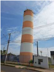
Foto 2 - Vista geral do reservatório elevado.
