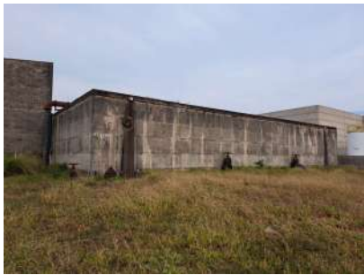
Foto 1 - Vista do reservatório apoiado.
