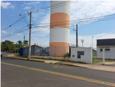
Foto 1 - Vista geral do reservatório elevado.
