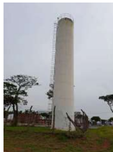
Foto 2 - Vista geral do reservatório elevado.
