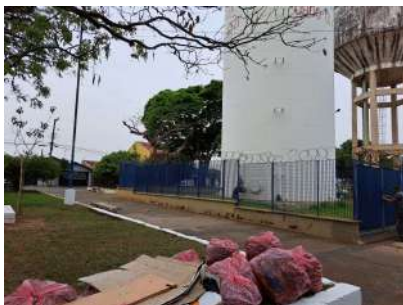
Foto 1 - Vista da parte externa do reservatório.
