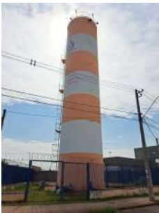
Foto 4 - Vista geral do reservatório elevado.
