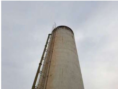
Foto 7 - Vista geral do reservatório elevado.
