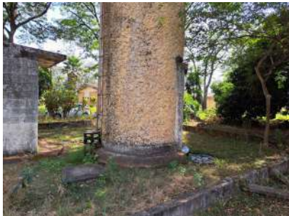
Foto 5 - Vista geral do reservatório elevado.
