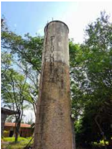
Foto 4 - Vista geral do reservatório elevado.
