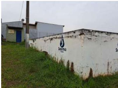
Foto 5 - Vista da lateral do reservatório semi-enterrado.
