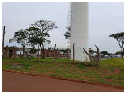
Foto 1 - Vista geral do reservatório elevado e do poço.
