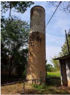
Foto 2 - Vista geral do reservatório elevado.
