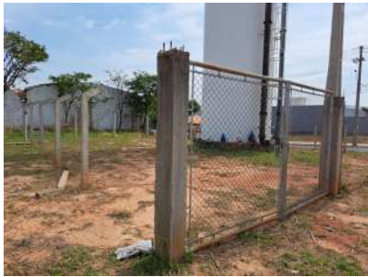
Foto 1 - Vista geral do reservatório.
