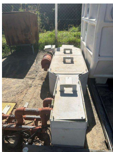
Foto 6 - Canal de entrada de esgoto bruto
