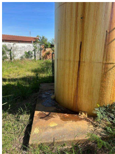
Foto 5 - Vazamentos
