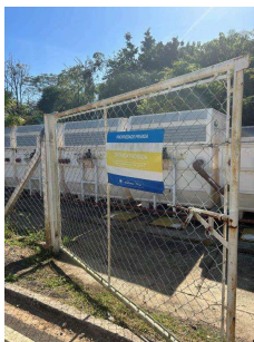
Foto 1 - Portão de acesso
