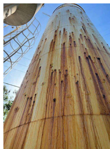
Foto 2 - Vazamentos
