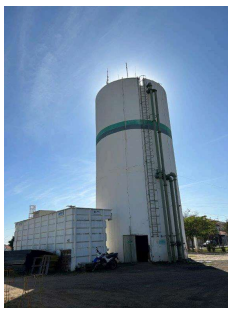
Foto 1 - Vista do reservatório
