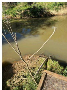
Foto 7 - Lançamento do efluente
