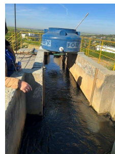
Foto 2 - Entrada de água bruta
