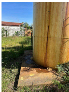
Foto 1 - Vazamentos
