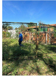
Foto 2 - Portão de Acesso
