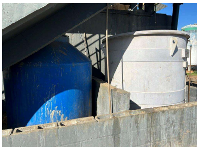
Foto 7 - Armazenamento de produtos químicos
