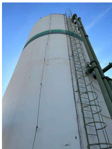
Foto 3 - Vista do acesso escada
