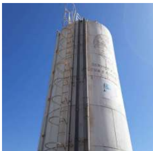
Foto 1 - Descida do tubo extravasor.
