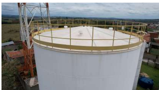
Foto 1 - Imagem da tubulação de ventilação capturada com drone em 27/09/2022.
