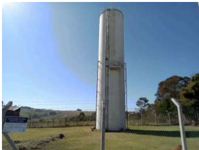
Foto 1 - Vista geral do reservatório.
