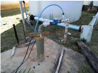
Foto 2 - Vista geral do poço.
