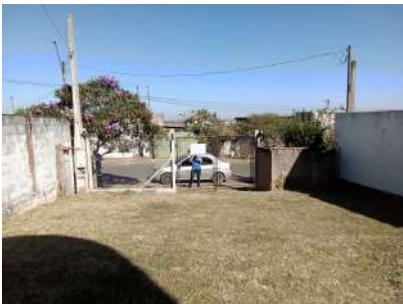
Foto 2 - Cerca do poço vista interna.
