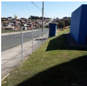
Foto 1 - Vista da cerca da EEA.
