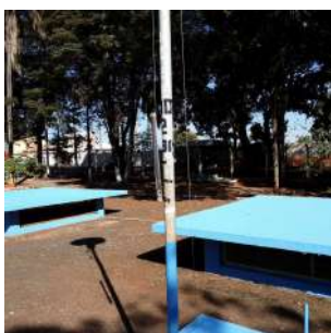
Foto 1 - Medidor de nível do reservatório.
