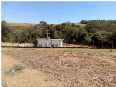
Foto 1 - Vista geral da EEEB.
