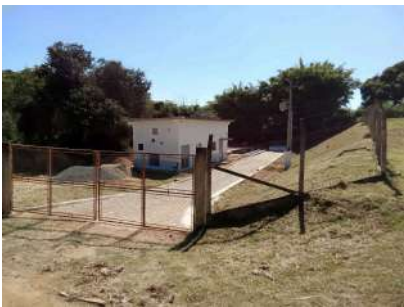
Foto 2 - Vista geral da EEEB.
