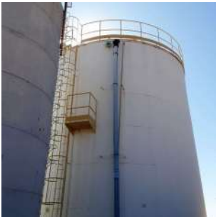
Foto 1 - Vista geral do reservatório.
