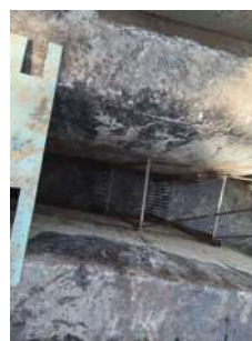
Foto 2 - Vista do gradeamento grosseiro da EEEB.
