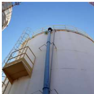
Foto 1 - Extravasar com tela de proteção.
