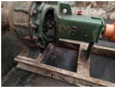
Foto 4 - Limpeza do efluente acumulado no interior da casa de bombeamento.
