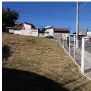
Foto 2 - Vista da cerca da EEA.
