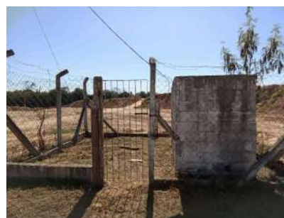
Foto 2 - Acesso ao poço.
