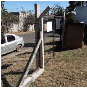
Foto 1 - Cerca do reservatório.
