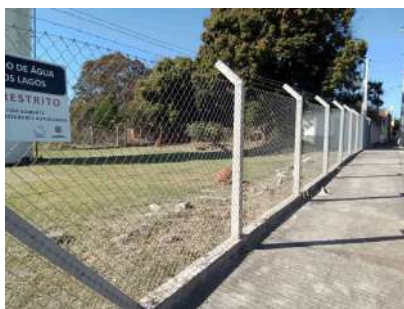
Foto 1 - Cerca do reservatório.
