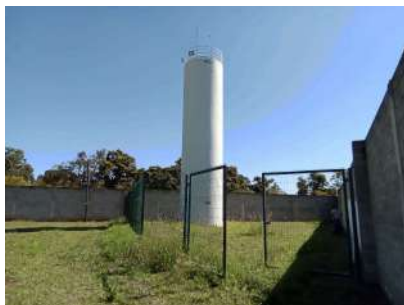
Foto 1 - Vista geral do reservatório.
