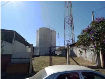
Foto 1 - Vista geral externa.
