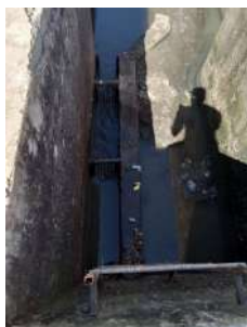
Foto 1 - Gradeamento grosseiro da EEEB.
