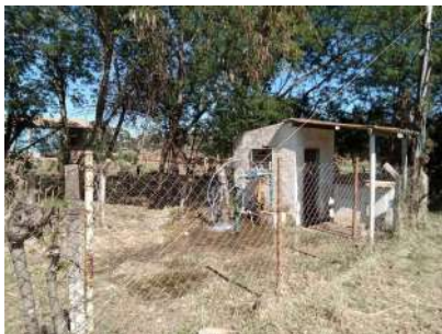
Foto 1 - Cerca do poço.
