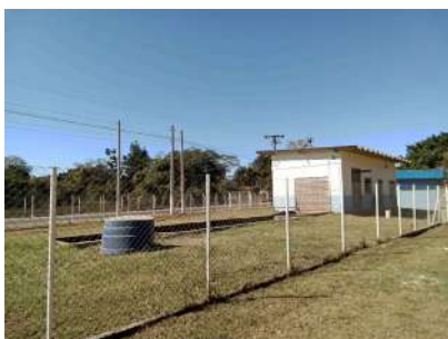
Foto 1 - Cerca da EEEB.
