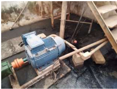
Foto 3 - Limpeza do efluente acumulado no interior da casa de bombeamento.
