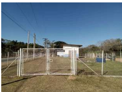
Foto 1 - Portão de acesso à EEEB.
