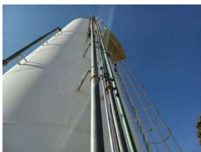
Foto 1 - Descida do cabeamento do SPDA.
