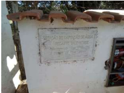
Foto 1 - Placa de identificação do poço.
