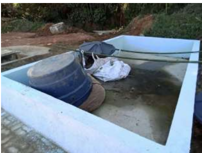
Foto 4 - Baía de contenção da EEEB.
