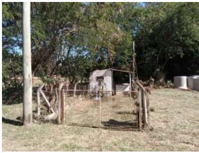
Foto 1 - Vista geral do poço.
