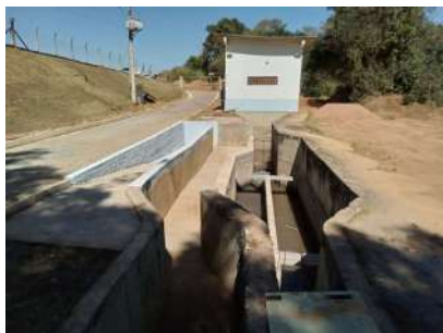
Foto 3 - Vista geral do preliminar da EEEB.
