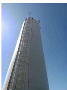
Foto 1 - Descida do cabeamento do SPDA.
