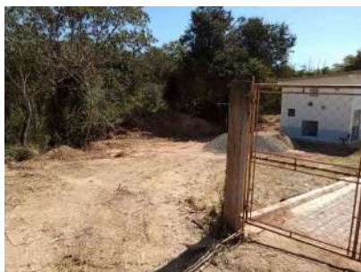
Foto 1 - A EEEB está em obras de reforma e sem cerca.
