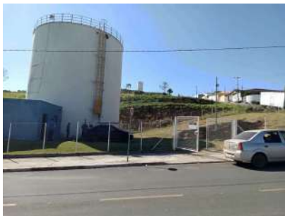
Foto 1 - Cerca do reservatório.
