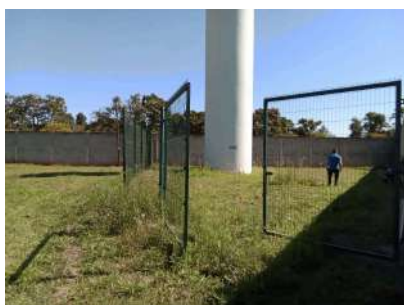
Foto 1 - Cerca do reservatório.
