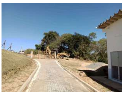
Foto 1 - Acesso à EEEB.
