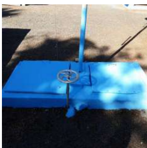
Foto 1 - Tampa de inspeção do reservatório.
