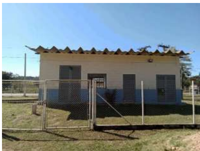
Foto 1 - Vista geral da EEEB.
