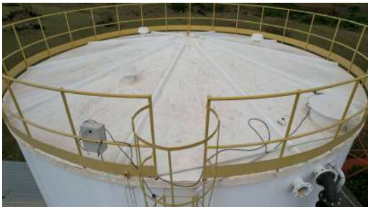
Foto 1 - Imagem da tampa de inspeção capturada com drone em 27/09/2022.
