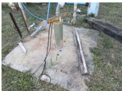
Foto 1 - Laje de proteção do poço.
