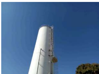
Foto 1 - Descida do tubo extravasor.
