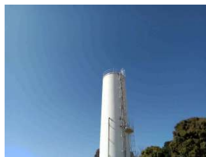
Foto 2 - Captador tipo Franklin.
