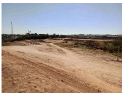
Foto 1 - Vista geral do poço.
