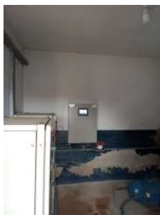
Foto 8 - Painel com telemetria - EEA Palmares
