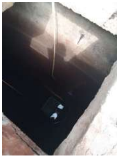
Foto 5 - Tampa de inspeção Reservatório ETA 1 R7 (2)
