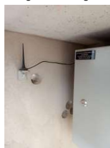
Foto 14 - Sistema de telemetria de vazão ao DAEE (2)
