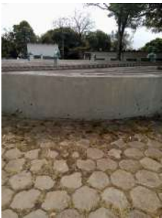
Foto 1 - Visão Geral Reservatório ETA 1 R7
