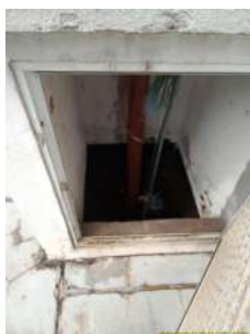
Foto 3 - Tampa para inspeção RESERVATÓRIO ETA 1 SEMIENTERRADO (R4)
