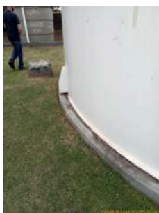
Foto 3 - Visão lateral - reservatório Sans Souci
