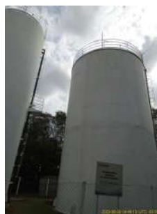
Foto 2 - Identificação - Reservatório Sans Souci
