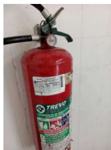
Foto 18 - Validade regular extintor de incêndio interno Captação Barragem das Figueiras
