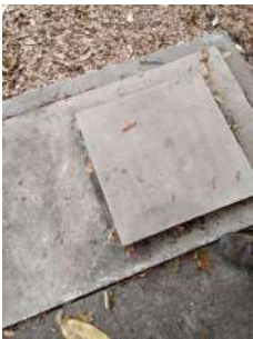
Foto 4 - Tampa de inspeção Reservatório ETA 1 R7
