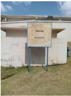
Foto 1 - Placa de identificação - Booster e Reservatório San Marino
