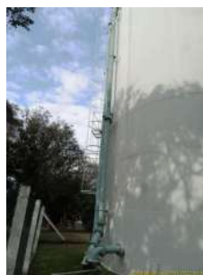
Foto 4 - Guarda-corpos - escada do Reservatório Sans Souci
