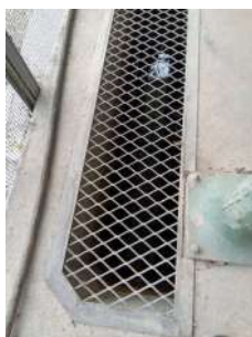
Foto 11 - Grade sobre Captação Barragem das Figueiras
