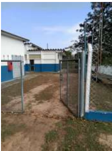
Foto 2 - Entrada Captação Barragem das Figueiras
