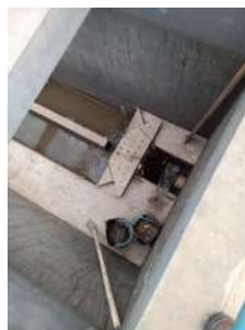
Foto 4 - Gradeamento grosso EE VIVENDA DOS PÁSSAROS
