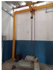
Foto 5 - Guindaste para manutenção dos conjuntos motobomba
