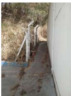
Foto 3 - Cercamento com alambrado
