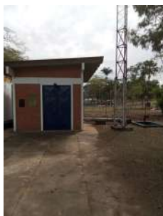
Foto 1 - Casa de bombas da EA Poços Profundos
