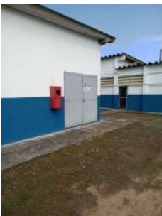
Foto 3 - Localização de extintor de incêndio Captação Barragem das Figueiras
