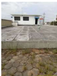
Foto 1 - Visão Geral - RESERVATÓRIO ETA 1 SEMIENTERRADO (R4)
