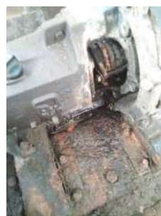
Foto 8 - Estado de conservação dos conjunto motobomba
