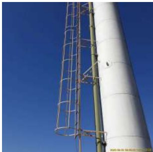
Foto 1 - Guarda-corpos RES - CRD - ALPHAVILLE ELEVADO
