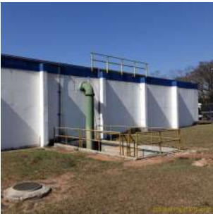
Foto 4 - Visão geral RES - CRD - PADRE ANCHIETA - RESERV. APOIADO B (3)
