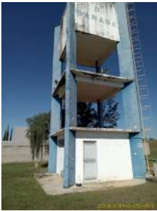
Foto 3 - Visão geral RES - CRD - SÃO RAFAEL - RESERV. ELEVADO (2)
