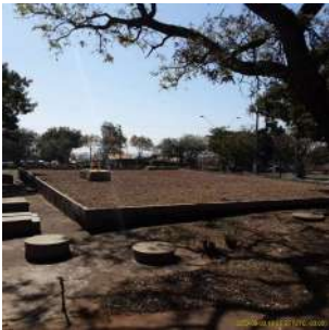
Foto 1 - Visão Geral Reservatório Anchieta Enterrado A
