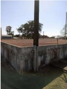
Foto 1 - Estrutura lateral - RES - CRD - PUCC - RESERV. SEMIENTERRADO
