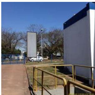
Foto 1 - Visão interna da entrada do RES - CRD - PADRE ANCHIETA - RESERV. APOIADO B com devido cercamento
