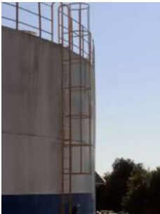
Foto 2 - Guarda-corpos RES - CRD - ALPHAVILLE RESERV. APOIADO A
