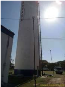
Foto 1 - Visão do RES - CRD - PADRE ANCHIETA - RESERV. ELEVADO - escada com guarda-corpos
