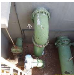
Foto 2 - Extravasor RES - CRD - PADRE ANCHIETA - RESERV. APOIADO B
