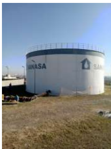
Foto 1 - Visão Geral RES - CRD - FEAC - RESERV. APOIADO
