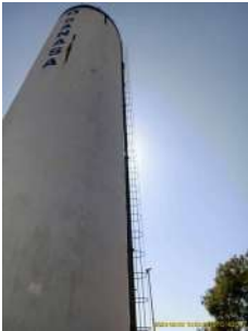
Foto 2 - Visão do RES - CRD - PADRE ANCHIETA - RESERV. ELEVADO - escada com guarda-corpos
