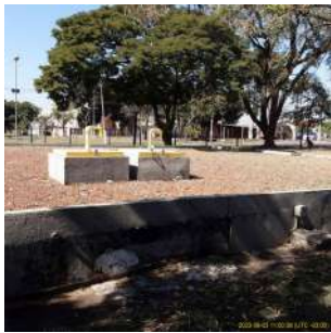
Foto 3 - Ventilação Reservatório Anchieta Enterrado A
