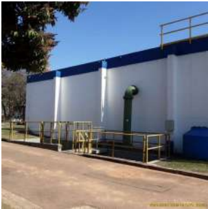
Foto 1 - Visão geral RES - CRD - PADRE ANCHIETA - RESERV. APOIADO B
