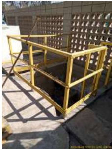
Foto 1 - Guarda-corpos EEBB TIC LOG
