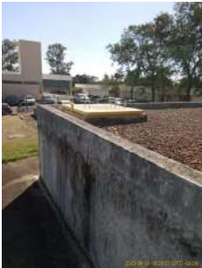
Foto 3 - Tampa de inspeção - RES - CRD - PUCC - RESERV. SEMIENTERRADO
