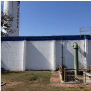
Foto 3 - Visão geral RES - CRD - PADRE ANCHIETA - RESERV. APOIADO B (2)
