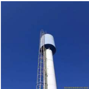
Foto 2 - Guarda-corpos RES - CRD - ALPHAVILLE ELEVADO
