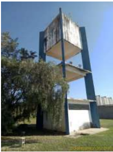
Foto 4 - Visão geral RES - CRD - SÃO RAFAEL - RESERV. ELEVADO (3)
