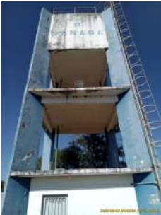
Foto 2 - Visão geral RES - CRD - SÃO RAFAEL - RESERV. ELEVADO
