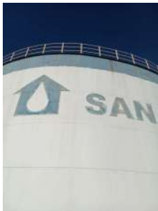
Foto 3 - Guarda-corpo RES - CRD - FEAC - RESERV. APOIADO
