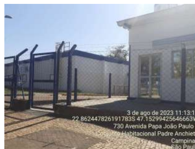
Foto 2 - Área de entrada do RES - CRD - PADRE ANCHIETA - RESERV. APOIADO B - visão externa
