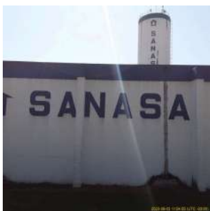
Foto 1 - Reservatório com pintura de identificação do prestador
