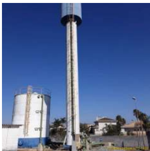
Foto 1 - Visão geral RES - CRD - ALPHAVILLE ELEVADO
