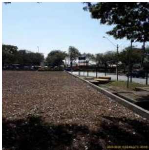
Foto 1 - Cercamento CRD Anchieta (visão interna)
