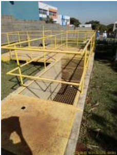
Foto 6 - Grades e guarda-corpos RES - CRD - PUCC - RESERV. SEMIENTERRADO
