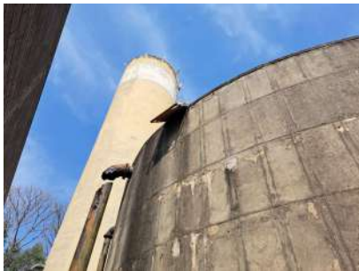
Foto 1 - Tampa de inspeção aberta.
