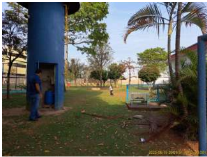
Foto 1 - Vista geral do Poço Campo Verde e o Reservatório ao lado.
