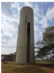
Foto 3 - Vista do Reservatório Elevado Chácara Letônia.
