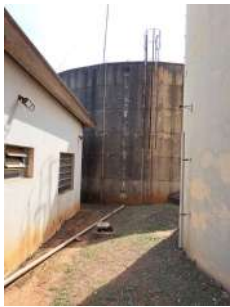
Foto 1 - Vista do Reservatório apoiado (ao fundo), da EEAT (esquerda) e do Reservatório elevado (direita).
