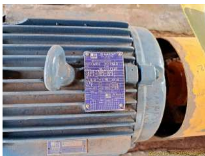
Foto 5 - Placa de especificações técnicas do motor do primeiro conjunto motobomba.
