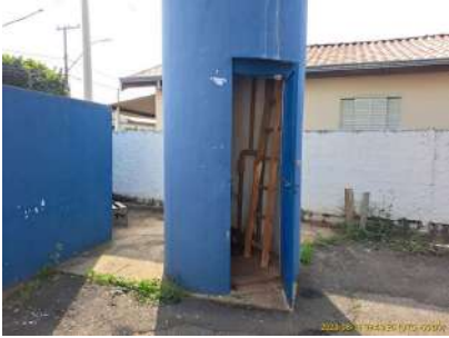
Foto 6 - Base do Reservatório do Poço São Vito.
