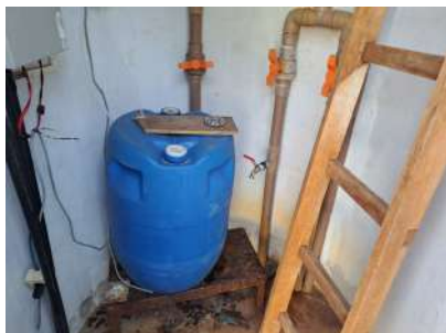
Foto 1 - Tomada de água bruta.
