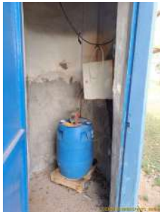
Foto 3 - Vista interna da base do Reservatório do Poço Campo Verde.
