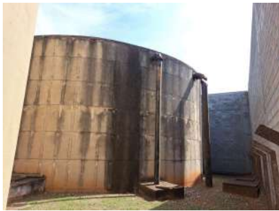
Foto 2 - Vista do Reservatório apoiado.
