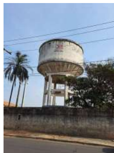
Foto 2 - Reservatório elevado São Vito
