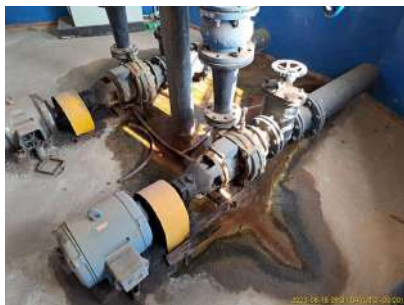
Foto 1 - Drenagem inadequada da água de lubrificação das gaxetas.
