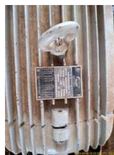
Foto 7 - Placa de especificações técnicas do motor do primeiro conjunto motobomba de recalque para o Reservatório elevado.
