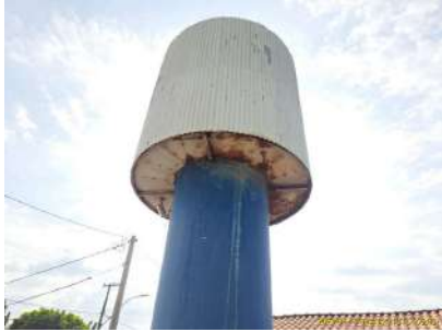
Foto 5 - Reservatório do Poço São Vito.
