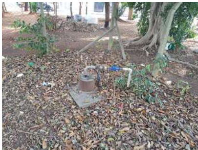
Foto 1 - Laje de proteção do poço.
