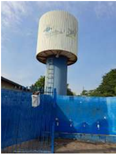
Foto 3 - Bebedouro público e, ao fundo, Reservatório do Poço São Vito.
