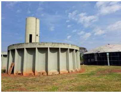
Foto 2 - Vista do Reservatório apoiado de concreto.
