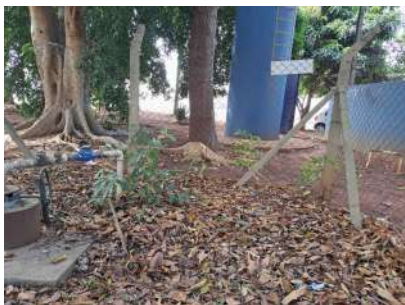
Foto 2 - Poço Carioba (frente e à esquerda) e Reservatório do Poço Carioba (ao fundo).
