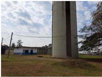
Foto 2 - Vista do Reservatório Elevado Chácara Letônia.
