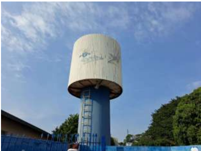
Foto 2 - Reservatório do Poço São Vito.
