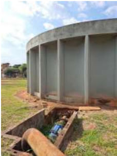
Foto 4 - Motobomba em linha na saída da tubulação do Reservatório.
