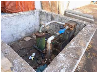
Foto 3 - Poço São Vito
