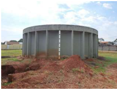
Foto 1 - Vista do Reservatório apoiado de concreto.
