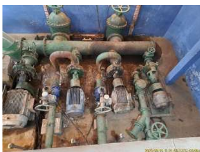
Foto 3 - Conjuntos (5 e 6) que recalcam para o Bairro Cidade Jardim.
