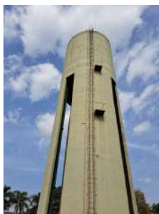
Foto 5 - Vista do Reservatório Elevado Chácara Letônia.
