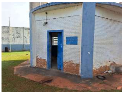
Foto 1 - Vista da entrada da EEAT.
