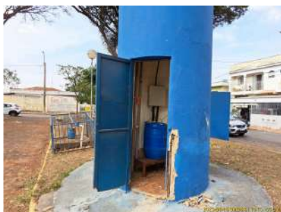
Foto 3 - Vista da base do Reservatório e, ao fundo, o Poço Belvedere.
