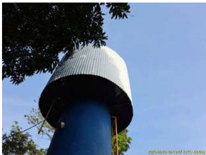
Foto 3 - Reservatório do Poço Campo Verde.
