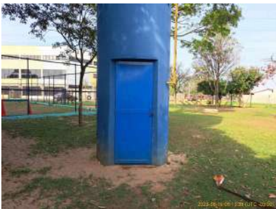
Foto 2 - Base do reservatório do Poço Campo Verde.
