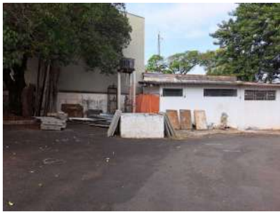
Foto 1 - Vista do local do Poço São Vito
