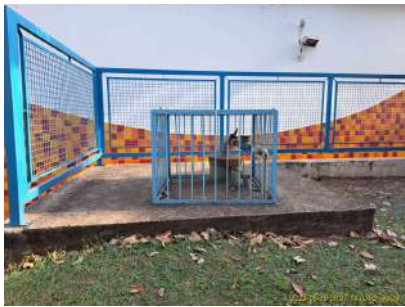
Foto 2 - Vista geral do Poço Campo Verde
