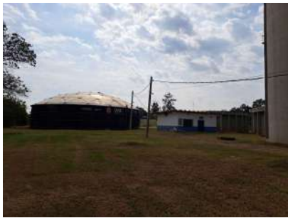
Foto 1 - Vista geral do Centro de Reservação Chácara Letônia.
