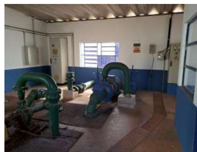
Foto 2 - Vista interna da EEAT.
