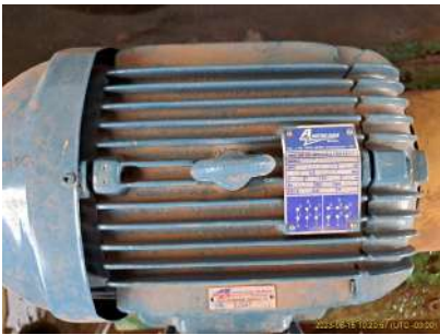
Foto 10 - Placa de especificações técnicas do motor do segundo conjunto motobomba de recalque para o Reservatório elevado.
