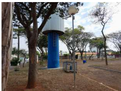
Foto 1 - Poço Belvedere e Reservatório ao lado
