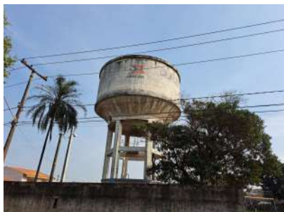
Foto 1 - Reservatório elevado São Vito
