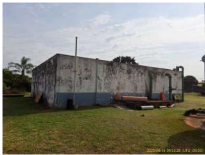
Foto 1 - Reservatório apoiado São Vito.
