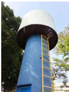
Foto 1 - Reservatório do Poço Campo Verde.
