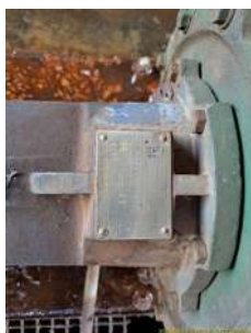
Foto 8 - Placa de especificações técnicas da bomba do primeiro conjunto motobomba de recalque para o Reservatório elevado.
