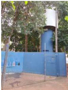
Foto 4 - Bebedouro público e Reservatório do Poço Carioba.
