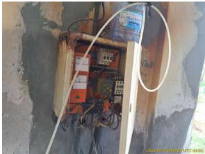
Foto 4 - Vista interna da base do Reservatório do Poço Campo Verde.
