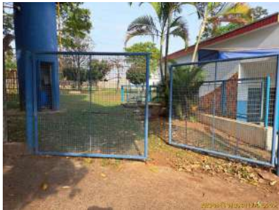
Foto 2 - Vista geral do Poço Campo Verde e o Reservatório ao lado.
