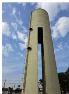
Foto 4 - Vista do Reservatório Elevado Chácara Letônia.
