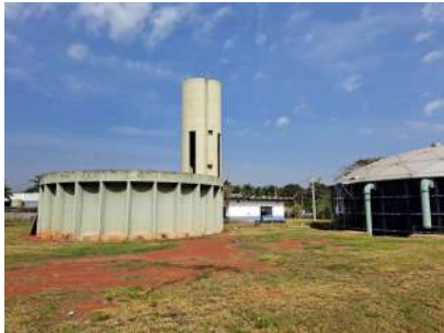
Foto 3 - Vista do Reservatório apoiado de concreto (esquerda), elevado (fundo) e o novo de aço vitrificado (direita).
