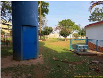
Foto 4 - Reservatório e Poço Campo Verde.
