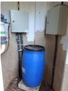
Foto 4 - Vista interna da base do Reservatório do Poço Carioba.
