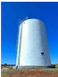
Foto 3 - Vista geral do reservatório
