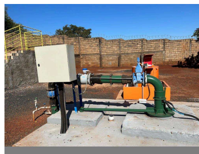
Foto 6 - Vista geral do barrilete
