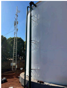
Foto 3 - Vista geral do reservatório
