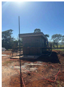
Foto 6 - Obras iniciais da ETE
