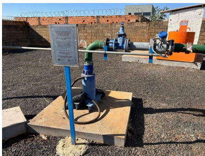
Foto 1 - Vista do barrilete
