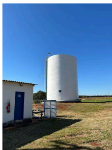
Foto 3 - vista interna da área
