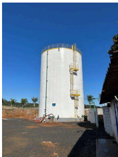
Foto 1 - Vista geral do reservatório
