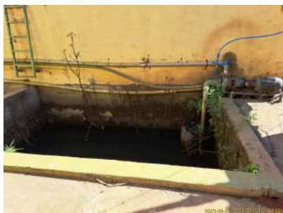
Foto 1 - Primeiro tanque de destinação do lodo da ETA.
