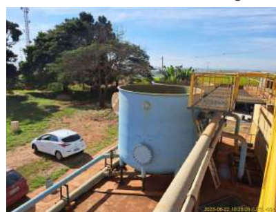
Foto 5 - Vista do local dos novos filtros da ETA I.
