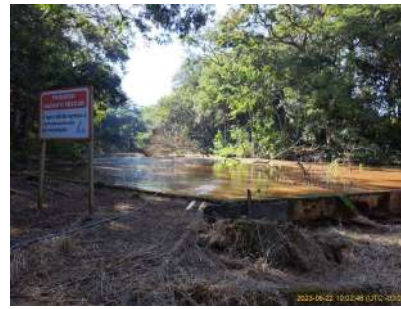
Foto 13 - Represa de Captação São José Viegas.
