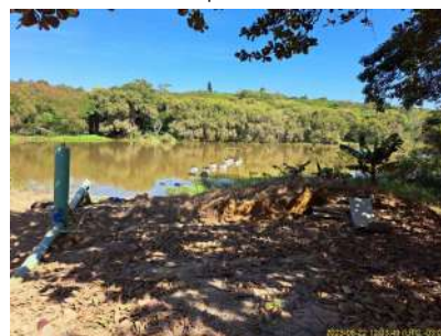
Foto 6 - Vista geral da captação na Represa São Jorge II.
