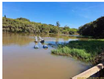
Foto 4 - Vista da tubulação na balsa flutuante na represa.
