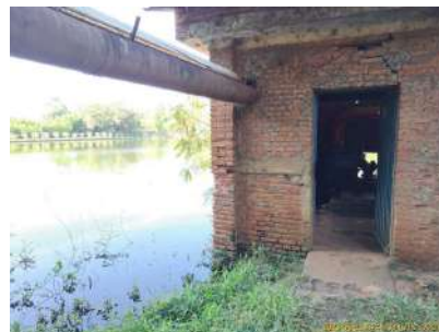
Foto 2 - Vista geral da Represa Bom Jesus I e da casa de bombas.
