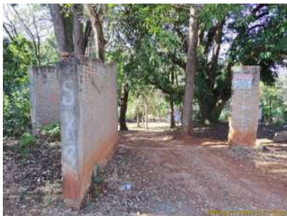
Foto 17 - Entrada da Captação São José Viegas
