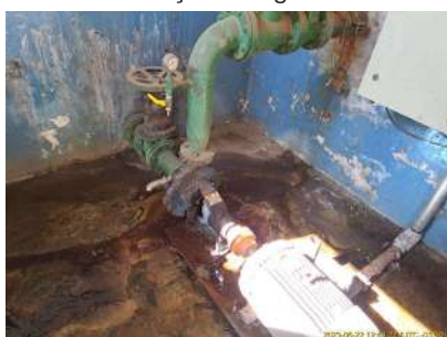
Foto 3 - Drenagem inadequada da água de lubrificação das gaxetas.
