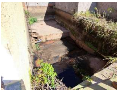
Foto 4 - Segundo tanque de destinação do lodo.
