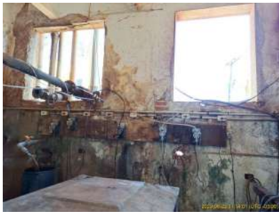
Foto 1 - Situação da parede lateral onde estão as bombas dosadoras de produtos químicos.
