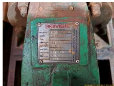
Foto 2 - Placa de especificações técnicas da bomba do conjunto motobomba de menor porte (secundário)
