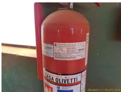
Foto 1 - Validade do extintor de incêndio expirada. Foto 2 - Validade do extintor de incêndio expirada.
