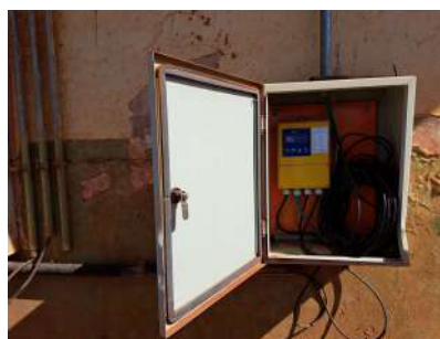
Foto 2 - Painel do macromedidor, com valores de vazão incoerentes.
