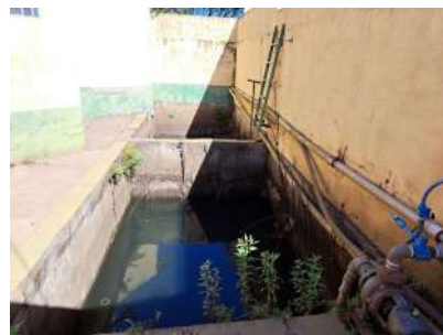
Foto 2 - Primeiro tanque de destinação do lodo.
