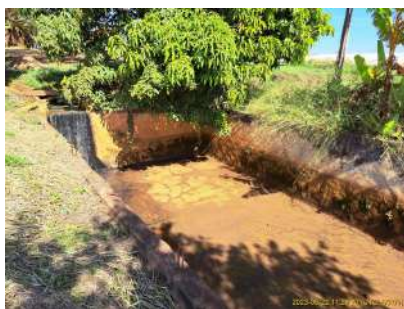
Foto 1 - Tanque de destinação de lodo das ETAs 1-2.
