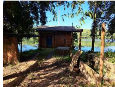
Foto 6 - Vista geral da Represa Bom Jesus I e da casa de bombas.
