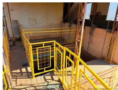
Foto 4 - Vista do local dos filtros antigos da ETA I.
