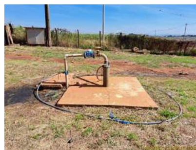
Foto 2 - Vista geral do Poço.
