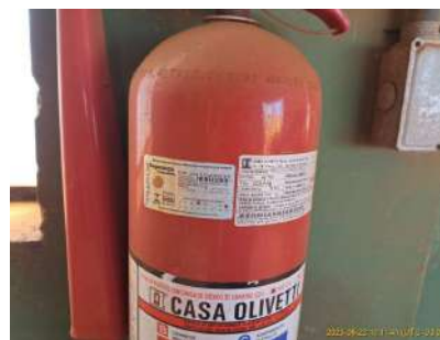
Foto 1 - Validade do extintor de incêndio expirada. Foto 2 - Validade do extintor de incêndio expirada.
