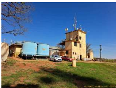
Foto 1 - Vista da ETA 1 (filtros azuis e prédio à direita) e ETA II (à esquerda, atrás dos filtros azuis).
