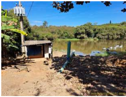
Foto 7 - Vista geral da captação na Represa São Jorge II.
