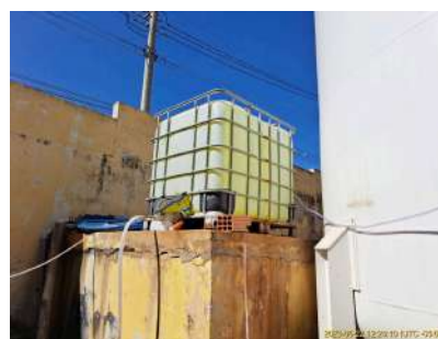
Foto 7 - Armazenamento de produtos químicos.
