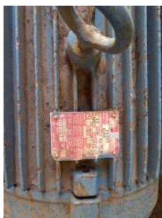
Foto 6 - Placa de especificações técnicas do motor do conjunto motobomba Bom Jardim.
