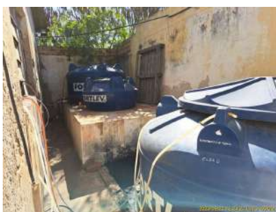
Foto 6 - Armazenamento de produtos químicos.
