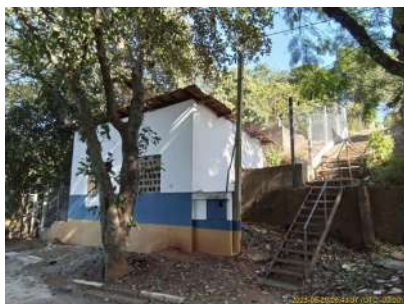
Foto 1 - Vista externa de acesso ao reservatório.
