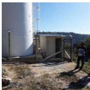
Foto 1 - Vista geral da EEA.
