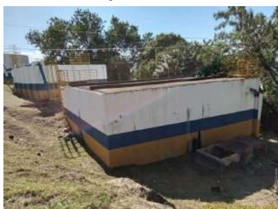
Foto 6 - Vista geral do reservatório R4.
