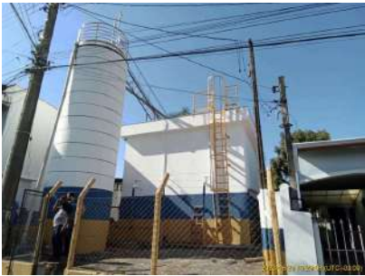
Foto 1 - Vista geral dos reservatórios.
