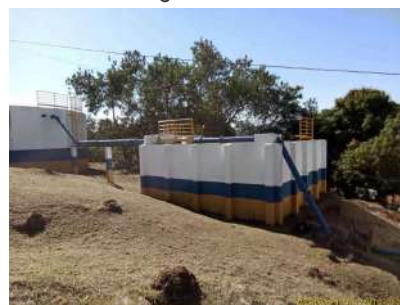
Foto 5 - Vista geral do reservatório R5.
