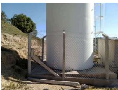
Foto 1 - Vista da cerca do reservatório.
