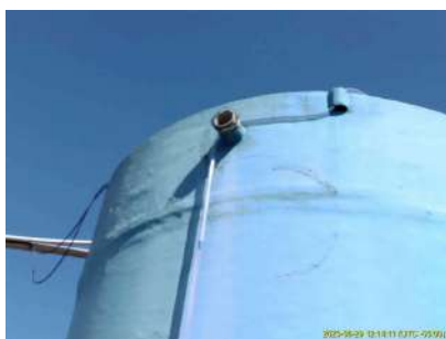
Foto 1 - Tela de proteção com abertura grande.
