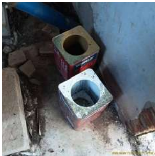
Foto 2 - Acúmulo de resíduos de construção civil.
