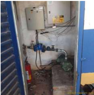
Foto 1 - Vista da parte interna da EEA.
