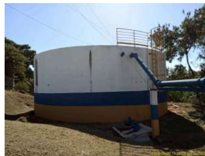
Foto 2 - Vista geral do reservatório R2.
