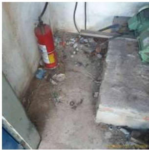
Foto 1 - Remover resíduo sólido de construção civil.
