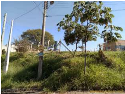
Foto 2 - Vista geral do reservatório.
