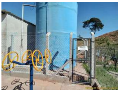
Foto 1 - Cerca externa do reservatório.
