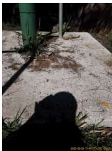
Foto 1 - Laje de proteção do poço.
