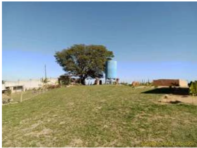
Foto 1 - Vista geral do reservatório.
