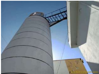
Foto 2 - Extravasor do reservatório cilíndrico.
