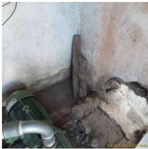
Foto 2 - Remover resíduo sólido de construção civil.
