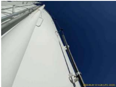
Foto 1 - Descida do cabeamento do SPDA.
