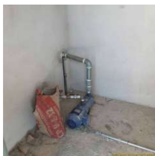
Foto 1 - Vista interna da EEA.
