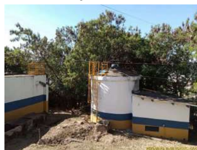
Foto 7 - Vista geral do reservatório R1.
