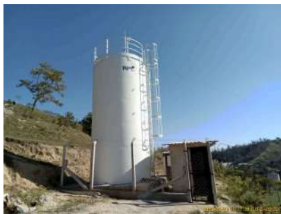
Foto 1 - Vista geral do reservatório.
