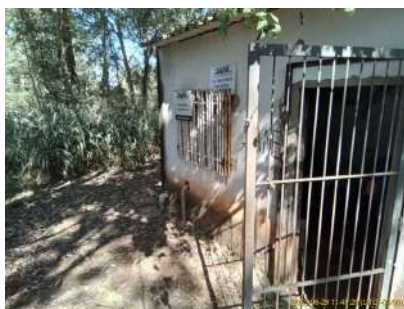
Foto 1 - Vista geral da casa de bombeamento.
