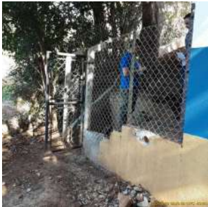
Foto 2 - Vista do cercamento da EEA.
