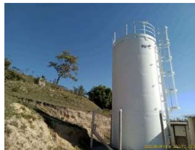
Foto 2 - Vista geral do reservatório.
