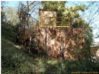
Foto 1 - Vista geral do reservatório.
