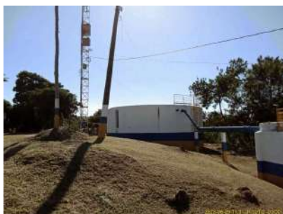
Foto 4 - Vista geral do reservatório R2.
