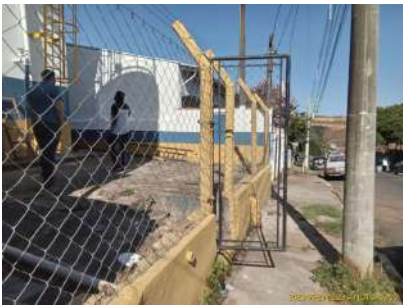
Foto 1 - Cerca externa dos reservatórios.
