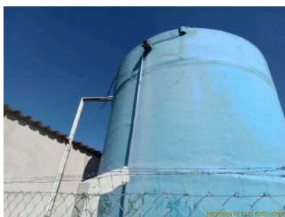
Foto 1 - Medição de nível com mangueira externa.
