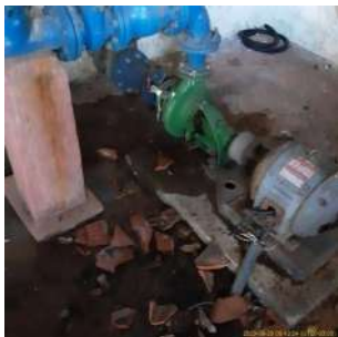
Foto 1 - Vazamento no sistema de bombeamento. Foto 2 - Vazamento no sistema de bombeamento.
