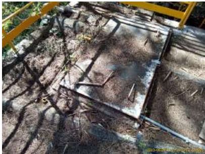
Foto 1 - Tampa de inspeção do reservatório.
