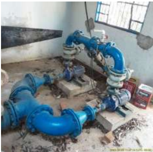
Foto 1 - Vista da parte interna da EEA.
