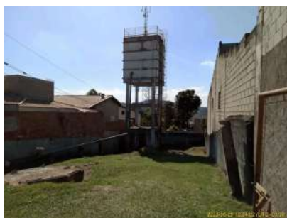
Foto 1 - Vista geral do reservatório.
