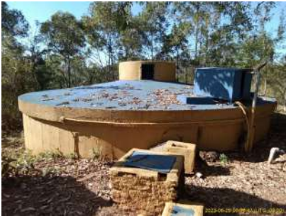
Foto 2 - Vista geral do reservatório.
