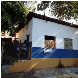
Foto 1 - Vista externa da EEA.
