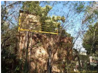
Foto 2 - Vista geral do reservatório.
