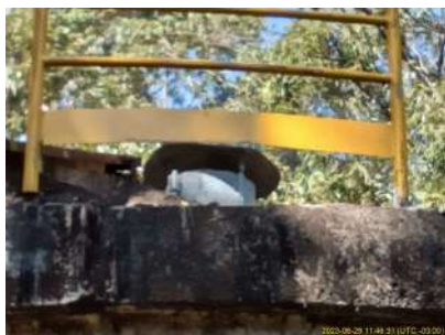
Foto 1 - Respiro sem tela de proteção.
