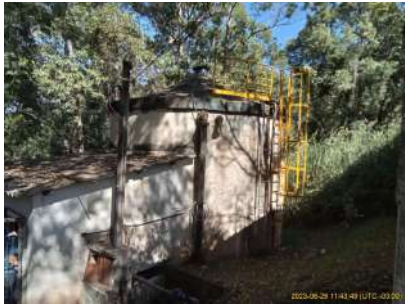
Foto 2 - Vista geral do reservatório.
