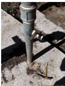
Foto 1 - Tomada de água.
