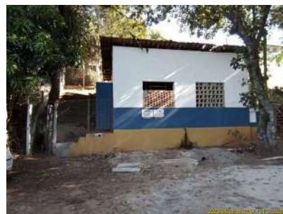
Foto 2 - Vista externa de acesso ao reservatório.
