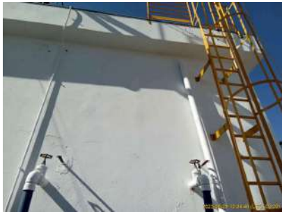
Foto 1 - Extravasor do reservatório quadrado.
