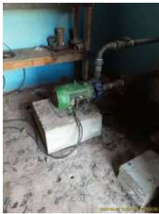
Foto 1 - Vista interna da EEA.
