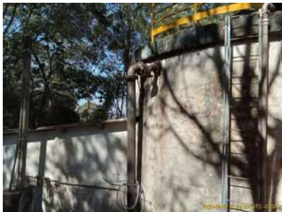
Foto 1 - Extravador do reservatório.
