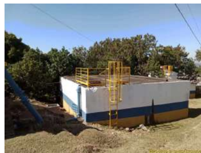
Foto 3 - Vista geral do reservatório R4.
