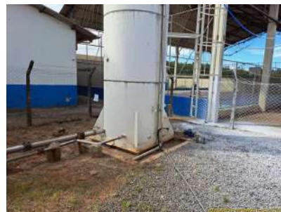
Foto 4 - Vista geral da base do Reservatório.
