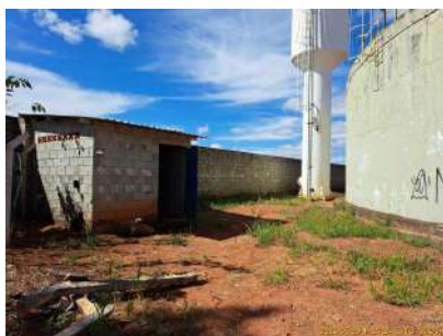
Foto 1 - Estação elevatória ao lado dos Reservatórios Chaparral.
