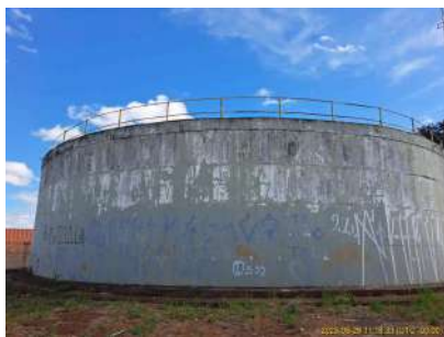
Foto 1 - Guarda-corpos do Reservatório.
