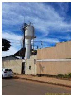
Foto 1 - Vista geral do Reservatório.
