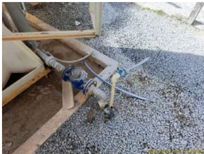
Foto 1 - Local de tomada de água bruta na chegada ao reservatório.
