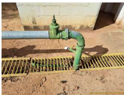
Foto 1 - Tomada de água do Poço.
