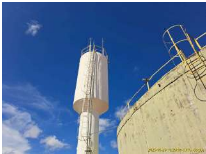
Foto 3 - Vista geral da parte superior do Reservatório elevado.
