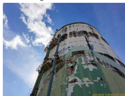
Foto 4 - Vista geral do Reservatório elevado.
