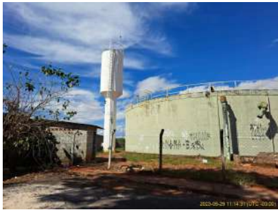
Foto 2 - Vista do Reservatório Apoiado e, ao fundo, o Reservatório elevado Chaparral e a EEAT Chaparral.
