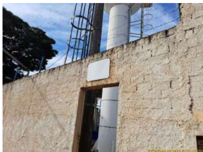
Foto 3 - Vista geral da entrada do Reservatório.
