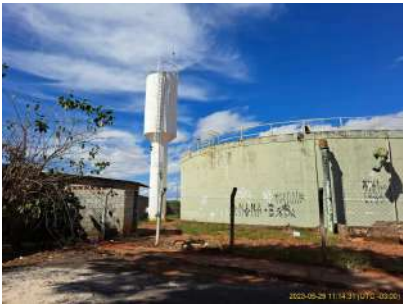
Foto 4 - Vista do Reservatório Apoiado e, ao fundo, o Reservatório elevado Chaparral e a EEAT
