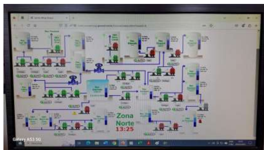
Foto 1 - Sistema de telemetria do abastecimento de água de Mogi Guaçu.
