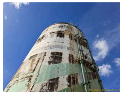
Foto 2 - Vista geral do Reservatório elevado.
