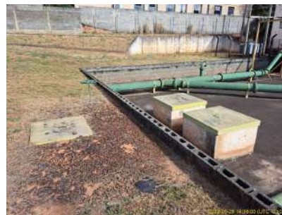
Foto 2 - Tampas de inspeção.
