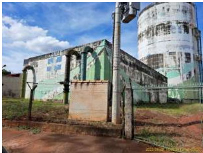
Foto 2 - Vista geral do Reservatório apoiado e, ao fundo, o Reservatório elevado.
