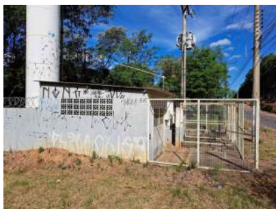
Foto 3 - Vista lateral da EEAT Jd. Alvorada e do Reservatório elevado
