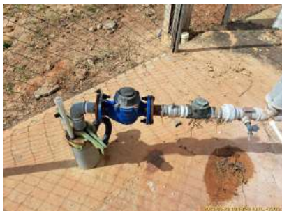
Foto 1 - Laje de proteção do Poço.
