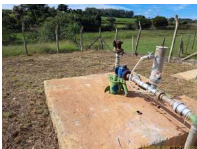
Foto 1 - Laje de proteção do Poço.
