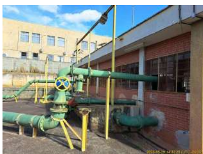
Foto 1 - Vista lateral da Estação Elevatória Vila Paraíso
