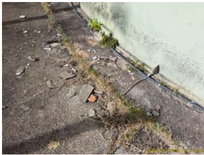
Foto 2 - Cabo de aterramento do Reservatório.
