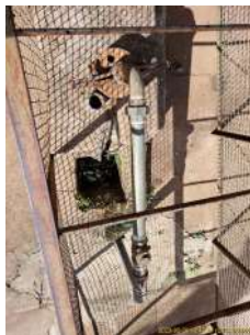
Foto 3 - Vista superior do Poço.
