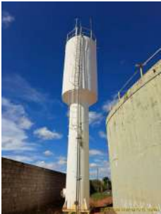
Foto 1 - Vista geral do Reservatório elevado.
