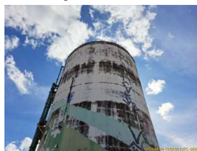
Foto 5 - Vista geral do Reservatório elevado.
