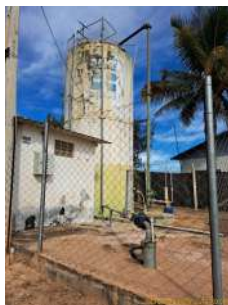
Foto 3 - Vista geral do Reservatório e do Poço
