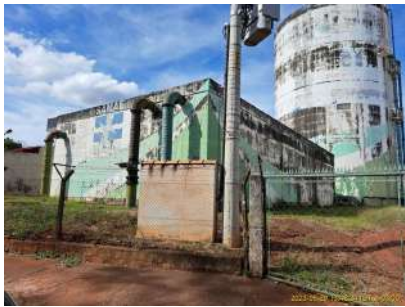
Foto 7 - Vista geral do Reservatório apoiado e, ao fundo, o Reservatório elevado.
