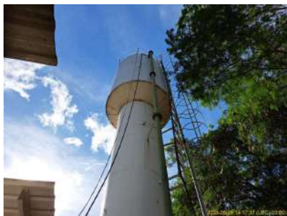
Foto 1 - Vista da parte superior do Reservatório elevado.
