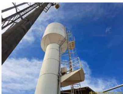
Foto 5 - Guarda-corpos do Reservatório.
