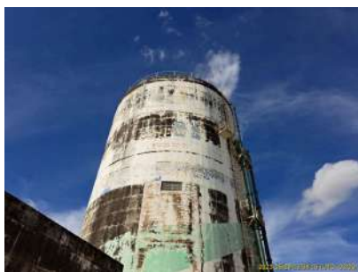
Foto 1 - Vista geral do Reservatório elevado.
