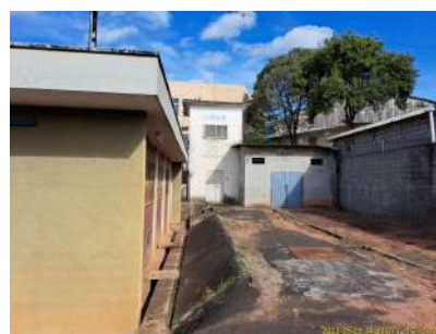
Foto 4 - Vista lateral da Estação Elevatória Vila Paraíso
