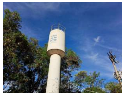
Foto 4 - Vista da parte superior do Reservatório elevado.
