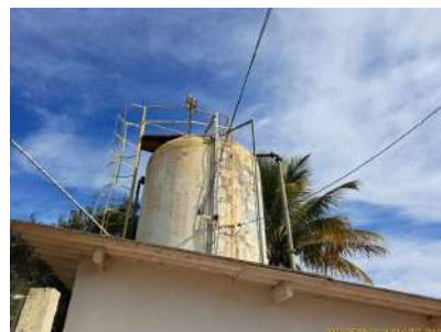
Foto 2 - Guarda-corpos do Reservatório.
