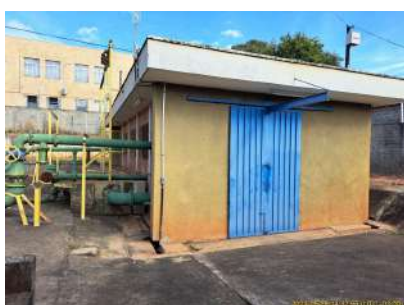
Foto 5 - Vista frontal da Estação Elevatória Vila Paraíso
