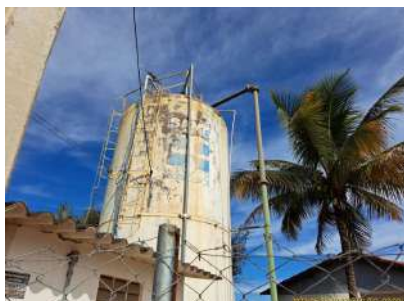
Foto 1 - Guarda-corpos do Reservatório.
