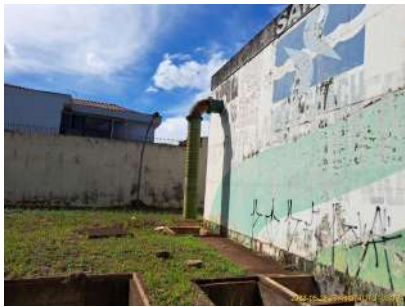
Foto 1 - Vista lateral do Reseratório, com detalhe para o tubo extravasor.
