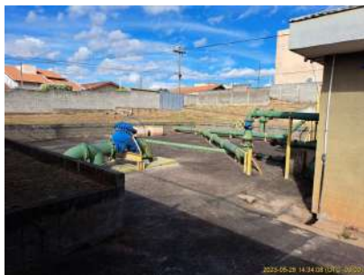
Foto 1 - Vista geral da cobertura do Reservatório enterrado Vila Paraíso.
