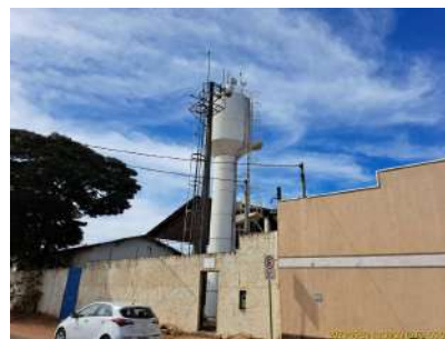
Foto 2 - Vista geral do Reservatório.
