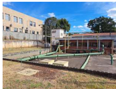
Foto 2 - Vista geral da cobertura do Reservatório enterrado Vila Paraíso.
