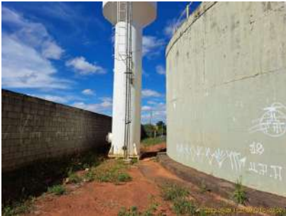
Foto 2 - Vista geral da base do Reservatório elevado.
