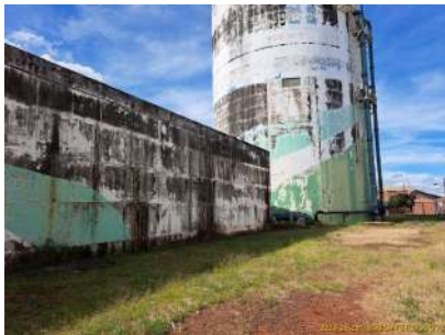
Foto 1 - Vista lateral do Reservatório apoiado e, ao fundo, o Reservatório elevado.
