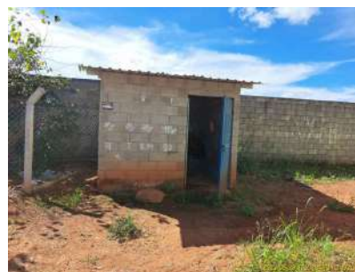
Foto 2 - Vista frontal da Estação elevatória.
