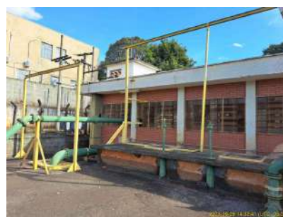
Foto 2 - Vista lateral da Estação Elevatória Vila Paraíso
