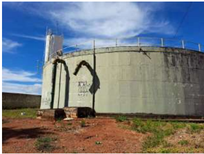
Foto 1 - Vista do Reservatório Apoiado.
