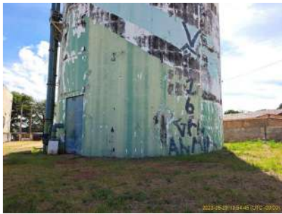
Foto 6 - Vista da base do Reservatório elevado.
