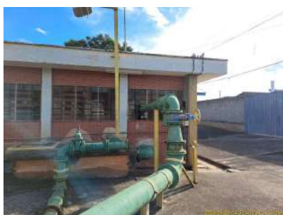
Foto 3 - Vista lateral da Estação Elevatória Vila Paraíso
