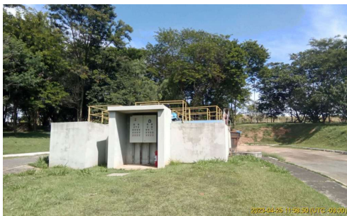
Foto 1 - Vista da entrada
