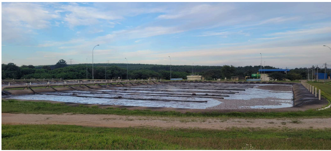
Foto 1 - Vista geral da ETE
