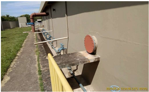
Foto 6 - Parede UASB - Vazamentos sanados
