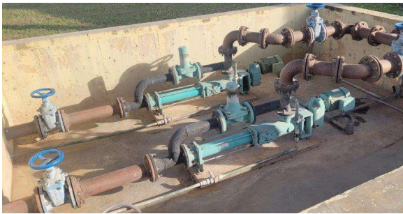
Foto 7 - Bombeamento de retorno de loco
