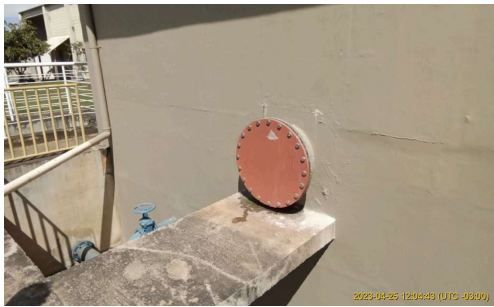
Foto 5 - Parede UASB - Vazamentos sanados
