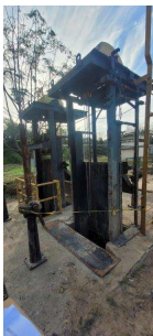
Foto 4 - Gradeamento mecanizado
