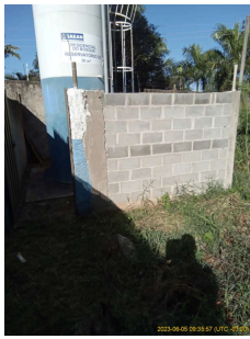
Foto 1 - Muro de cercamento do Reservatório Residencial do Bosque
