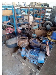
Foto 2 - Moto bomba reserva em um depósito na Estação de Tratamento de Água
