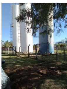
Foto 1 - Área dos Reservatórios devidamente cercada
