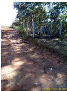
Foto 1 - Aspecto geral do Poço Sacilotto II Poço 1 com cercamento por alambrado
