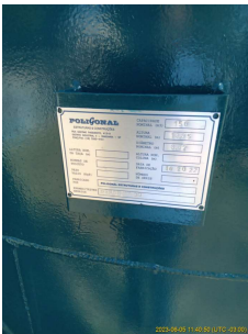
Foto 1 - Placa com detalhes do Reservatório (reformado)
