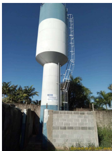
Foto 1 - Visão Geral do Reservatório Residencial do Bosque
