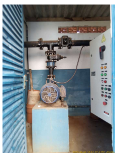
Foto 1 - Acesso para manutenção da elevatória
