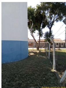
Foto 1 - Área devidamente cercada
