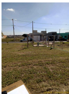
Foto 1 - Alambrados sem cercamento no Poço Vila Nogueira
