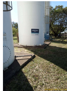
Foto 2 - Três reservatórios com identificação
