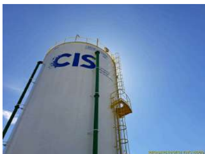
Foto 1 - Guarda-corpos nas escadas e na cobertura do Reservatório
