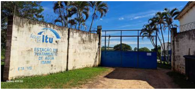
Foto 1 - Identificação da ETA Itaim
