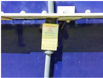
Foto 1 - Aviso referente à estrutura do SPDA no Reservatório.
