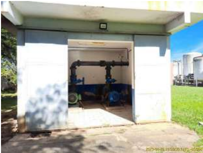
Foto 8 - Vista geral da EEAT para Bairro Potiguara e o Reservatório de água tratada da ETA Itaim
