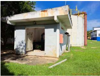
Foto 6 - Vista geral da EEAT para Bairro Potiguara e o Reservatório de água tratada da ETA Itaim
