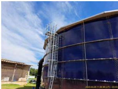
Foto 1 - Guarda-corpos da escada do Res. Apoiado da ETA Rancho Grande.
