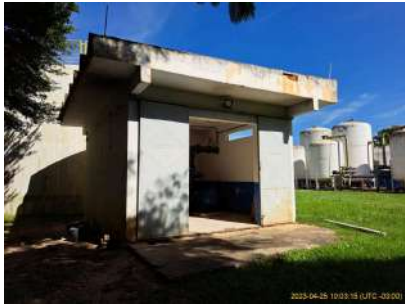
Foto 7 - Vista geral da EEAT para Bairro Potiguara e o Reservatório de água tratada da ETA Itaim
