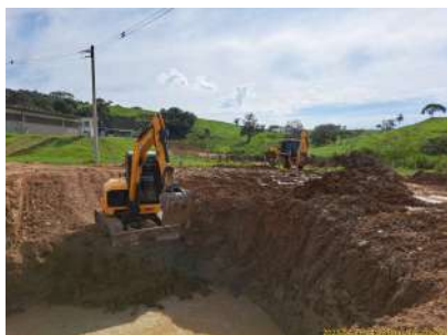
Foto 6 - Obras de ampliação da Captação Mombaça.
