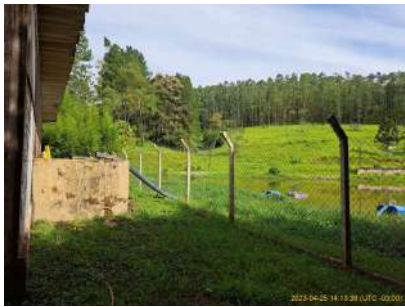
Foto 4 - Vista da Represa de Captação Pau D 'Alho e do tanque de equalização.
