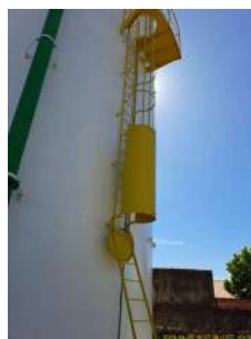
Foto 2 - Guarda-corpos nas escadas do Reservatório
