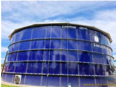
Foto 4 - Vista geral do Res. Apoiado da ETA Rancho Grande.
