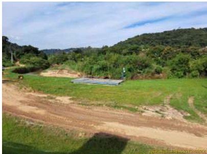
Foto 3 - Ausência de guarda-corpos no poço com registros de manobra das bombas de captação.
