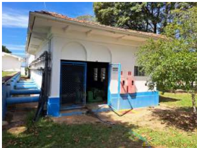
Foto 1 - Vista geral da Estação elevatória que abriga os 02 conjuntos referentes ao abastecimento do Reservatório Terras de São José.
