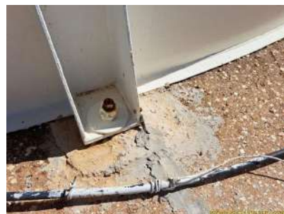
Foto 2 - Aterramento da estrutura metálica do Reservatório.
