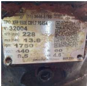
Foto 1 - Placa de identificação e especificação de uma das bombas reservas da Captação Pau D 'Alho
