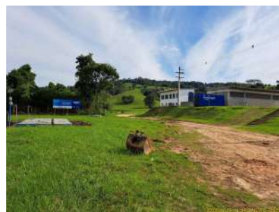
Foto 5 - Vista geral da Captação Mombaça.
