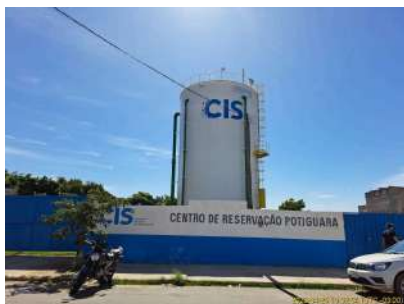
Foto 1 - Vista geral do Novo Reservatório Potiguará.
