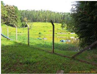
Foto 3 - Vista da Represa de Captação Pau D 'Alho
