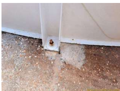
Foto 3 - Aterramento da estrutura metálica do Reservatório.
