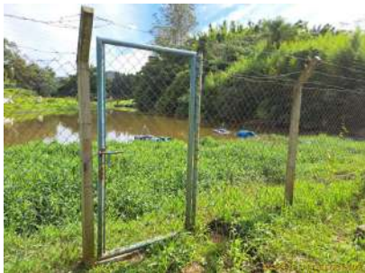
Foto 2 - Vista da Represa de Captação Pau D'Alho
