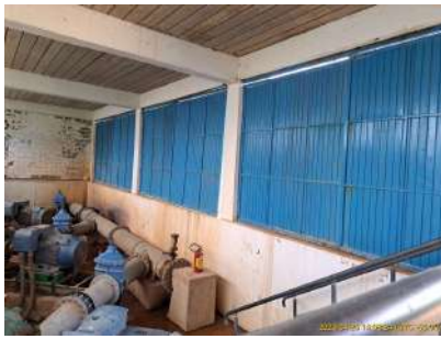
Foto 1 - Acesso para manutenção.
