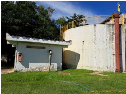
Foto 1 - Vista geral da EEAT para Bairro Potiguara e o Reservatório de água tratada da ETA Itaim
