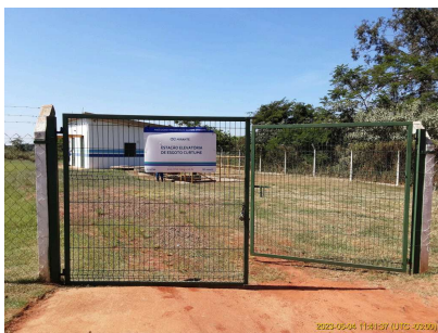
Foto 1 - Cercamento da área
