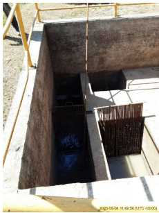
Foto 1 - Grademaento grosseiro operando normalmente
