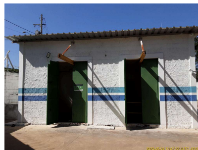
Foto 5 - Abrigo dos conjuntos motobomba
