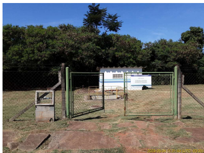
Foto 1 - Cercamento da área
