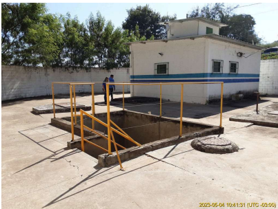
Foto 1 - Gradeamento à frente e abrigo dos conjuntos motobomba ao fundo
