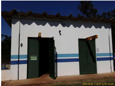
Foto 1 - Abrigo dos conjuntos motobomba
