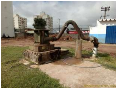
Foto 3 - Cavalete do poço Vila Nery
