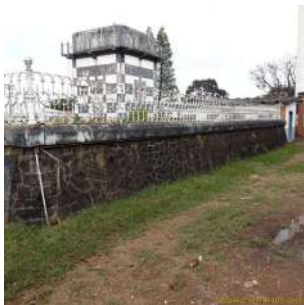
Foto 3 - Vista lateral 2 reservatório Vila Nery - Semi-enterrado (pedra)
