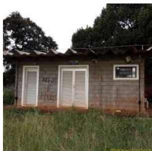
Foto 3 - Casa de armazenamento de produto químico
