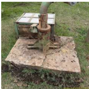
Foto 7 - Laje de proteção do poço Parque Fehr
