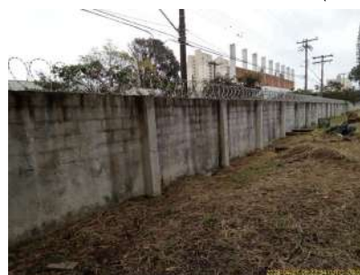
Foto 3 - Vista do cercamento de área do Centro de reservação Rui Barbosa
