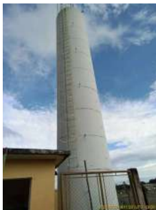
Foto 1 - Reservatório Tutoya do Vale
