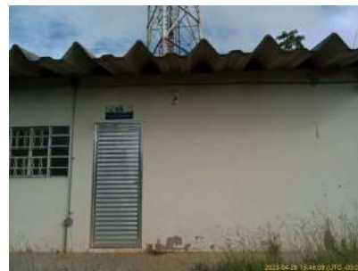
Foto 7 - Casa de dosagem de produto químico
