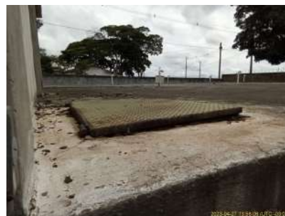
Foto 4 - Tampa de inspeção
