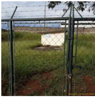
Foto 6 - Portão de acesso
