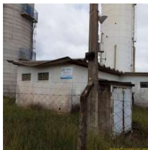
Foto 4 - Vista externa do centro de produção e reservação Embaré
