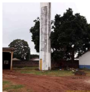
Foto 2 - Vista interna da área do reservatório Vila Nery Elevado 2 - Taça
