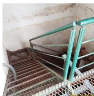
Foto 2 - Escada de acesso, com guarda-corpos
