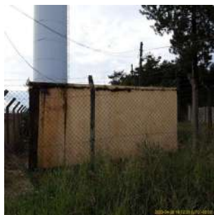
Foto 1 - Vista externa do reservatório apoiado Tutoya do Vale
