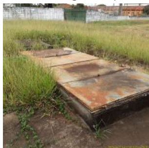
Foto 7 - Poço CDHU (Subterrâneo)
