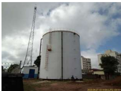
Foto 1 - Reservatório Vila Nery - Apoiado Novo
