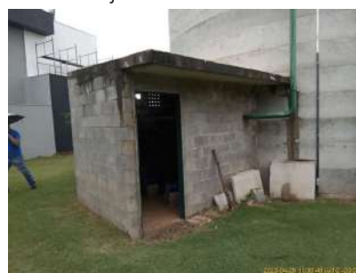
Foto 4 - Vista externa da estação elevatória Damha IV
