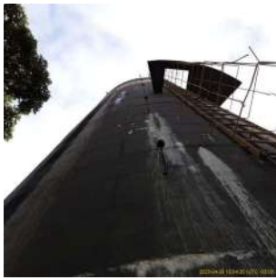
Foto 3 - Indícios de vazamentos aparentes no reservatório Samambaia
