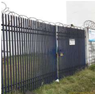
Foto 9 - Cercamento da área do poço e reservatório Parque Fehr
