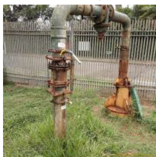
Foto 7 - Tomada de coleta de água
