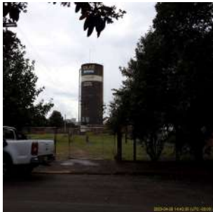
Foto 10 - Vista externa do poço e reservatório Jockey Club
