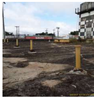
Foto 2 - Vista da laje de cobertura do reservatório Vila Nery - Semi-enterrado (pedra)
