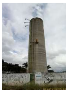
Foto 2 - Vista externa do reservatório CDHU
