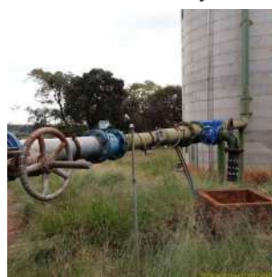
Foto 5 - Tomada para coleta de água
