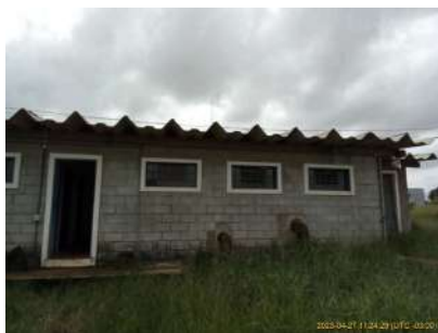
Foto 1 - Vista externa da estação elevatória Jardim do Bosque
