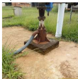
Foto 5 - Laje de proteção do poço Jardim do Bosque
