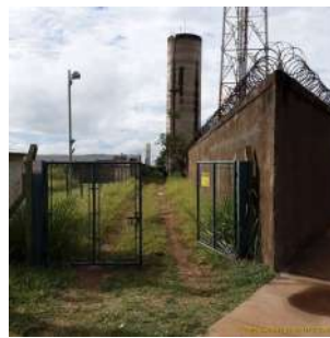
Foto 4 - Vista externa do centro de produção e reservação Eco Tecnológico Damha
