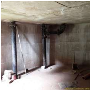
Foto 1 - Laje de fundo do reservatório Samambaia
