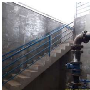
Foto 1 - Escada de acesso, com guarda-corpos
