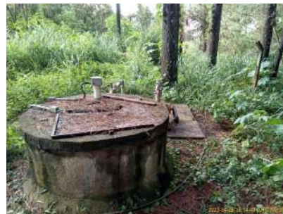
Foto 4 - Vista da área da estação elevatória de esgoto Samambaia
