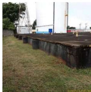
Foto 4 - Vista lateral 3 do reservatório Vila Nery Semi-enterrado II (concreto)
