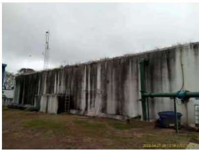
Foto 2 - Vista do reservatório Rui Barbosa (retangular)
