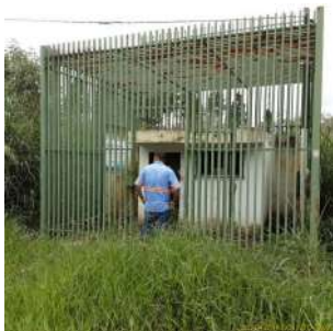
Foto 6 - Vista externa da EEEB Climax
