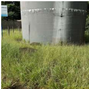
Foto 1 - Vista da área do reservatório Samambaia
