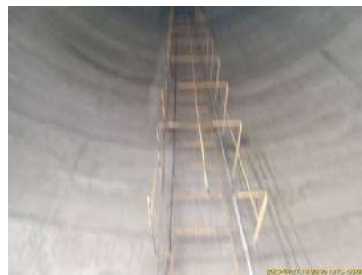
Foto 4 - Escada de acesso, com guarda-corpo
