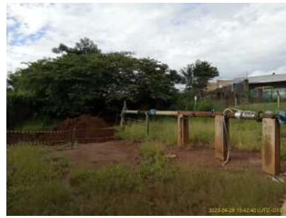
Foto 2 - Vista da área do poço e reservatório eco tecnológico Damha
