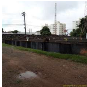
Foto 1 - Reservatório Vila Nery Semi-enterrado II (concreto)
