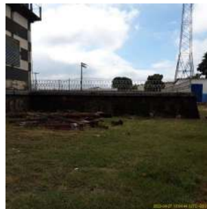
Foto 4 - Vista frontal do Vista lateral 2 reservatório Vila Nery - Semi-enterrado (pedra)
