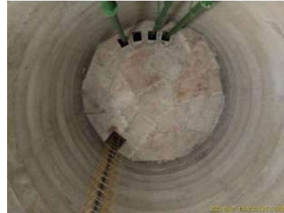
Foto 4 - Laje de fundo do reservatório Parque Fehr
