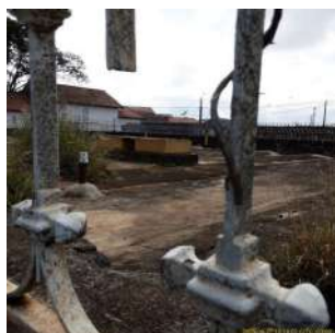
Foto 1 - Vista da laje de cobertura
