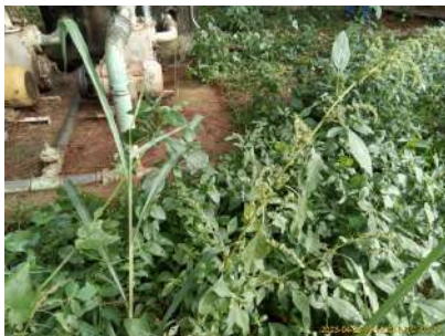
Foto 3 - Vista da área da estação elevatória de esgoto Samambaia
