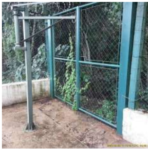
Foto 1 - Cercamento da área da EEEB Damha I
