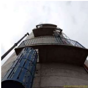
Foto 4 - Escada de acesso, com guarda-corpos
