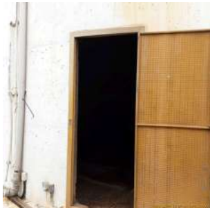
Foto 5 - Acesso ao interior do reservatório
