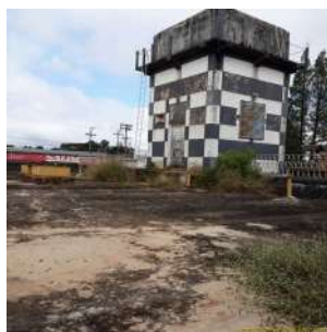
Foto 2 - Vista da laje de cobertura
