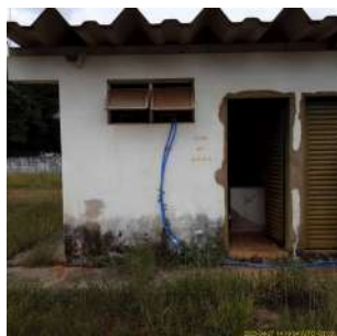
Foto 5 - Casa de dosagem de produto químico
