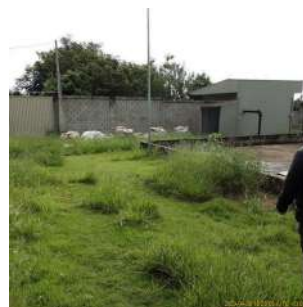
Foto 2 - Vista da área da estação elevatória de esgoto Faixa Azul
