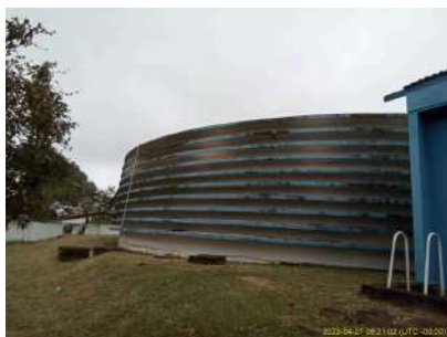
Foto 1 - Vista lateral do reservatório Rui Barbosa (circular)
