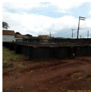
Foto 6 - Vista da área do reservatório
