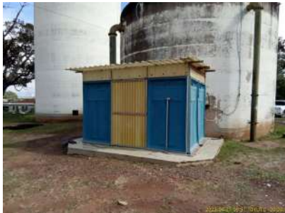
Foto 1 - Vista externa da casa de dosagem de produto químico
