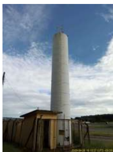
Foto 1 - Reservatório Tutoya do Vale
