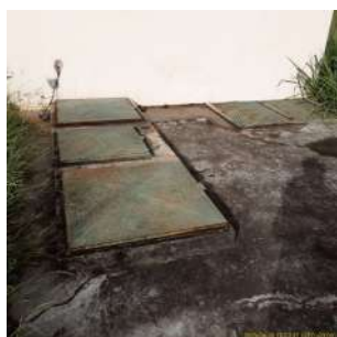
Foto 4 - Tampas de inspeção
