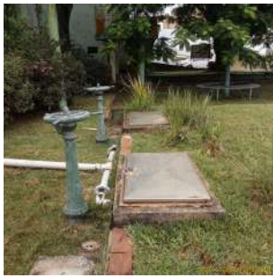
Foto 3 - Tampas de inspeção
