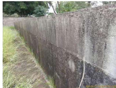
Foto 2 - Vista lateral do reservatório Cruzeiro do Sul
