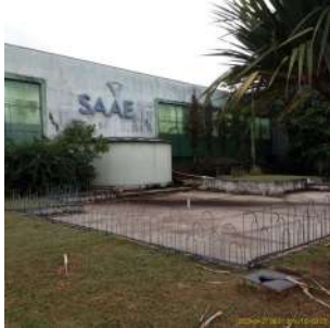
Foto 5 - Reservatório ETA Carlos Botelho
