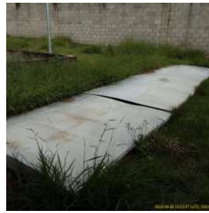
Foto 4 - Tampas de inspeção
