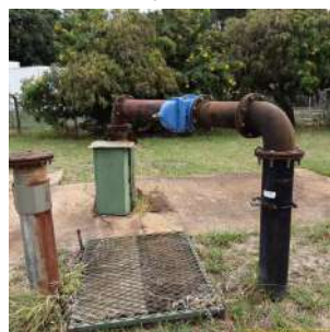
Foto 5 - Tomada para coleta de água
