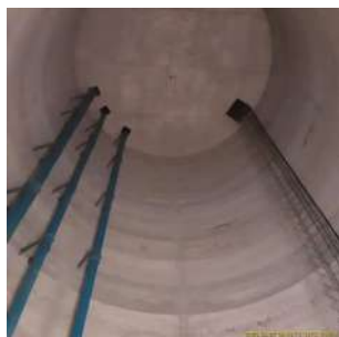
Foto 3 - Vista da laje de fundo do reservatório Vila Nery elevado I - Cilíndrico
