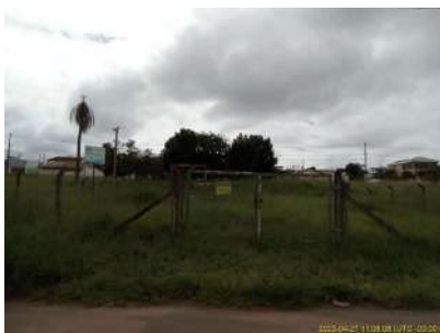
Foto 1 - Vista externa da estação elevatória de esgoto Embaré I
