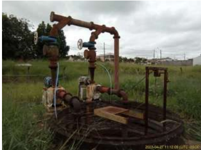
Foto 5 - Vista da estação elevatória de esgoto Embaré I
