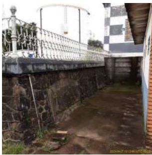
Foto 1 - Vista lateral 1 reservatório Vila Nery - Semi-enterrado (pedra)
