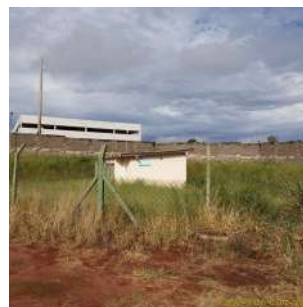
Foto 2 - Vista da área da estação elevatória de esgoto Eco Tecnológico Damha
