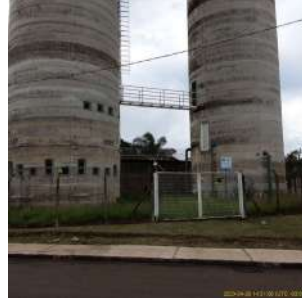
Foto 4 - Vista frontal dos reservatórios Village Damha I
