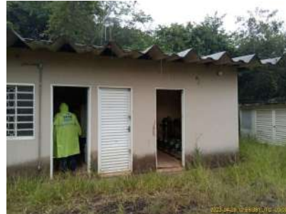
Foto 6 - Vista externa da estação elevatória Damha Capela
