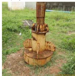
Foto 6 - Laje de proteção do poço Cruzeiro do Sul
