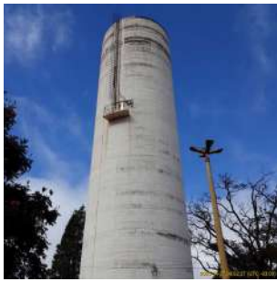
Foto 5 - Reservatório Vila Nery elevado I - Cilíndrico
