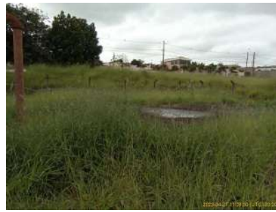
Foto 2 - Vista da área da estação elevatória de esgoto Embaré I
