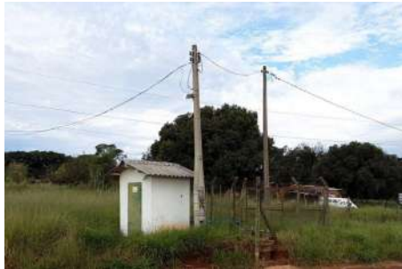
Foto 1 - Vista externa do poço
