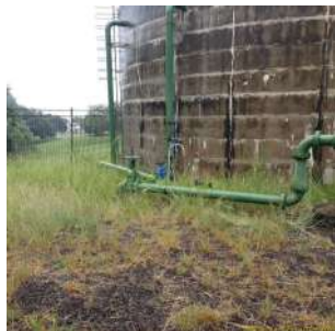
Foto 1 - Vista da área do poço e reservatório Damha Capela
