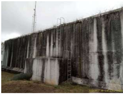
Foto 1 - Ausência de guarda-corpos na escada e na cobertura do reservatório
