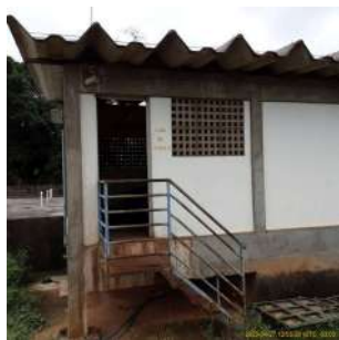
Foto 1 - Casa de dosagem de produto químico
