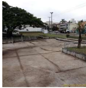
Foto 4 - Vista lateral da laje de cobertura do reservatório ETA Carlos Botelho
