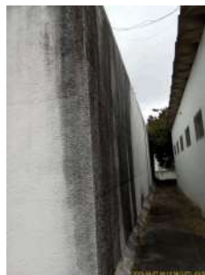
Foto 2 - Vista da parede lateral do reservatório Rui Barbosa (retangular))
