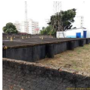
Foto 2 - Vista lateral 1 do reservatório Vila Nery Semi-enterrado II (concreto)
