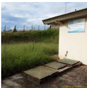
Foto 1 - Vista da área da estação elevatória de esgoto Eco Tecnológico Damha
