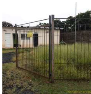
Foto 5 - Portão de acesso
