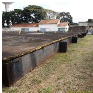
Foto 5 - Vista lateral 4 do reservatório Vila Nery Semi-enterrado II (concreto)
