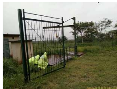
Foto 4 - Vista externa da estação elevatória Damha Golf
