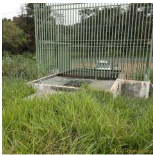
Foto 1 - Vista externa da estação elevatória de esgoto Climax
