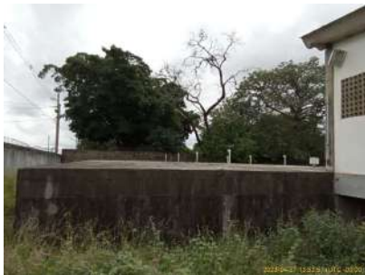
Foto 1 - Vista frontal do reservatório Cruzeiro do Sul
