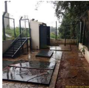
Foto 5 - Vista interna da da EEEB Damha I
