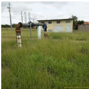
Foto 1 - Vista da área do poço e reservatório
