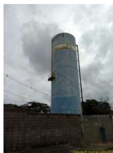
Foto 2 - Vista externa do Reservatório Cruzeiro do Sul
