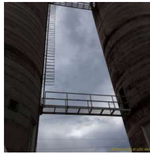
Foto 2 - Escada de acesso, com guarda-corpos
