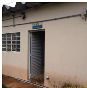
Foto 2 - Vista externa da casa de dosagem de produto químico
