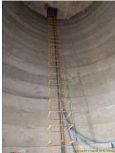
Foto 3 - Escada de acesso, com guarda-corpos
