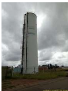
Foto 1 - Reservatório Jardim do Bosque
