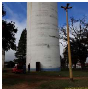
Foto 4 - Vista da área do reservatório Vila Nery elevado I - Cilíndrico
