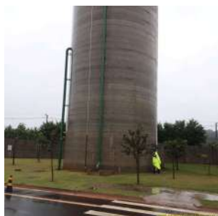
Foto 4 - Vista do reservatório Damha IV, no interior do condomínio
