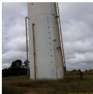
Foto 2 - Reservatório Jardim Embaré - Metálico
