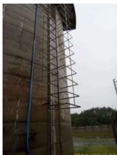
Foto 3 - Escada de acesso, com guarda-corpos
