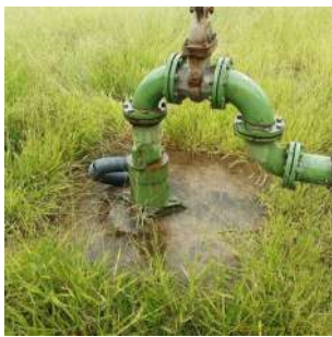
Foto 4 - Laje de proteção do poço Village Damha III
