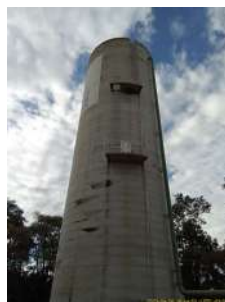
Foto 3 - Reservatório Santa Felicidade
