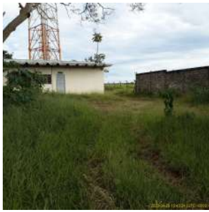
Foto 1 - Vista da área do poço e reservatório eco tecnológico Damha
