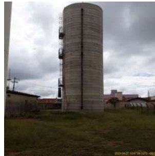
Foto 5 - Reservatório jardim Embaré
