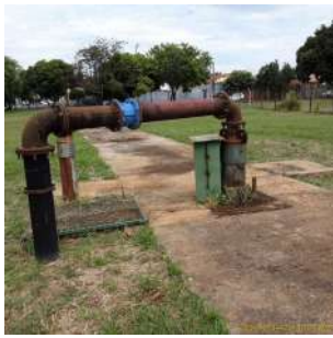
Foto 6 - Laje de proteção do poço Jockey Club
