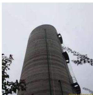
Foto 2 - Escada de acesso, com guarda-corpos
