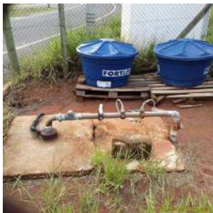
Foto 1 - Cavalete do poço Tutoya do Vale
