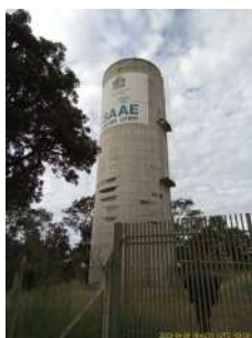
Foto 1 - Vista externa do reservatório Santa Felicidade
