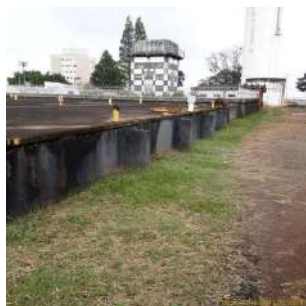
Foto 3 - Vista lateral 2 do reservatório Vila Nery Semi-enterrado II (concreto)
