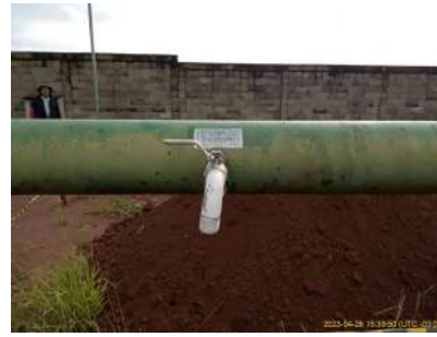
Foto 2 - Tomada para coleta de água
