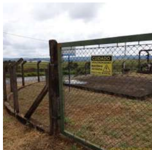
Foto 5 - Cercamento da área da estação elevatória de esgoto Jardim Embaré II
