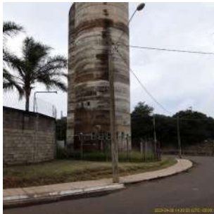
Foto 5 - Vista lateral dos reservatórios Village Damha I
