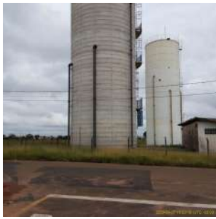
Foto 1 - Vista externa do Centro de produção e reservação Embaré
