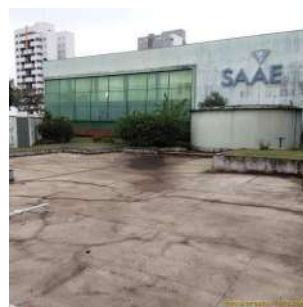
Foto 2 - Vista frontal da laje de cobertura do reservatório ETA Carlos Botelho
