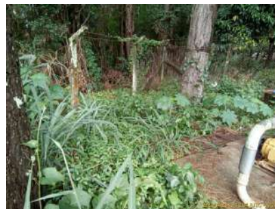
Foto 2 - Vista da área da estação elevatória de esgoto Samambaia
