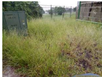
Foto 2 - Vista da área do poço e reservatório Damha Capela
