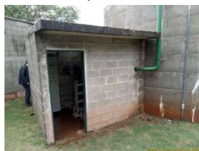
Foto 3 - Vista externa da estação elevatória Village Damha IV
