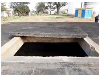
Foto 3 - Tampa de inspeção da caixa de passagem aberta
