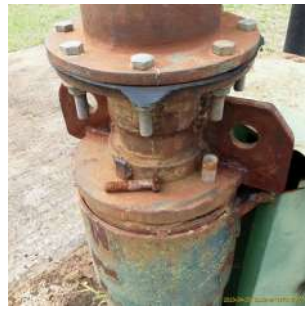
Foto 7 - Tubo de medição de nível
