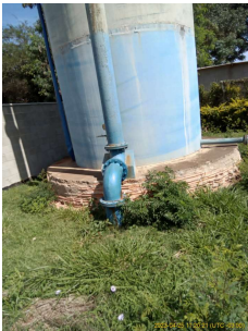
Foto 6 - Vista da tubulação do Reservatório Jardim Cordeiro em Cordeirópolis.
