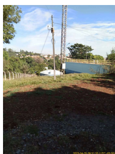
Foto 10 - Vista da ETA em Cordeirópolis.
