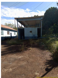
Foto 7 - Vista da ETA em Cordeirópolis.
