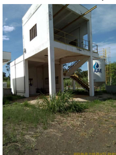
Foto 5 - Vista das dosadoras de produtos químicos da ETE em Cordeirópolis.
