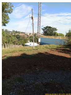
Foto 8 - Vista da ETA em Cordeirópolis.
