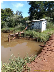
Foto 1 - Captação Córrego Ibicaba em Cordeirópolis.
