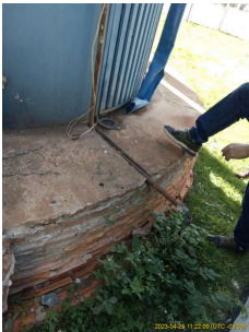
Foto 2 - Vista da tubulação do Reservatório Jardim Cordeiro em Cordeirópolis.
