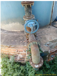
Foto 3 - Vista da tubulação do Reservatório Jardim Cordeiro em Cordeirópolis.
