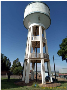
Foto 1 - Reservatório Elevado Centro de Distribuição de Água em Cordeirópolis.
