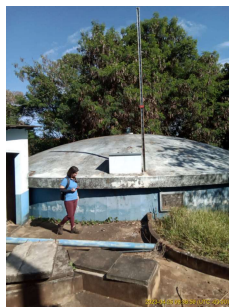
Foto 4 - Vista dos reservatórios semi-enterrados da ETA em Cordeirópolis.
