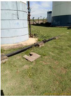
Foto 4 - Vista lateral do Reservatório Elevado no Jardim Paraty em Cordeirópolis.
