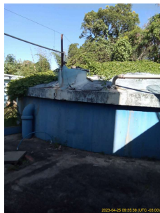
Foto 6 - Tampa de inspeção de um dos reservatórios semi-enterrados da ETA em Cordeirópolis.
