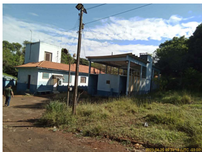
Foto 11 - Vista da ETA em Cordeirópolis.
