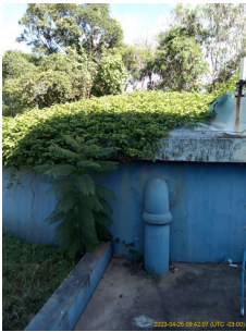
Foto 1 - Vista dos reservatórios semi-enterrados da ETA em Cordeirópolis.
