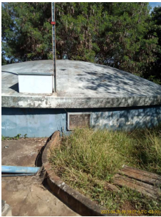
Foto 2 - Vista dos reservatório semi-enterrados da ETA em Cordeirópolis.
