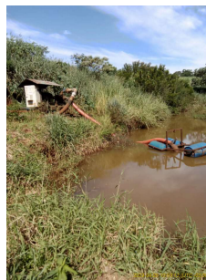
Foto 2 - Captação Córrego Ibicaba em Cordeirópolis.
