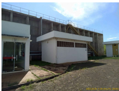
Foto 8 - ETE em Cordeirópolis.
