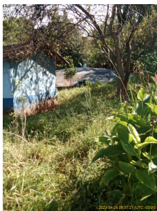
Foto 3 - Ausência de limpeza encontrada na ETA em Cordeirópolis.
