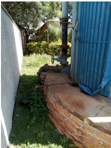
Foto 5 - Vista lateral do Reservatório Jardim Cordeiro em Cordeirópolis.
