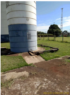
Foto 1 - Vista da tubulação do Reservatório Elevado no Jardim Paraty em Cordeirópolis.
