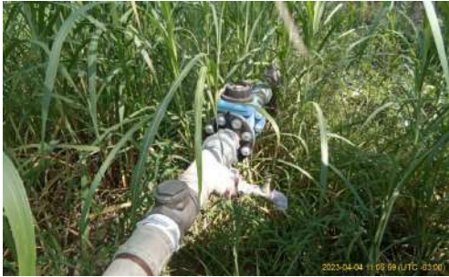
Foto 2 - Cavalete coberto de mato
