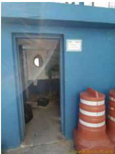
Foto 2 - Casa de bombas
