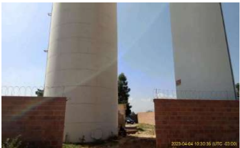
Foto 2 - Acesso à area - sem fechamento
