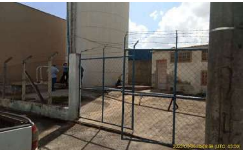
Foto 2 - Vista da área
