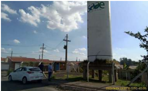
Foto 1 - vista geral do poço
