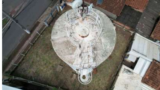
Foto 2 - Guarda-corpo na cobertura
