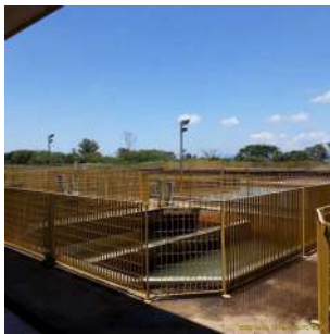
Foto 1 - Guarda-corpo da ETA II
