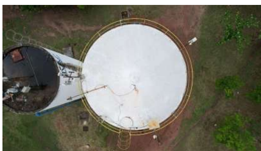
Foto 2 - Vista da cobertura do reservatório
