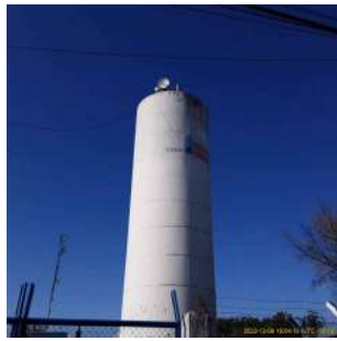
Foto 1 - Aspecto geral do reservatório
