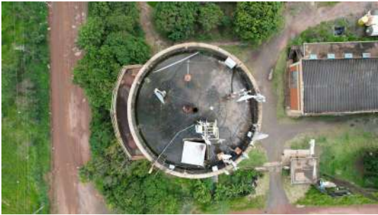
Foto 2 - Tubo de ventilação central, visto por cima
