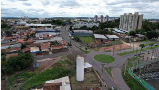
Foto 1 - Vista geral do reservatório
