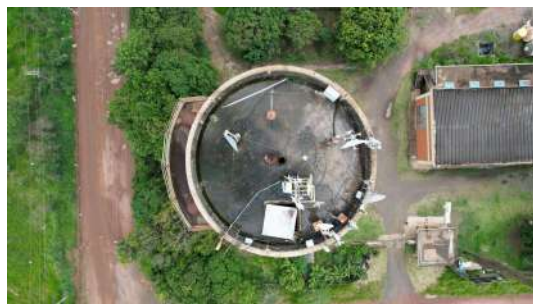
Foto 2 - Vista da cobertura do reservatório
