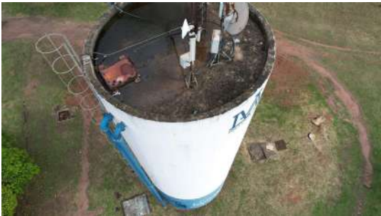
Foto 2 - Vista geral do reservatório
