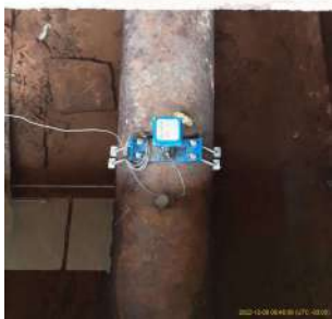
Foto 1 - Macromedidor instalado
