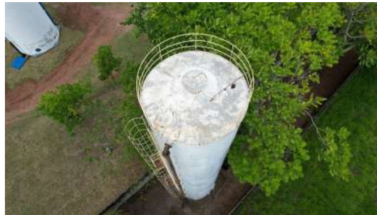
Foto 2 - Vista geral do reservatório
