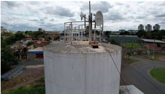
Foto 3 - Tubo de ventilação na cobertura
