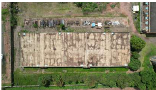
Foto 2 - Vista da cobertura do reservatório apoiado
