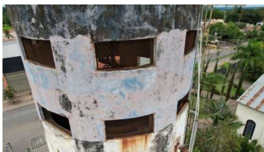
Foto 2 - Vista lateral do reservatório
