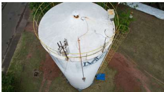
Foto 3 - Vista geral do reservatório
