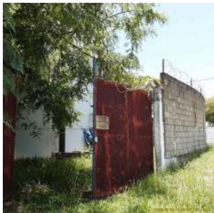
Foto 1 - Cercamento do reservatório
