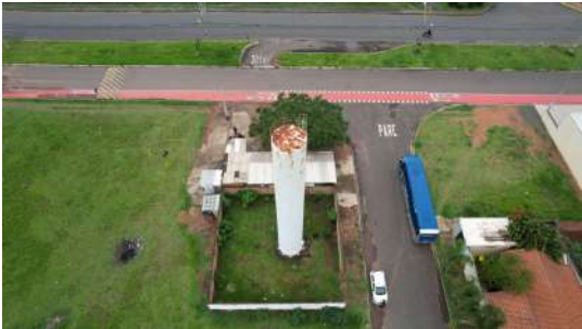
Foto 1 - Vista geral do reservatório
