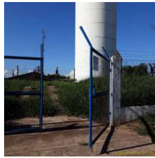
Foto 2 - Cercamento do reservatório
