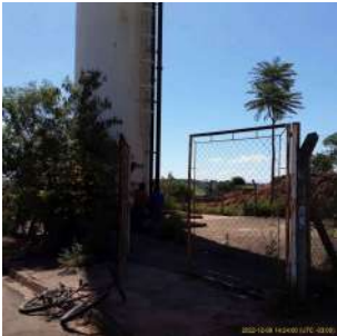
Foto 1 - Cercamento do reservatório
