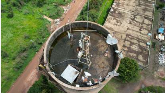
Foto 1 - Vista da tampa de inspeção
