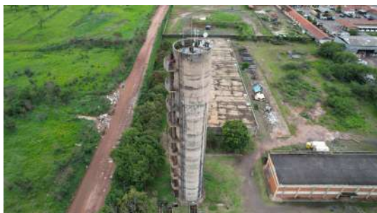
Foto 1 - Vista geral do reservatório
