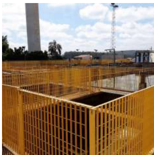
Foto 1 - Guarda-corpo instalado
