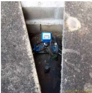
Foto 2 - Macromedidor instalado
