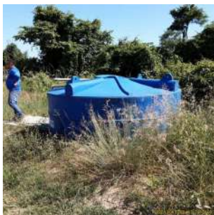
Foto 1 - Ausência de cercamento ao redor do reservatório
