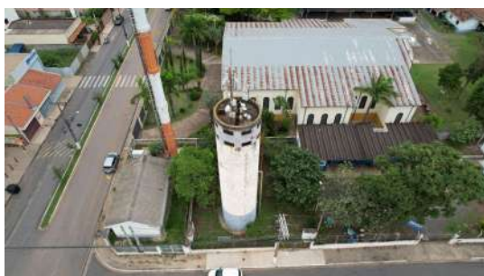
Foto 1 - Vista geral do reservatório
