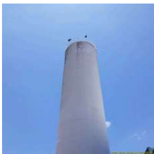
Foto 1 - Inexistência de pára-raios no reservatório
