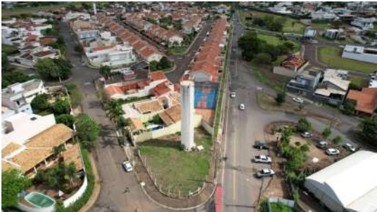
Foto 1 - Vista geral do reservatório
