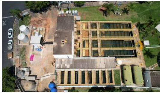
Foto 6 - Vista Geral da ETA I
