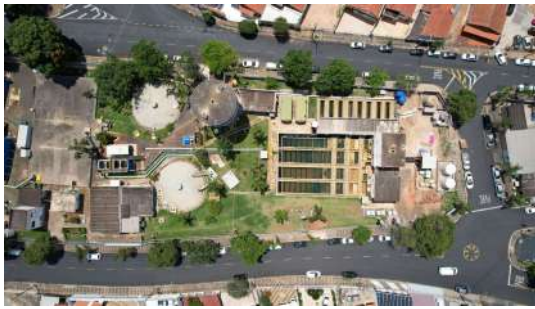
Foto 5 - Vista Geral da ETA I
