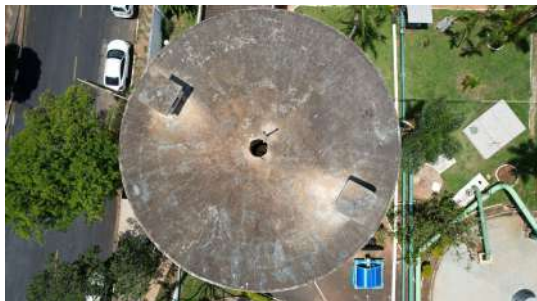
Foto 1 - Haste de pára-raios no reservatório elevado aparentemente não funcionando
