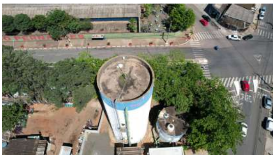
Foto 1 - Vista geral da cobertura do reservatório
