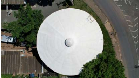
Foto 3 - Vista da Parte Superior do Reservatório
