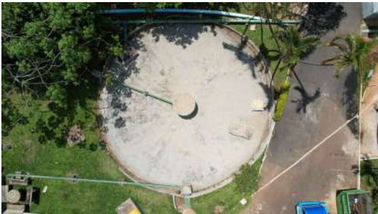
Foto 2 - Vista Geral do Reservatório Semienterrado II - Circular.
