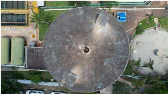
Foto 3 - Vista Geral do Reservatório Elevado.
