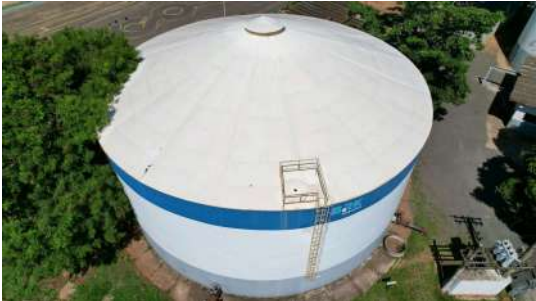
Foto 4 - Vista Geral do Reservatório
