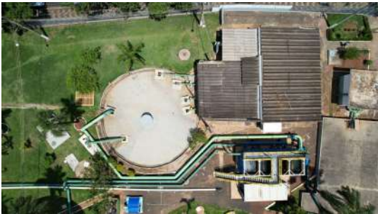
Foto 1 - Vista Geral do Reservatório Semienterrado I - Circular.
