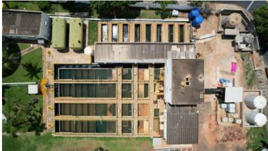
Foto 7 - Vista Geral da ETA I
