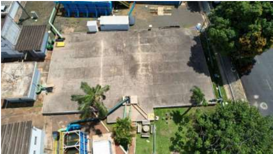
Foto 4 - Vista Geral do Reservatório Semienterrado - Retangular
