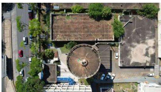
Foto 2 - Vista do Reservatório Elevado XV de Novembro com auxílio de drone em Piracicaba
