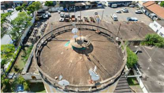
Foto 1 - Tampas de inspeção do Reservatório Elevado XV de Novembro com auxílio de drone em Piracicaba
