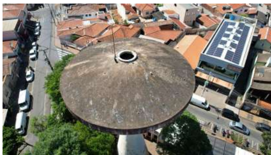
Foto 4 - Vista do Reservatório Elevado Takaki com auxílio de drone em Piracicaba
