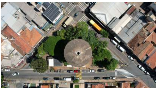
Foto 3 - Vista do Reservatório Elevado Takaki com auxílio de drone em Piracicaba
