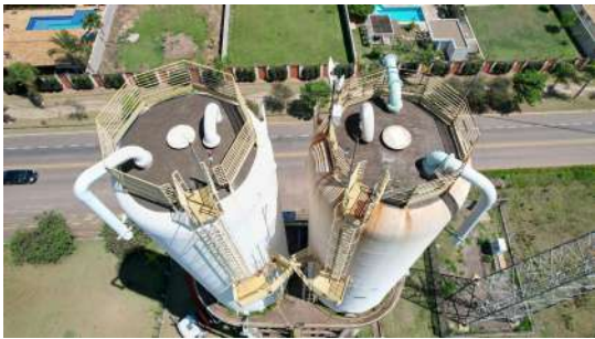
Foto 3 - Vista Geral dos Reservatórios Elevados Campestre
