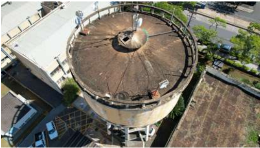
Foto 2 - Tampas de inspeção do Reservatório Elevado XV de Novembro com auxílio de drone em Piracicaba
