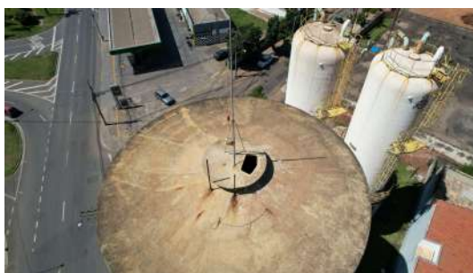
Foto 2 - Abertura do Reservatório Elevado Paulicéia
