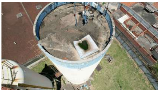
Foto 1 - Vista Geral do Reservatório
