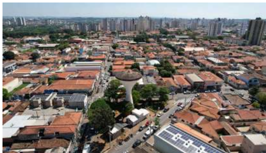
Foto 2 - Vista do Reservatório Elevado Takaki com auxílio de drone em Piracicaba
