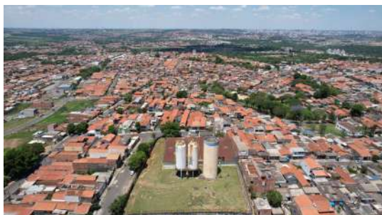
Foto 1 - Vista Geral dos Reservatórios Elevados em Fibra de Vidro Interligados
