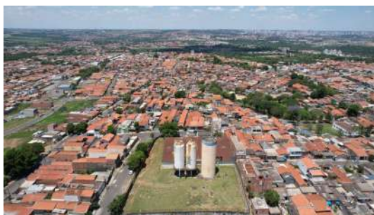
Foto 2 - Vista geral do reservatório semienterrado
