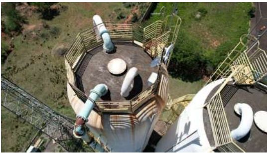
Foto 4 - Vista Geral dos Reservatórios Elevados Campestre
