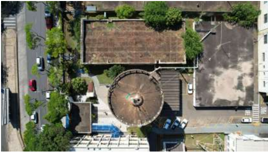
Foto 2 - Vista do Reservatório Semienterrado XV de Novembro com auxílio de drone
