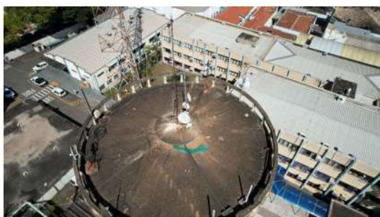
Foto 3 - Vista do Reservatório Elevado XV de Novembro com auxílio de drone em Piracicaba
