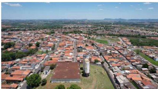
Foto 3 - Vista geral do reservatório semienterrado
