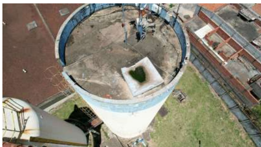
Foto 1 - Vista geral da cobertura do reservatório com guarda-corpo
