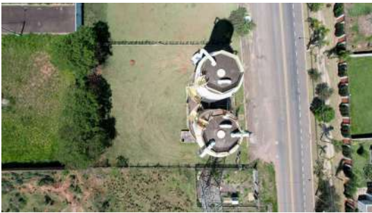
Foto 1 - Vista Geral dos Reservatórios Elevados Campestre
