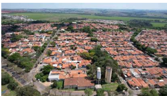
Foto 1 - Vista Geral do Reservatório Semienterrado CECAP
