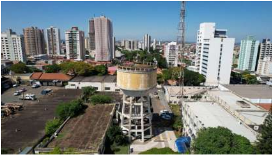
Foto 1 - Vista do Reservatório Semienterrado XV de Novembro com auxílio de drone
