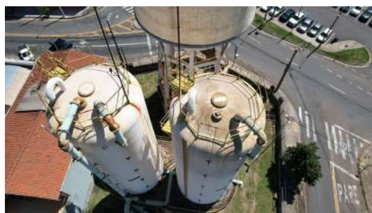
Foto 2 - Vista dos Reservatórios Elevados Interligados Paulicéia
