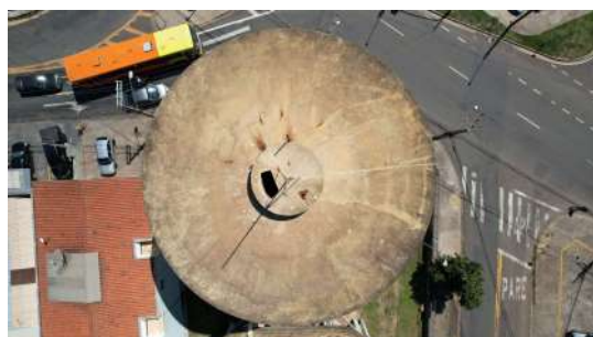
Foto 1 - Abertura do Reservatório Elevado Paulicéia
