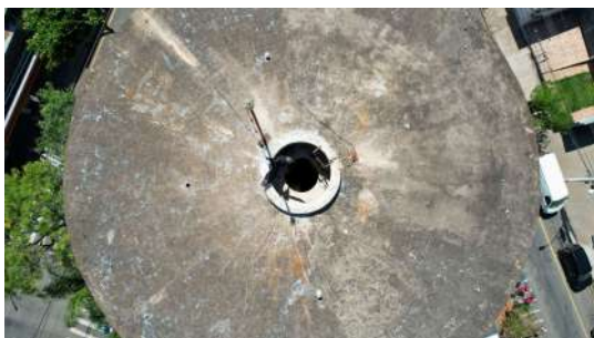
Foto 1 - Abertura no topo do reservatório
