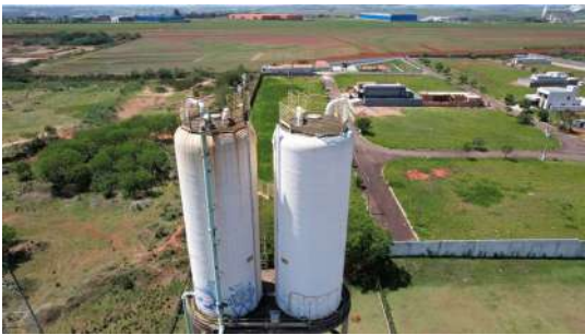
Foto 2 - Vista Geral dos Reservatórios Elevados Campestre
