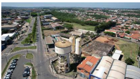
Foto 1 - Vista dos Reservatórios Elevados Interligados Paulicéia (ao fundo do reservatório elevado)
