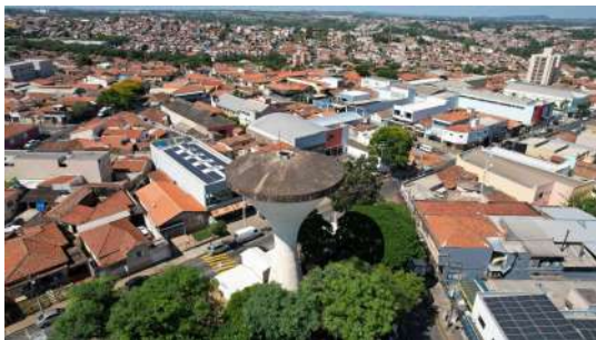
Foto 1 - Vista do Reservatório Elevado Takaki com auxílio de drone em Piracicaba
