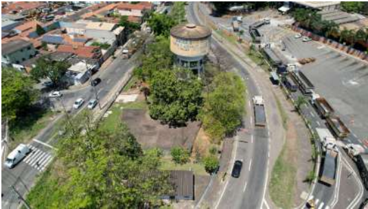
Foto 3 - Vista do Reservatório Elevado Vila Rezende com auxílio de drone em Piracicaba
