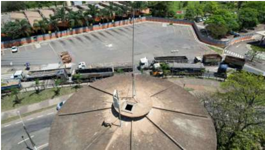
Foto 4 - Vista do Reservatório Elevado Vila Rezende com auxílio de drone em Piracicaba
