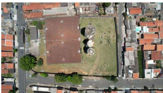
Foto 1 - Vista geral do reservatório semienterrado
