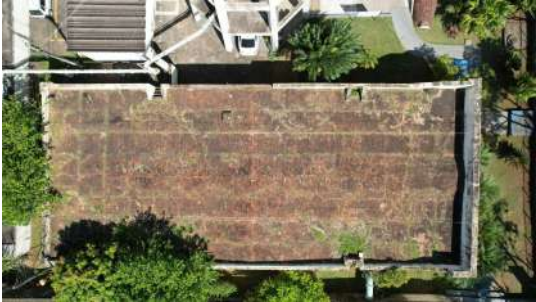
Foto 3 - Vista do Reservatório Semienterrado XV de Novembro com auxílio de drone
