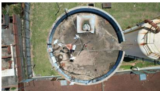
Foto 1 - Tampa de inspeção na cobertura do reservatório
