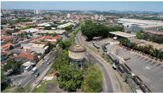
Foto 2 - Vista do Reservatório Elevado Vila Rezende com auxílio de drone em Piracicaba
