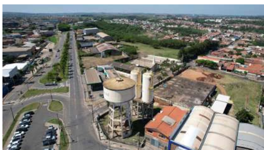
Foto 1 - Vista da Área do Reservatório Elevado Paulicéia
