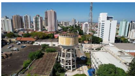
Foto 1 - Vista do Reservatório Elevado XV de Novembro com auxílio de drone em Piracicaba
