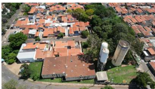
Foto 2 - Vista Geral do Reservatório Semienterrado CECAP
