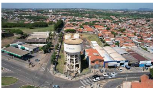
Foto 2 - Vista da Área do Reservatório Elevado Paulicéia
