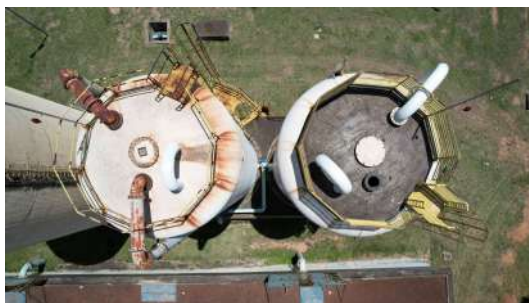
Foto 2 - Vista Geral dos Reservatórios Elevados vistos por cima
