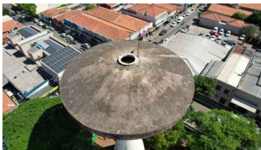
Foto 2 - Abertura no topo do reservatório
