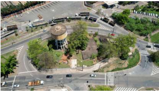
Foto 1 - Vista do Reservatório Elevado Vila Rezende com auxílio de drone em Piracicaba
