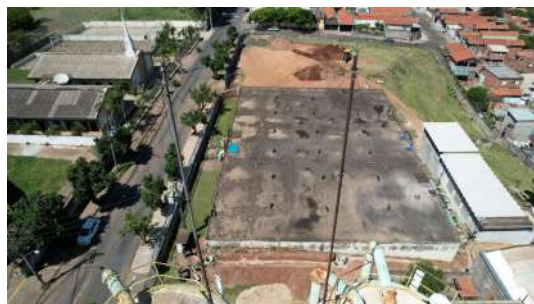
Foto 2 - Vista do Reservatório Semienterrado Pauliceia com auxílio de drone em Piracicaba
