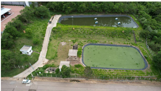
Foto 1 - Vista geral da ETE
