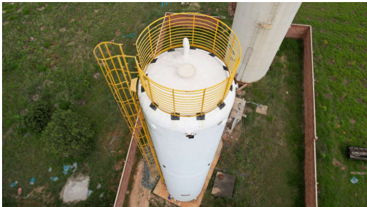
Foto 5 - Panorâmica reservatório novo
