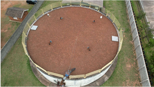
Foto 1 - Vista do Reservatório Apoiado Fazenda Grande com auxílio de drone em Jundiaí
