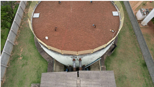
Foto 2 - Tampas de inspeção do Reservatório Apoiado Fazenda Grande com auxílio de drone em Jundiaí
