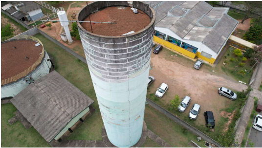
Foto 2 - Pára-raios do Reservatório Elevado Fazenda Grande com auxílio de drone em Jundiaí
