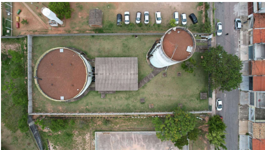
Foto 1 - Vista do Reservatório Elevado Fazenda Grande com auxílio de drone em Jundiaí
