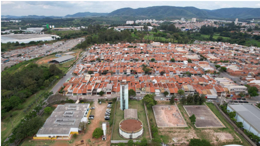
Foto 2 - Vista do Reservatório Apoiado Fazenda Grande com auxílio de drone em Jundiaí
