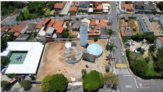
Foto 1 - Vista dos reservatórios do sistema.
