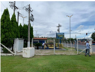
Foto 2 - Vista da elevatória.
