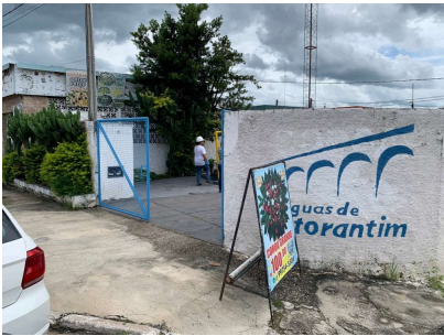
Foto 1 - Vista externa da área da elevatória.
