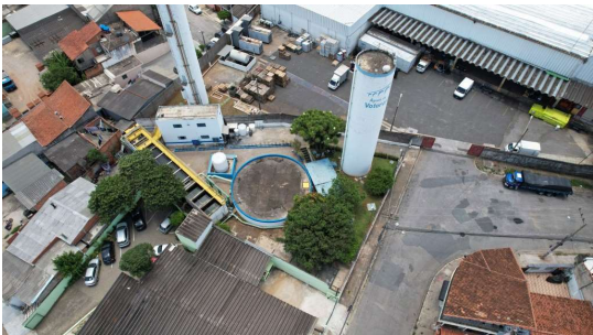
Foto 1 - Vista dos reservatórios junto à ETA.
