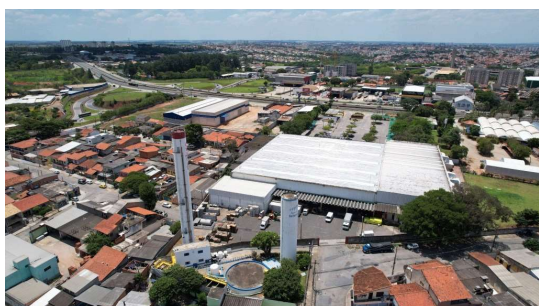
Foto 1 - Reservatório particular de maior altura, ao lado do reservatório da concessionária.
