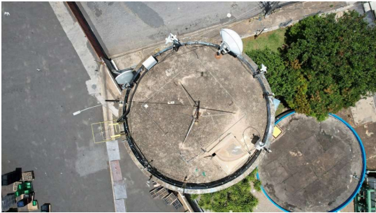
Foto 1 - Tapa do reservatório elevado.
