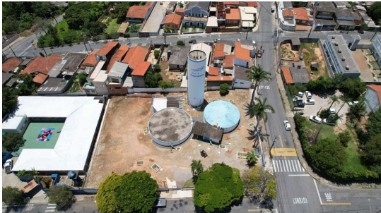
Foto 1 - Observa-se o cercamento da área.
