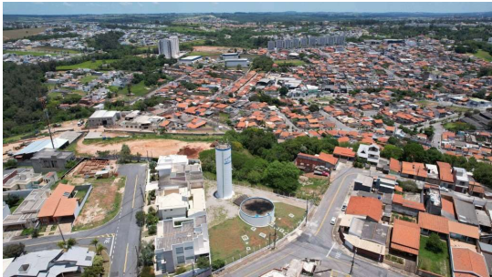
Foto 1 - Vista dos reservatórios do sistema.
