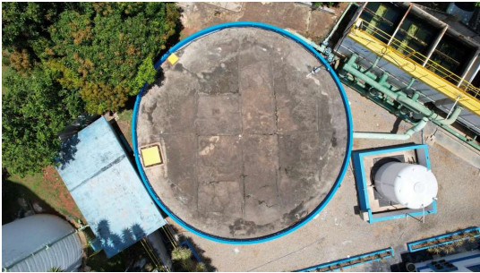
Foto 2 - Tapa do reservatório semi enterrado.
