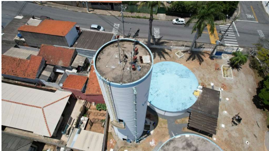
Foto 1 - Escada de acesso para manutenção no reservatório elevado.
