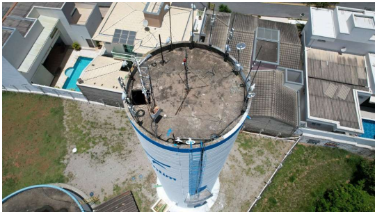
Foto 1 - Escada do reservatório elevado.
