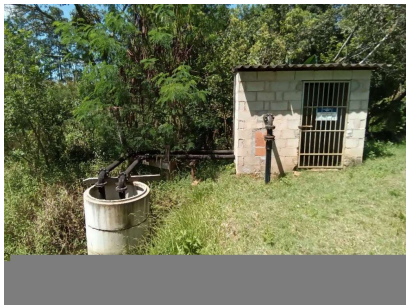
Foto 1 - Vista geral da captação.
