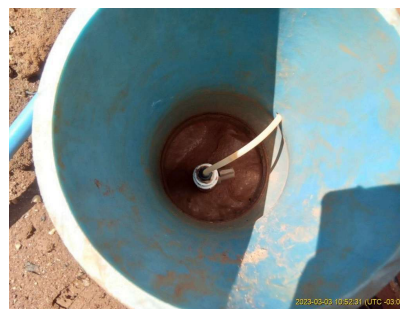
Foto 10 - Aplicação de hipoclorito na água bruta.
