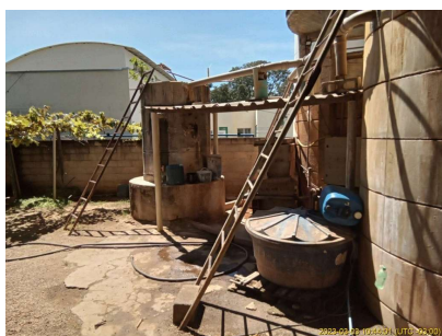
Foto 1 - Ausência de escada adequada.
