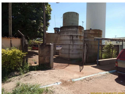
Foto 1 - Portão de entrada da ETA.
