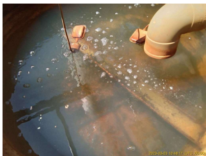
Foto 3 - Vista do interior do filtro.
