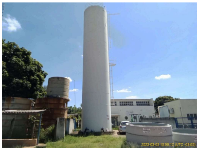
Foto 1 - Vista geral do reservatório.
