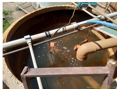
Foto 4 - Vista do interior do filtro.
