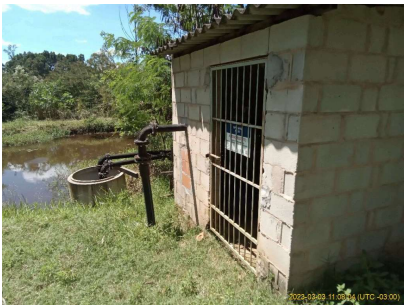
Foto 2 - Vista geral da captação.
