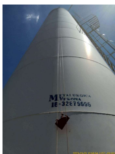
Foto 1 - Medidor de nível mecânico.
