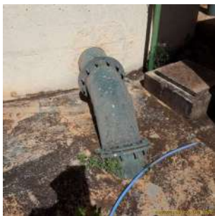
Foto 1 - Reservatório Elevado Santa Maria em Leme
