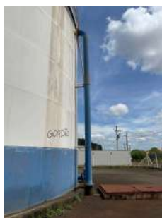
Foto 3 - Reservatório Apoiado Santa Carolina em Leme
