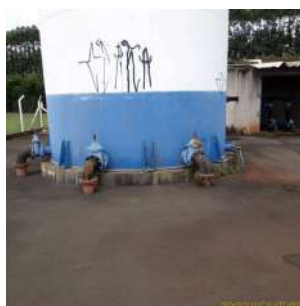
Foto 2 - Reservatório Elevado Santa Carolina em Leme
