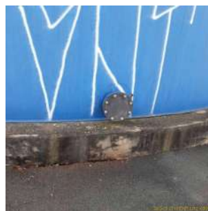
Foto 2 - Reservatório Apoiado Jardim Empyrio em Leme
