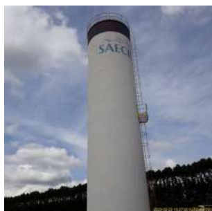
Foto 3 - Reservatório Elevado Santa Carolina em Leme
