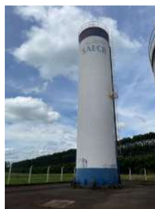
Foto 6 - Reservatório Elevado Santa Carolina em Leme
