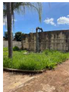
Foto 4 - Reservatório Apoiado Santa Maria em Leme
