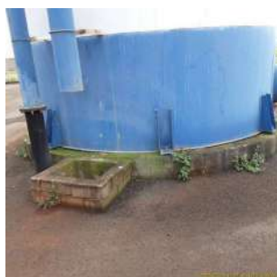
Foto 1 - Reservatório Elevado Santa Carolina em Leme
