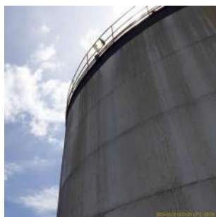
Foto 1 - Reservatório Apoiado Jardim Empyrio em Leme
