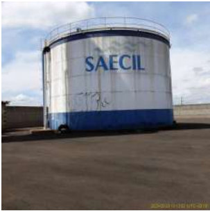
Foto 5 - Reservatório Elevado Jardim Empyrio em Leme
