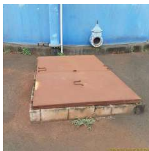
Foto 4 - Reservatório Elevado Santa Carolina em Leme
