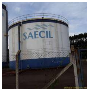
Foto 6 - Reservatório Apoiado Santa Carolina em Leme
