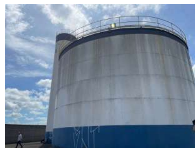
Foto 6 - Reservatório Apoiado Jardim Empyrio em Leme
