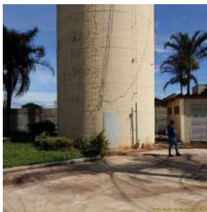
Foto 6 - Reservatório Elevado Santa Maria em Leme
