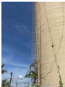
Foto 9 - Reservatório Elevado Santa Maria em Leme
