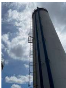
Foto 5 - Reservatório Elevado Santa Carolina em Leme
