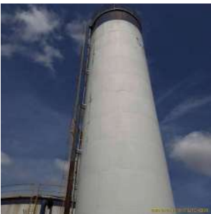
Foto 2 - Reservatório Elevado Jardim Empyrio em Leme
