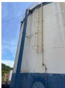
Foto 5 - Reservatório Apoiado Santa Carolina em Leme
