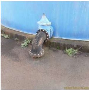
Foto 1 - Reservatório Apoiado Santa Carolina em Leme
