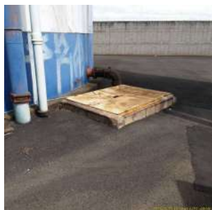
Foto 3 - Reservatório Apoiado Jardim Empyrio em Leme
