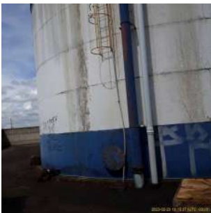
Foto 1 - Reservatório Elevado Jardim Empyrio em Leme
