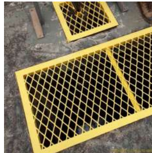
Foto 10 - EEE na ETE Anselmo em Leme
