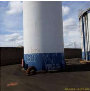
Foto 4 - Reservatório Elevado Jardim Empyrio em Leme
