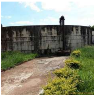
Foto 1 - Reservatório Apoiado Santa Maria em Leme
