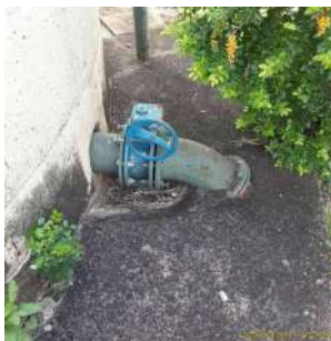
Foto 2 - Reservatório Elevado Santa Maria em Leme
