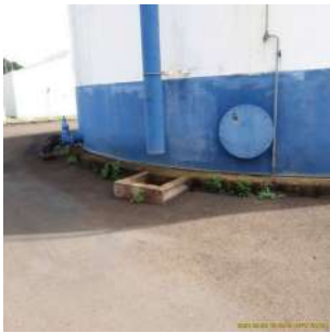
Foto 2 - Reservatório Apoiado Santa Carolina em Leme
