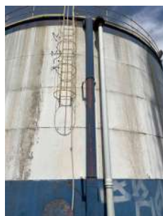
Foto 5 - Reservatório Apoiado Jardim Empyrio em Leme
