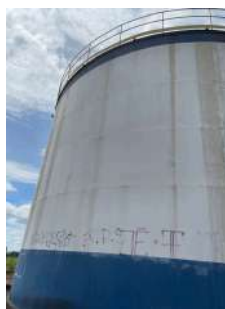
Foto 4 - Reservatório Apoiado Santa Carolina em Leme
