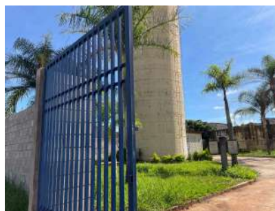
Foto 8 - Reservatório Elevado Santa Maria em Leme
