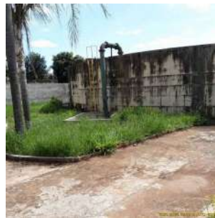
Foto 2 - Reservatório Apoiado Santa Maria em Leme
