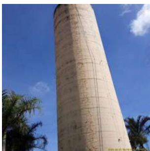
Foto 7 - Reservatório Elevado Santa Maria em Leme
