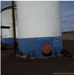
Foto 3 - Reservatório Elevado Jardim Empyrio em Leme
