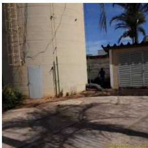
Foto 5 - Reservatório Elevado Santa Maria em Leme
