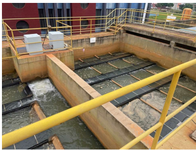
Foto 5 - ETA 4 em Santa Bárbara DOeste
