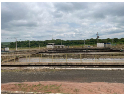
Foto 7 - ETE Barrocão em Santa Bárbara DOeste
