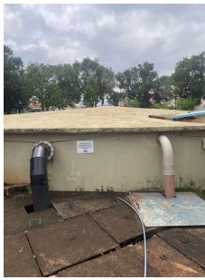
Foto 1 - Reservatório Amélia semi enterrado circular em Santa Bárbara DOeste
