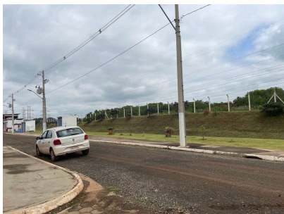
Foto 1 - Cerca na ETE Barrocão em Santa Bárbara DOeste
