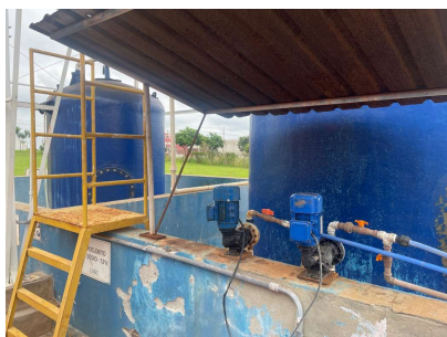
Foto 3 - ETA 4 em Santa Bárbara DOeste
