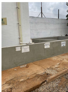
Foto 3 - Produtos químicos utilizados na ETA 2 em Santa Bárbara DOeste
