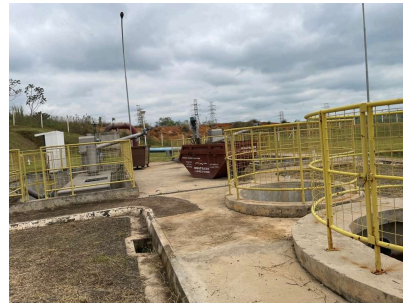
Foto 6 - ETE Barrocão em Santa Bárbara DOeste
