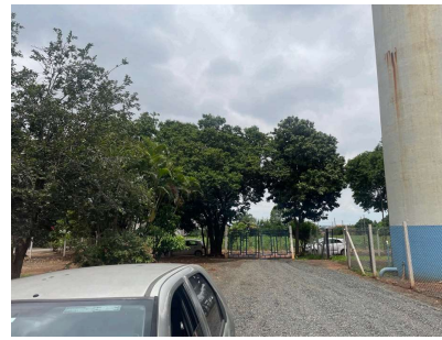
Foto 2 - Reservatório Amélia semi enterrado circular em Santa Bárbara DOeste
