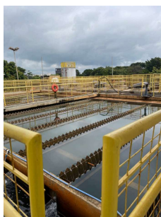
Foto 1 - ETA 2 em Santa Bárbara DOeste
