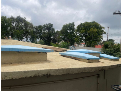
Foto 3 - Reservatório Amélia semi enterrado circular em Santa Bárbara DOeste
