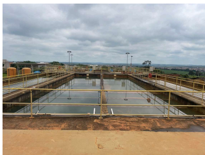
Foto 1 - ETA 4 em Santa Bárbara DOeste
