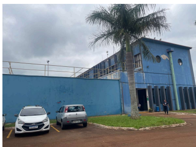
Foto 1 - ETA 4 em Santa Bárbara DOeste
