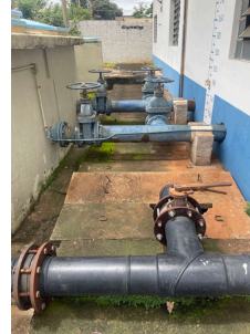
Foto 4 - Reservatório Amélia semi enterrado circular em Santa Bárbara DOeste
