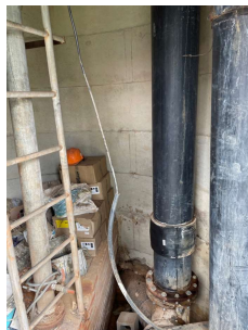
Foto 2 - Interior do Reservatório Cálice elevado na ETA 2 em Santa Bárbara DOeste
