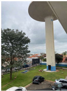
Foto 1 - Reservatório Cálice elevado na ETA 2 em Santa Bárbara DOeste
