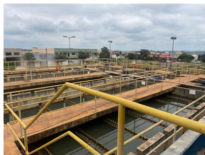
Foto 2 - ETA 4 em Santa Bárbara DOeste
