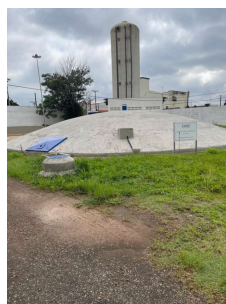
Foto 2 - Reservatórios enterrados na ETA 2 em Santa Bárbara DOeste
