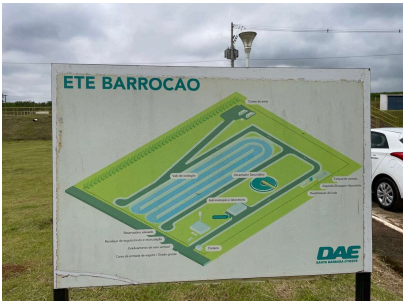
Foto 2 - ETE Barroção em Santa Bárbara DOeste
