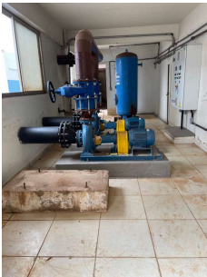
Foto 1 - ETA 2 em Santa Bárbara DOeste
