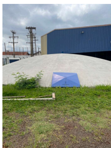
Foto 1 - Reservatórios enterrados na ETA 2 em Santa Bárbara DOeste
