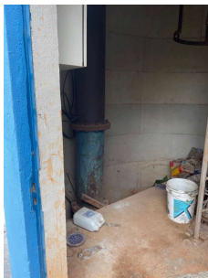
Foto 1 - Interior do Reservatório Cálice elevado na ETA 2 em Santa Bárbara DOeste
