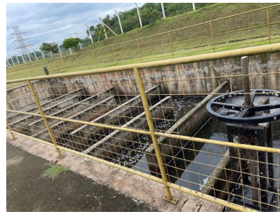
Foto 4 - ETE Barrocão em Santa Bárbara DOeste
