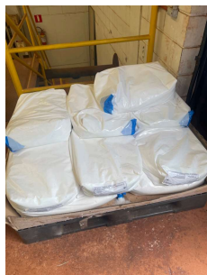
Foto 2 - Produtos químicos utilizados na ETA 4 em Santa Bárbara DOeste
