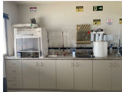
Foto 2 - Laboratórios na ETA 2 em Santa Bárbara DOeste
