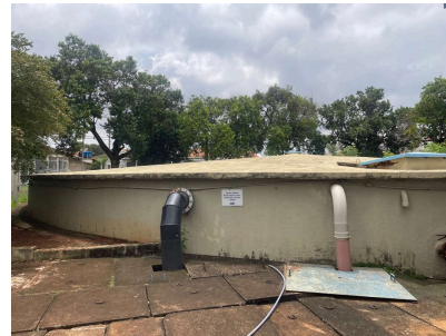
Foto 6 - Reservatório Amélia semi enterrado circular em Santa Bárbara DOeste
