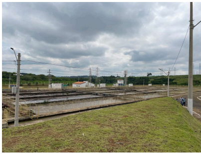
Foto 3 - ETE Barrocão em Santa Bárbara DOeste
