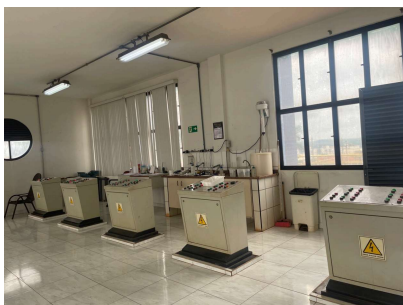
Foto 1 - ETA 4 em Santa Bárbara DOeste
