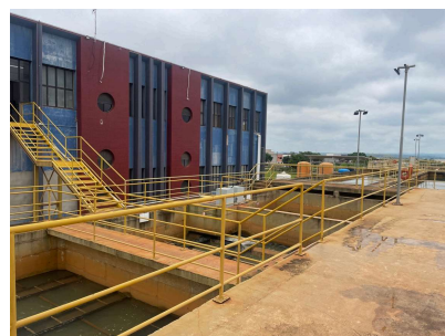
Foto 2 - ETA 4 em Santa Bárbara DOeste
