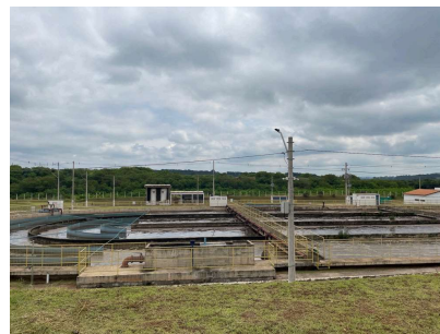
Foto 8 - ETE Barrocão em Santa Bárbara DOeste
