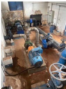
Foto 7 - Reservatório Amélia semi enterrado circular em Santa Bárbara DOeste
