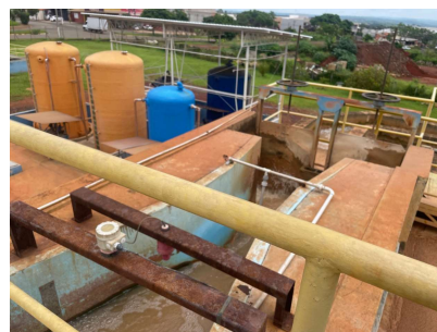
Foto 4 - ETA 4 em Santa Bárbara DOeste
