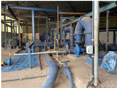
Foto 2 - ETA 2 em Santa Bárbara DOeste
