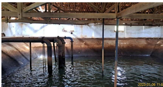
Foto 1 - Vista do interior do Reservatório Filipão Velho
