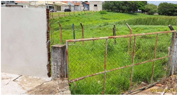
Foto 1 - Portão de entrada para a área do Poço CDHU
