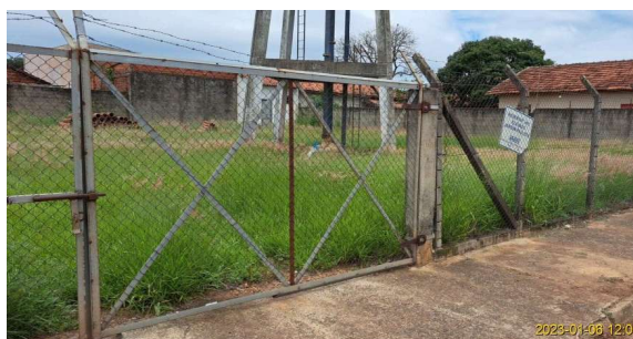
Foto 1 - Cerca e portão de acesso à área - Reservatório Jd. Paulista
