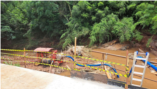
Foto 2 - Medidas provis  rias para capta  o no Ribeir  o do Lageado ap  s acidente com a barragem.
