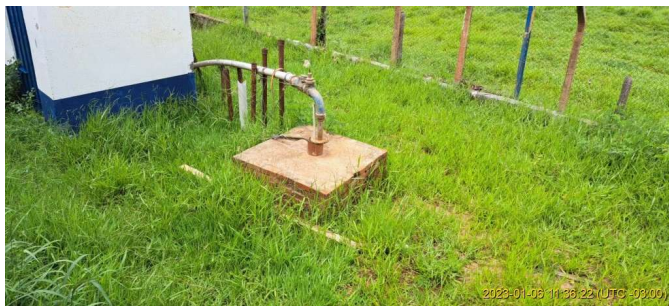
Foto 1 - Laje de proteção - Poço CDHU
