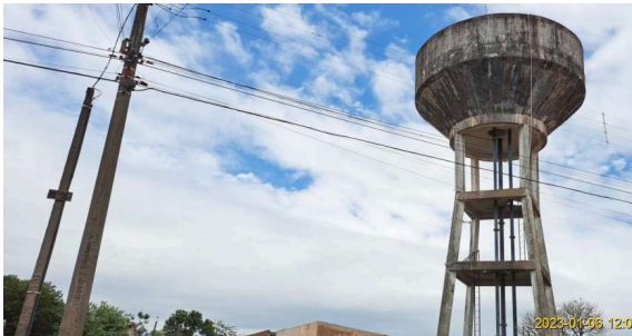
Foto 1 - Vista geral - Reservatório Jd. Paulista
