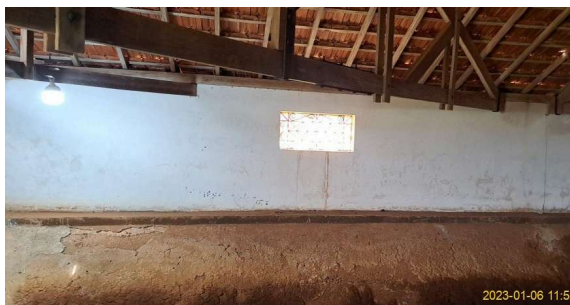
Foto 3 - Vista do interior do Reservatório Filipão Velho
