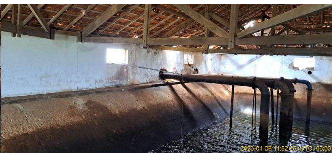
Foto 2 - Vista do interior do Reservatório Filipão Velho
