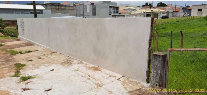
Foto 2 - Muro de alvenaria que cerca a área a área do Poço CDHU
