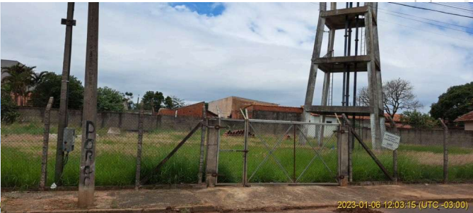
Foto 2 - Vista geral - Reservatório Jd. Paulista
