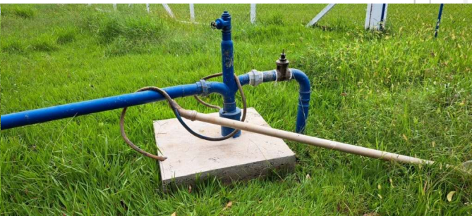
Foto 2 - Laje de proteção - Poço Arco Íris
