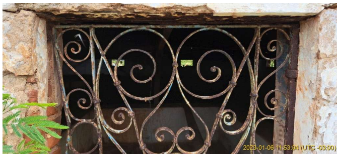
Foto 1 - Portão de acesso à área interna do Reservatório Filipão Velho
