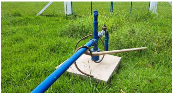
Foto 1 - Laje de proteção - Poço Arco Íris
