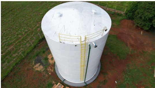
Foto 1 - Detalhe da cobertura
