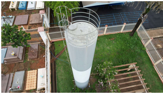
Foto 1 - Reservatório Apoiado Cemitério visão geral lateral
