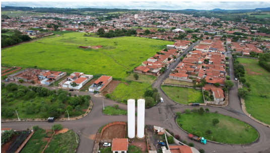
Foto 1 - Visão geral - Reservatório Santa Carolina
