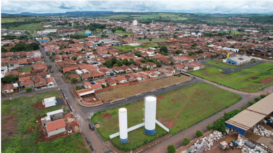
Foto 1 - Reservatório Vila Salemi visão geral - 2 unidades
