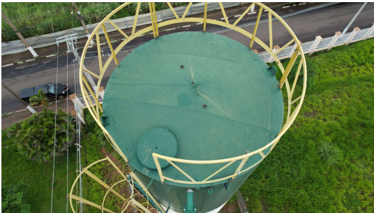
Foto 3 - Reservatório do Loteamento Monte Beluna visto de cima
