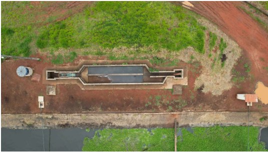
Foto 3 - ETE Tambaú - medidor de vazão
