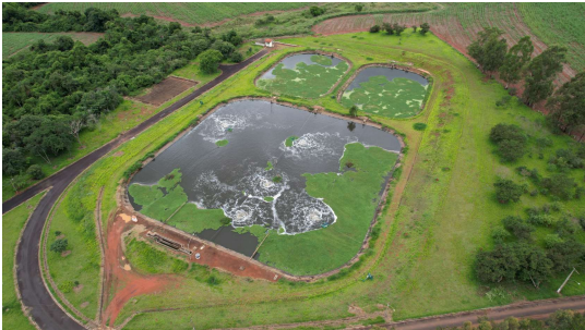
Foto 1 - ETE Tambau - visão geral
