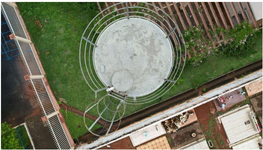
Foto 2 - Reservatório Apoiado Cemitério visto de cima
