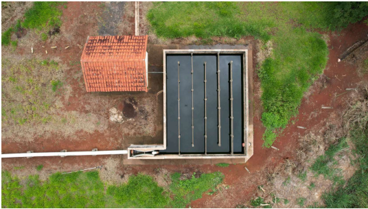
Foto 4 - ETE Tambaú - chicanas
