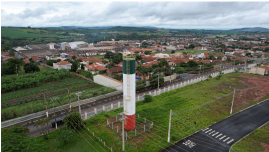
Foto 1 - Reservatório do Loteamento Monte Beluna visão geral
