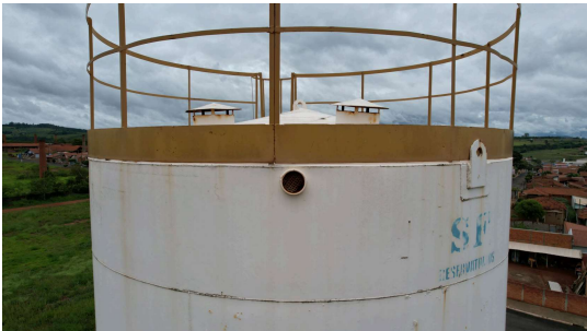
Foto 3 - Reservatório Vila Salemi vista lateral com foco para tela de proteção no extravasor
