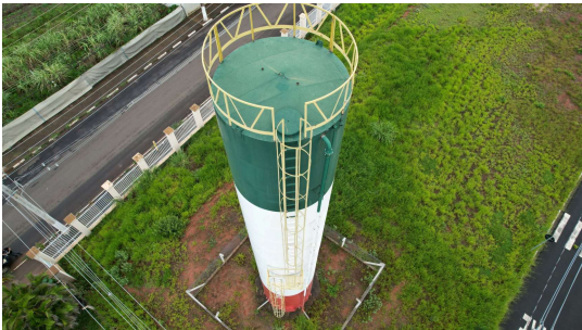
Foto 2 - Reservatório do Loteamento Monte Beluna visão lateral
