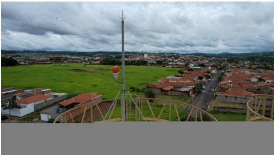
Foto 3 - Reservatório Santa Carolina visto de cima com foco em para-raios
