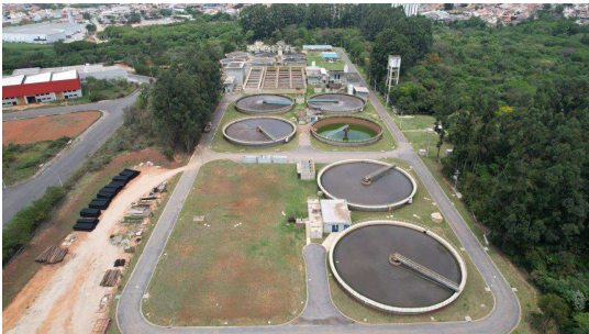
Foto 6 - Vista geral - ampliação
