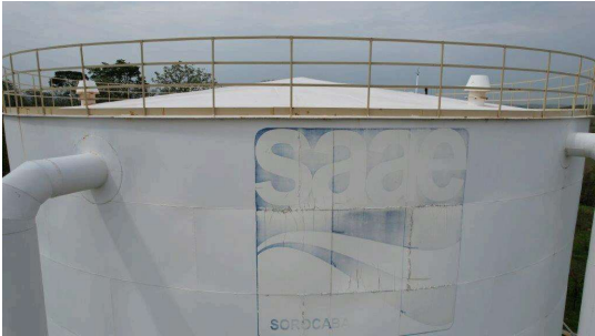
Foto 4 - Detalhe da cobertura
