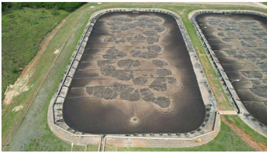
Foto 5 - Lagoas de aeração
