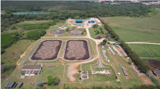
Foto 2 - Vista geral da ETE
