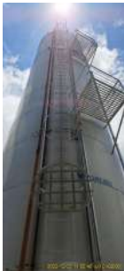
Foto 2 - Guarda-corpos na escada vertical e patamares de descanso
