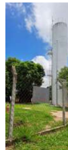
Foto 2 - Vista externa do Reservatório Planalto Serra Verde
