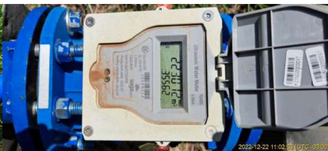
Foto 2 - Macromedidor - Poço Broa
