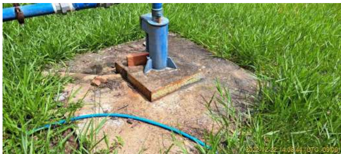
Foto 1 - Laje de proteção - Poço Ubá 2
