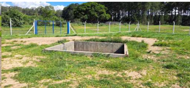
Foto 4 - Ponto de chegada do esgoto bruto na entrada da ETE Itirapina
