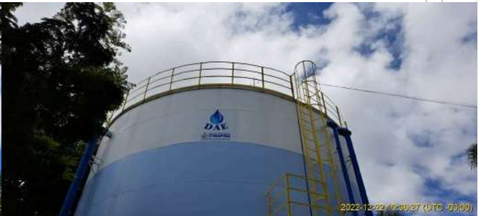
Foto 2 - Detalhe dos guarda-corpos na cobertura - Reservatório Apoiado Broa
