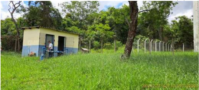
Foto 3 - Vista do Poço Ubá 2 e do abrigo de produtos químicos e bombas dosadoras
