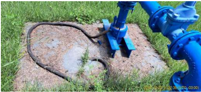
Foto 1 - Laje de Proteção - Poço Broa
