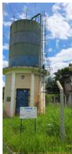
Foto 1 - Vista geral - Reservatório Elevado Ubá 1
