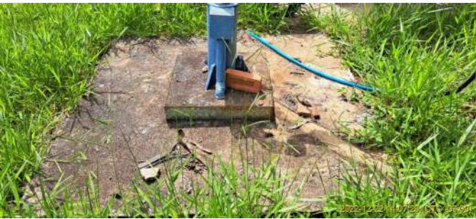
Foto 5 - Laje de proteção - Poço Ubá 2
