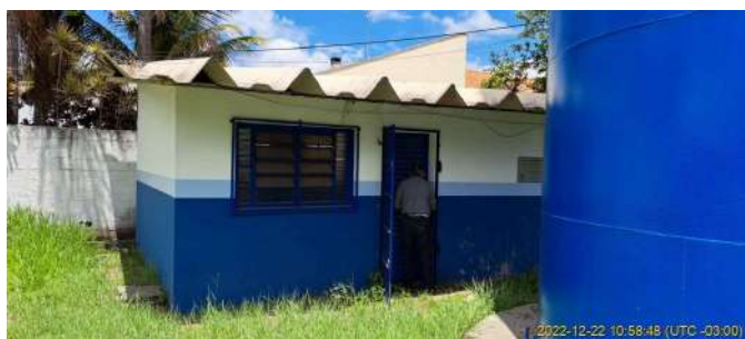
Foto 5 - Vista externa da EEA Broa
