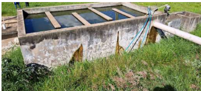
Foto 15 - Tanque de contato (com chicanas) após terceira lagoa - ETE Itirapina
