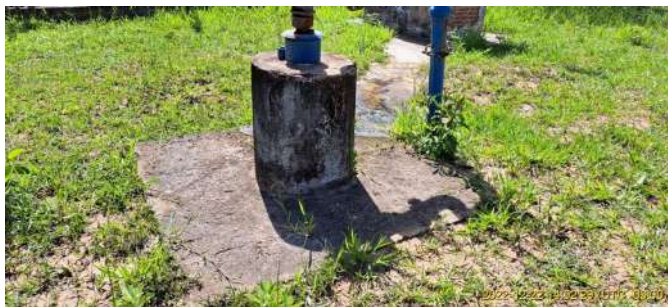
Foto 1 - Laje de proteção - Poço Ubá 1
