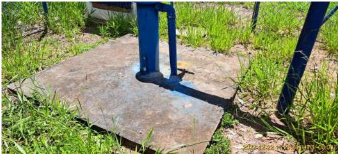
Foto 1 - Laje de proteção - Poço Broa - Rua 4
