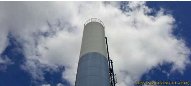
Foto 2 - Vista geral - Reservatório elevado Broa
