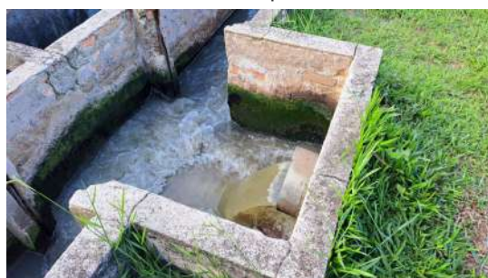
Foto 9 - Ponto de chegada e distribuição em canal na primeira lagoa (anaeróbia)
