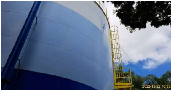
Foto 1 - Detalhe dos guarda-corpos em escada - Reservatório Apoiado Broa
