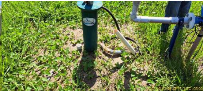
Foto 2 - Vista da laje de proteção - Poço Itaqueri da Serra (Novo)
