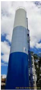
Foto 4 - Vista geral - Reservatório elevado Broa
