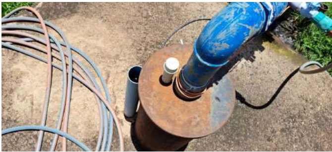
Foto 1 - Tubo medidor de nível - Poço Planalto Serra Verde
