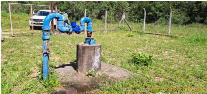
Foto 5 - Vista geral - Poço Ubá 1
