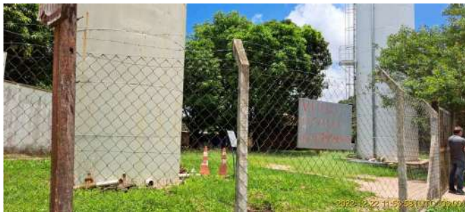
Foto 1 - Vista externa do Reservatório Planalto Serra Verde
