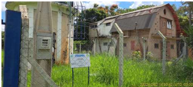
Foto 2 - Vista geral - Reservatório Elevado Ubá 1
