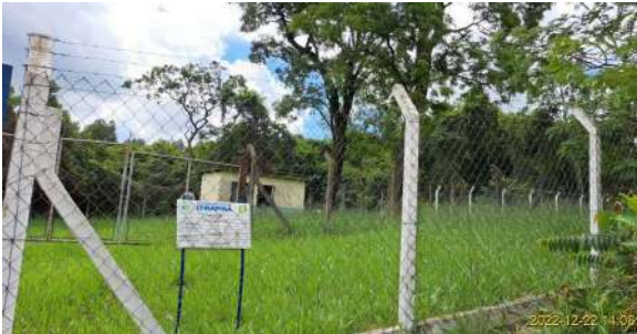
Foto 1 - Vista externa ao Sistema Ubá 2 - Poço e Reservatório
