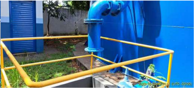
Foto 4 - Tubo extravasor - Reservatório Apoiado Broa
