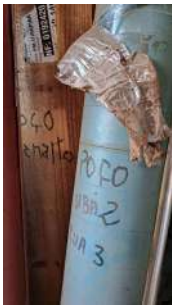
Foto 1 - Bomba reserva do Poço Ubá 2
