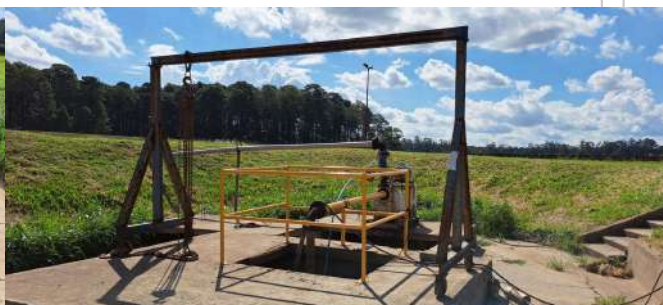
Foto 8 - Poço de recalque após tratamento preliminar e medição de vazão - ETE Itirapina
