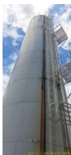
Foto 5 - Guarda-corpos e tubos extravasores do Reservatório
