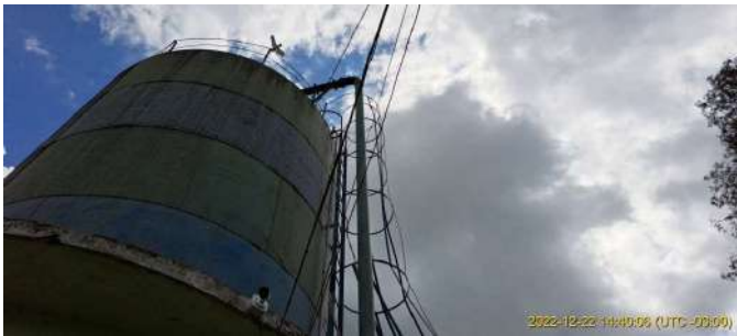
Foto 1 - Guarda-corpos em escada e cobertura - Reservatório Elevado Ubá 1
