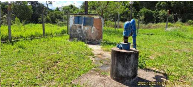
Foto 4 - Vista geral - Poço Ubá 1
