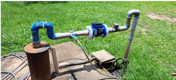
Foto 1 - Torneira de tomada de água bruta - Poço Planalto Serra Verde
