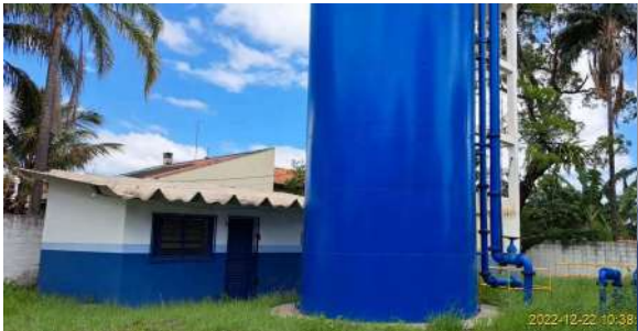
Foto 1 - Vista geral do Reservatório elevado Broa, com detalhe para a Estação elevatória do Broa ao fundo
