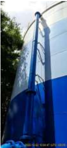
Foto 5 - Tubo extravasor - Reservatório Apoiado Broa
