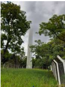
Foto 1 - Vista geral do Reservatório elevado Ubá
