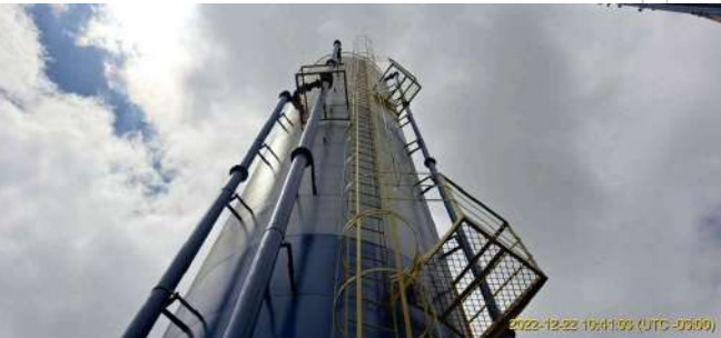
Foto 2 - Tubo extravasor - Reservatório elevado Broa
