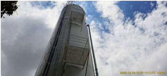
Foto 1 - Tubo extravasor - Reservatório Planalto Serra Verde
