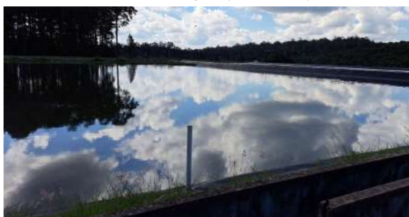
Foto 11 - Vista da primeira lagoa (anaeróbia) - ETE Itirapina
