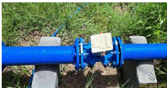
Foto 1 - Macromedidor - Poço Broa
