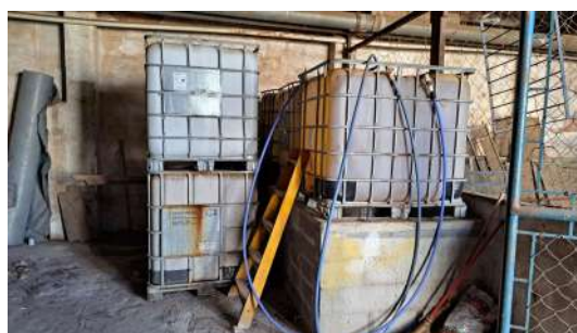
Foto 2 - Estoque inadequado de flúor - DAE Itirapina
