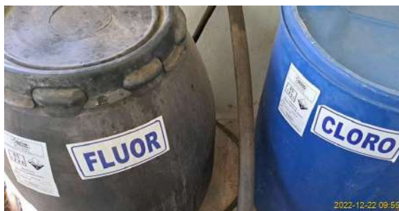
Foto 1 - Bombonas de cloro e flúor no abrigo de químicos - Poço Itaqueri da Serra (Novo)
