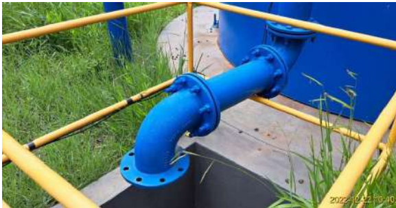
Foto 1 - Tubo extravasor - Reservatório elevado Broa
