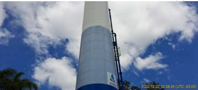
Foto 3 - Vista geral - Reservatório elevado Broa
