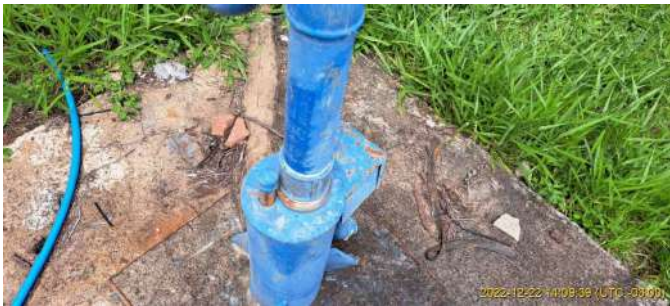
Foto 1 - Tubo para medição de nível - Poço Ubá 2
