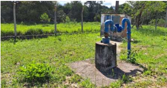
Foto 3 - Vista geral - Poço Ubá 1
