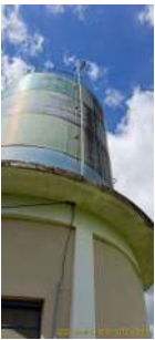
Foto 1 - Para-raios - Reservatório Elevado Ubá 1
