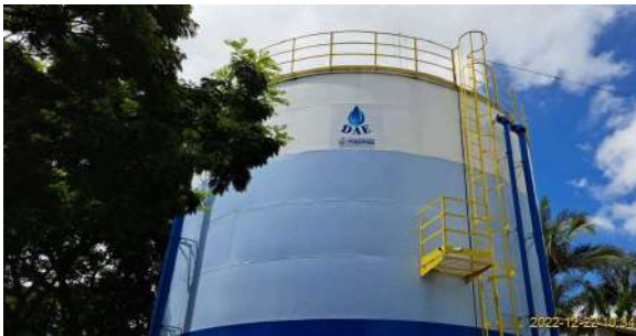
Foto 1 - Vista geral - Reservatório Apoiado Broa
