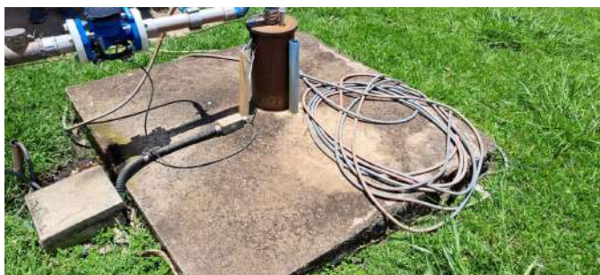
Foto 1 - Laje de proteção - Poço Planalto Serra Verde
