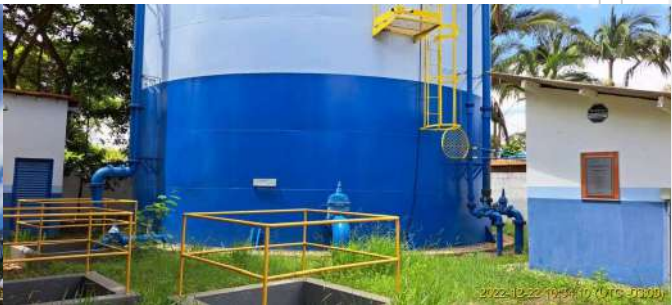
Foto 2 - Vista geral - Reservatório Apoiado Broa
