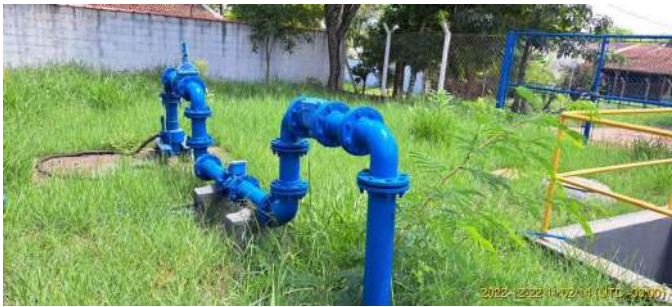
Foto 1 - Vista geral - Poço Broa
