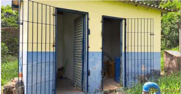
Foto 6 - Abrigo de produtos químicos e bombas dosadoras
