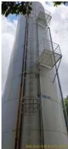
Foto 1 - Guarda-corpos na escada vertical e patamares de descanso
