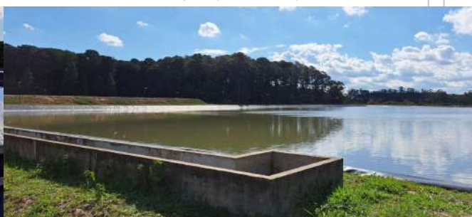
Foto 12 - Vista da primeira lagoa (anaeróbia) - ETE Itirapina
