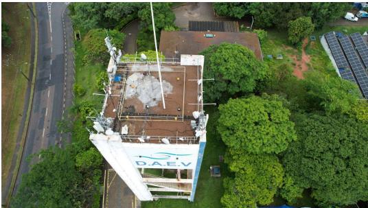
Foto 2 - Reservatório R8 visto de cima
