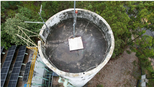
Foto 2 - Reservatório R10 Elevado visto por cima
