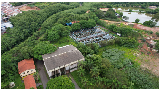
Foto 1 - Visão geral ETE Capuava
