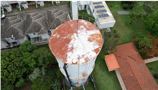
Foto 3 - Reservatório Sllvânia Elevado visto de cima
