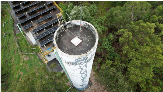
Foto 1 - Visão geral do Reservatório R10 Elevado
