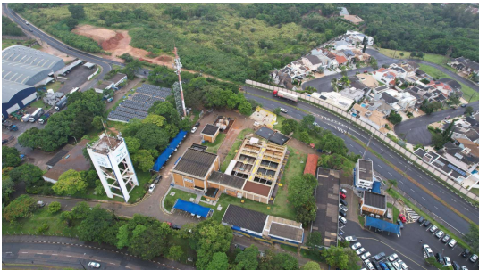
Foto 1 - Visão geral da ETA 2 e Reservatório R8 Elevado
