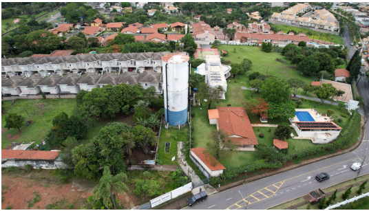
Foto 1 - Reservatório Sllvânia Elevado - visão geral
