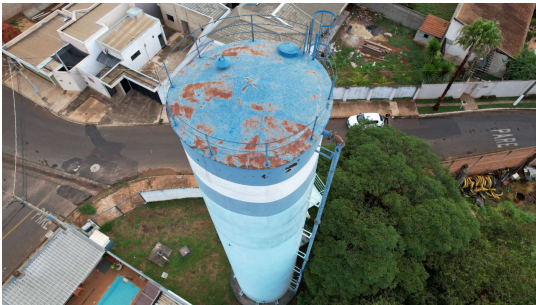
Foto 2 - Vista parte de cima do Elevado Morada Nova
