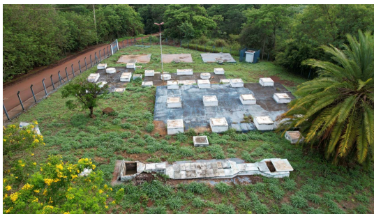
Foto 1 - Visão geral da ETE Córrego Rico
