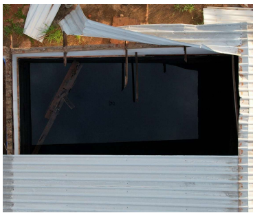
Foto 3 - Enfoque de área descoberta em Reservatório 2,5 milhões manta pead Bairro Alto
