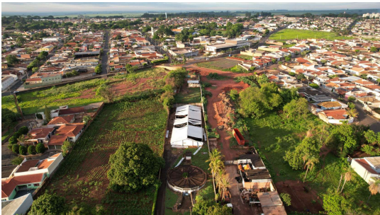
Foto 1 - Visão geral da área Reservatório 2,5 milhões manta pead Bairro Alto
