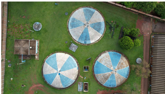
Foto 1 - Visão Aérea Reservatório ETA 5 milhões
