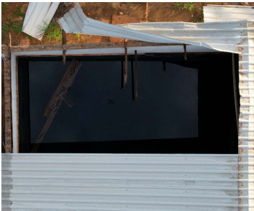
Foto 3 - Enfoque de área descoberta em Reservatório 2,5 milhões manta pead Bairro Alto
