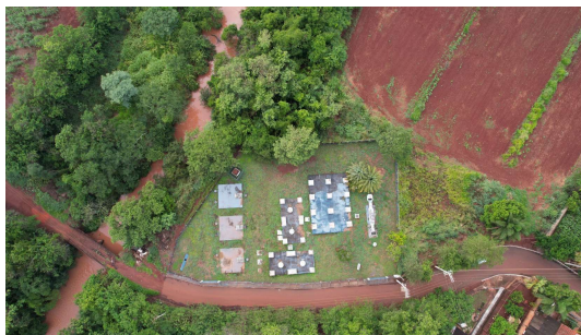
Foto 2 - Visão aérea ampla ETE Córrego Rico
