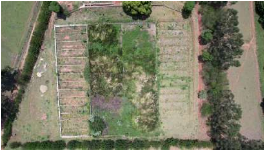
Foto 3 - Vista geral - ETE Guarapuã
