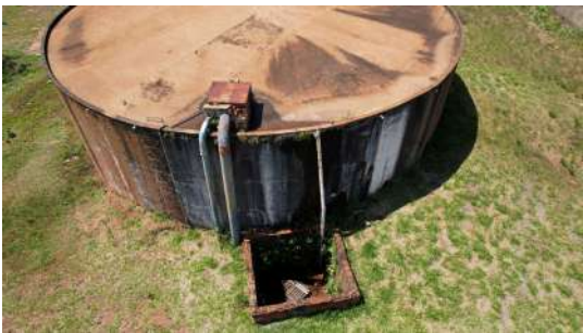
Foto 4 - Vista geral - Reservatório João Viotto 1
