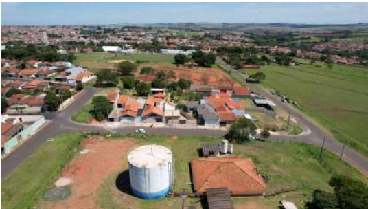
Foto 2 - Vista superior - Reservatório Filipão Velho (direita) e Novo Metálico (esquerda)
