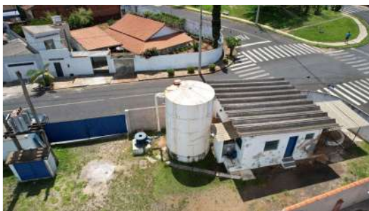
Foto 1 - Vista geral - Reservatório de transição Figueira Branca
