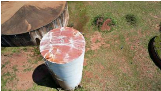
Foto 3 - Vista geral - Reservatório João Viotto 2
