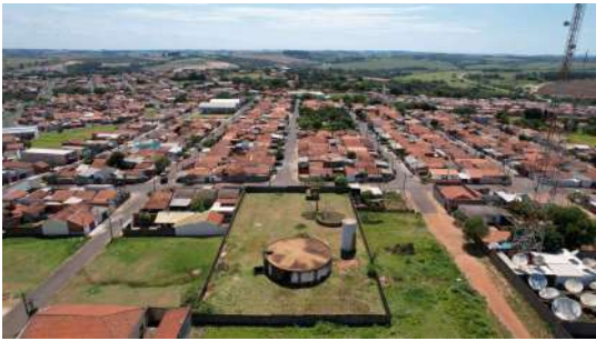
Foto 1 - Vista geral - Reservatórios João Viotto 1 (concreto / apoiado) e João Viotto 2 (elevado metálico)
