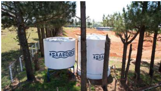
Foto 1 - Vista geral - Reservatórios Ginásio II (direita) e da Balança (esquerda)
