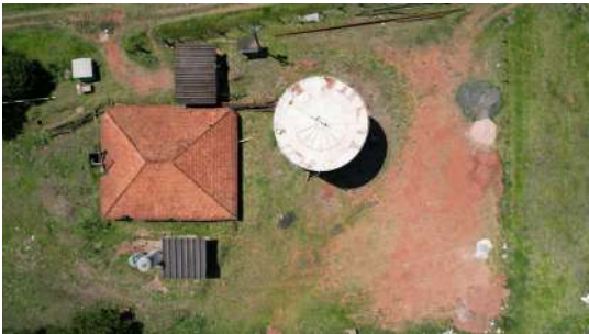
Foto 1 - Vista superior - Reservatório Filipão Velho (esquerda) e Novo Metálico (direita)
