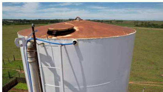
Foto 4 - Tampa de inspeção aberta - Reservatório elevado CDHU
