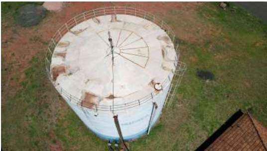
Foto 3 - Vista lateral - Reservatório Filipão Novo
