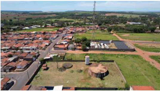
Foto 2 - Vista geral - Reservatórios João Viotto 1 (concreto / apoiado) e João Viotto 2 (elevado metálico)
