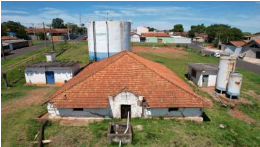
Foto 2 - Reservatório enterrado Filipão Velho a frente e Filipão (metálico) ao fundo
