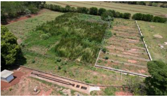
Foto 1 - Vista geral - ETE Guarapuã
