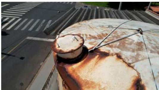
Foto 3 - Vista superior - Reservatório de transição Figueira Branca
