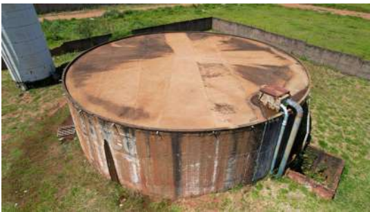
Foto 3 - Vista geral - Reservatório João Viotto 1
