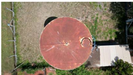
Foto 3 - Vista superior - Reservatório elevado CDHU
