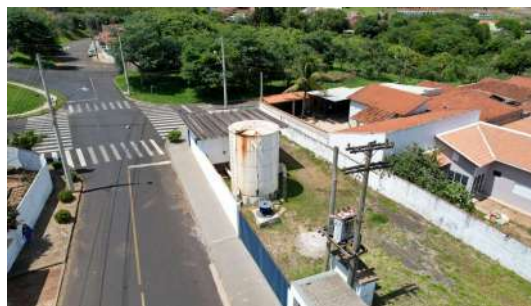
Foto 2 - Vista geral - Reservatório de transição Figueira Branca
