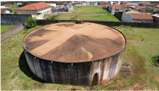
Foto 6 - Vista geral - Reservatório João Viotto 1
