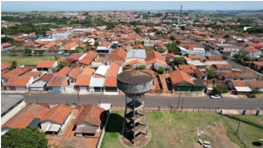
Foto 1 - Vista geral - Reservatório elevado Jd Paulista
