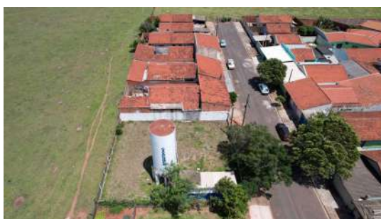
Foto 1 - Vista geral - Reservatório elevado CDHU
