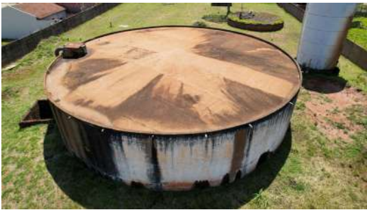
Foto 5 - Vista geral - Reservatório João Viotto 1
