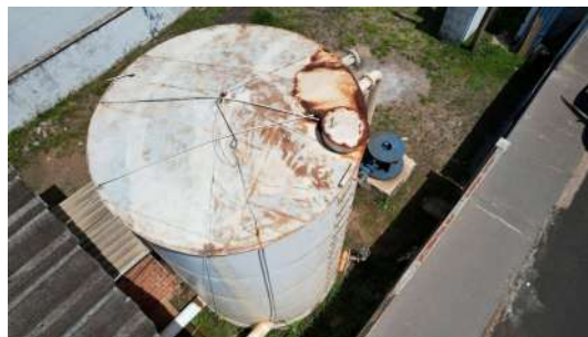
Foto 4 - Vista superior - Reservatório de transição Figueira Branca
