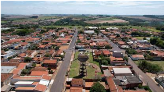
Foto 2 - Vista geral - Reservatório elevado Jd Paulista
