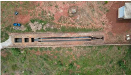
Foto 2 - Chegada de esgoto bruto e tratamento preliminar - ETE Guarapuã
