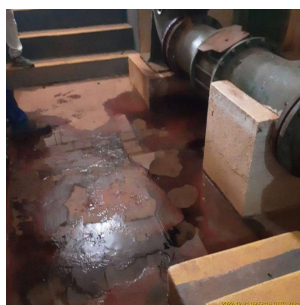
Foto 4 - Vazamento no registro das bombas na Sala de bombas da ETA em Leme
