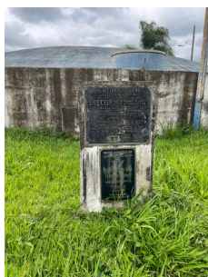
Foto 1 - Identificação dos Reservatórios da ETA em Leme
