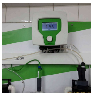
Foto 2 - Medição contínua do parâmetro turbidez na ETA em Leme
