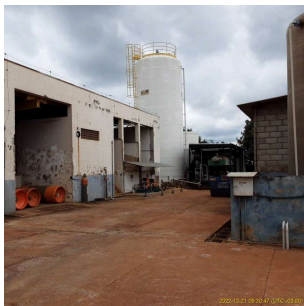
Foto 1 - Vista da entrada da ETA em Leme
