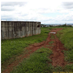
Foto 1 - Tampa de inspeção do Reservatório da ETA em Leme
