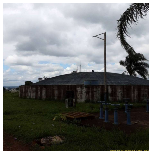
Foto 4 - Vista dos reservatórios da ETA em Leme
