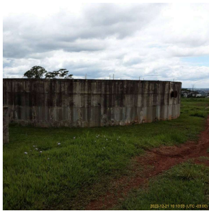
Foto 1 - Tubulações de ventilação no Reservatório da ETA em Leme
