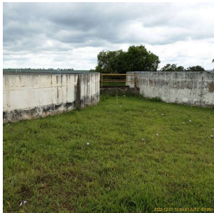
Foto 1 - Vista dos reservatórios da ETA em Leme
