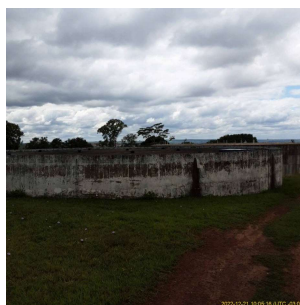
Foto 2 - Vista dos reservatórios da ETA em Leme
