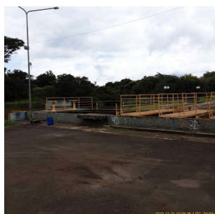
Foto 3 - Vista da captação do Ribeirão do Roque em Leme
