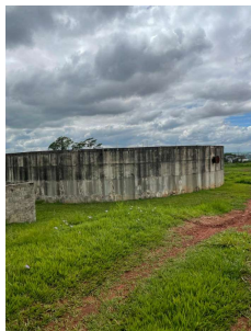
Foto 1 - Vista do Reservatório 3000 na ETA de Leme
