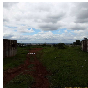
Foto 2 - Vista dos reservatórios da ETA em Leme
