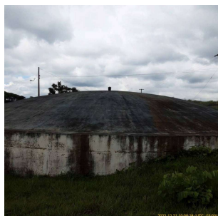
Foto 3 - Vista dos reservatórios da ETA em Leme
