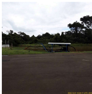
Foto 2 - Vista da captação do Ribeirão do Roque em Leme
