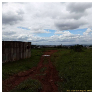
Foto 1 - Reservatórios da ETA em Leme sem cercamento
