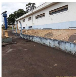
Foto 4 - Vista da captação do Ribeirão do Roque em Leme
