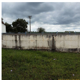
Foto 1 - Vista dos reservatórios da ETA em Leme
