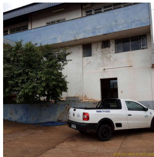
Foto 2 - Vista da entrada da ETA em Leme
