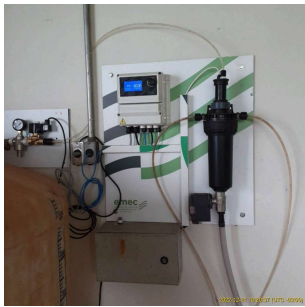
Foto 1 - Monitoramento contínuo de parâmetros na Captação do Ribeirão do Roque em Leme
