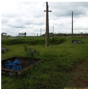
Foto 1 - Vista dos reservatórios da ETA em Leme
