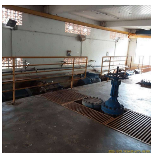
Foto 1 - Guarda-corpos da Captação do Ribeirão do Roque em Leme
