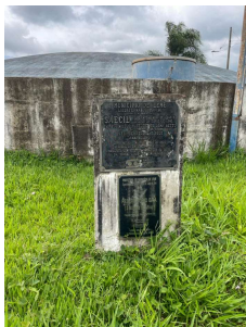
Foto 1 - Vista dos reservatórios da ETA em Leme
