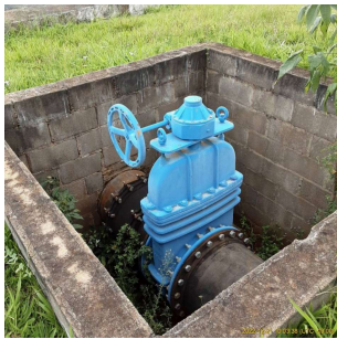
Foto 1 - Vista dos reservatórios da ETA em Leme
