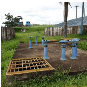
Foto 1 - Vista dos Reservatórios da ETA em Leme
